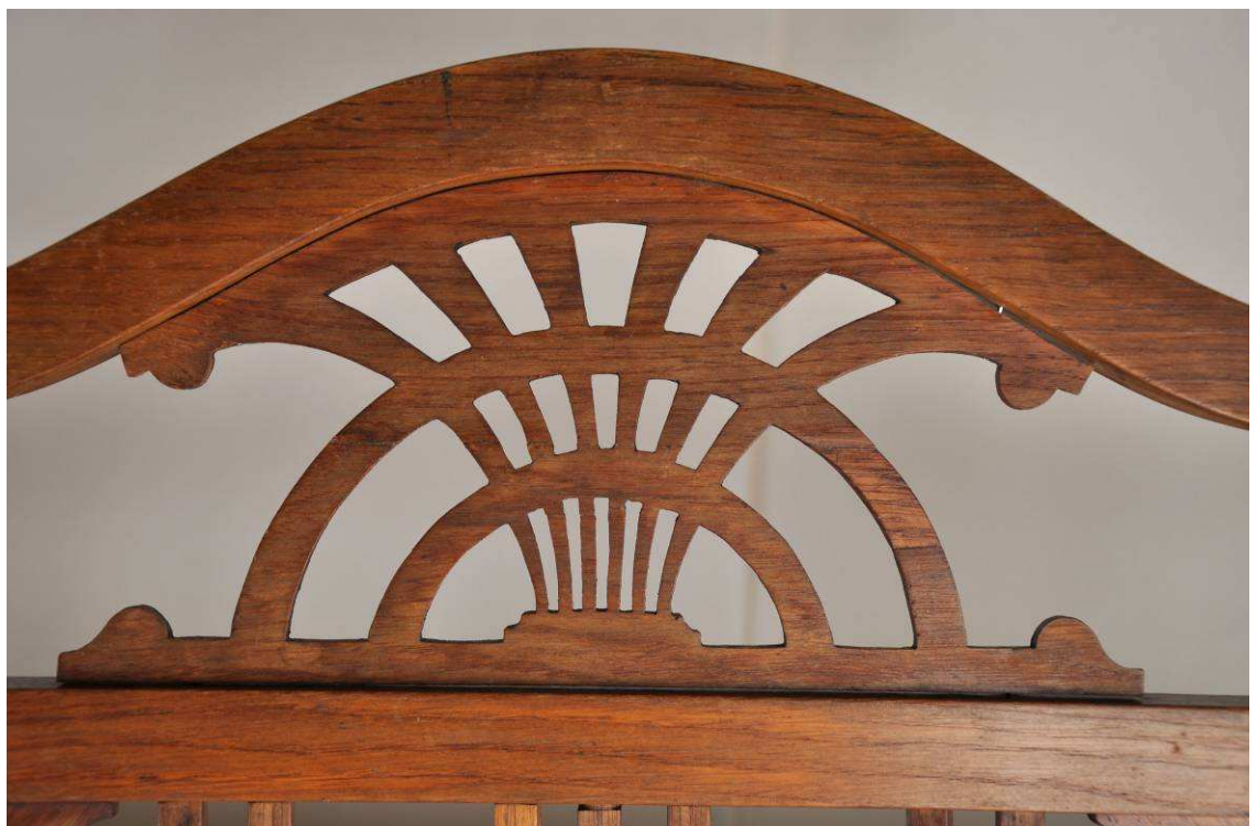
Obr. 58 Stav po restaurování, detail zdobného prvku dřevěné konstrukce.
