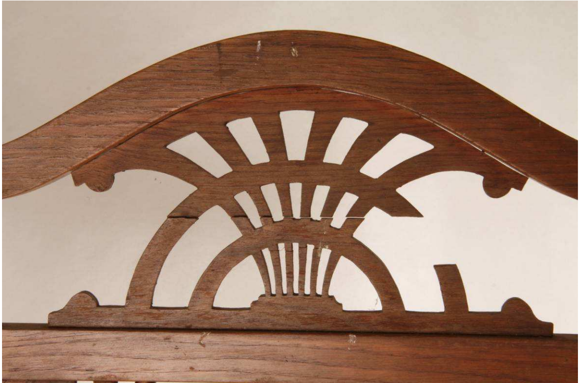
Obr. 57 Stav před restaurováním, detail poškození zdobného prvku dřevěné konstrukce.
