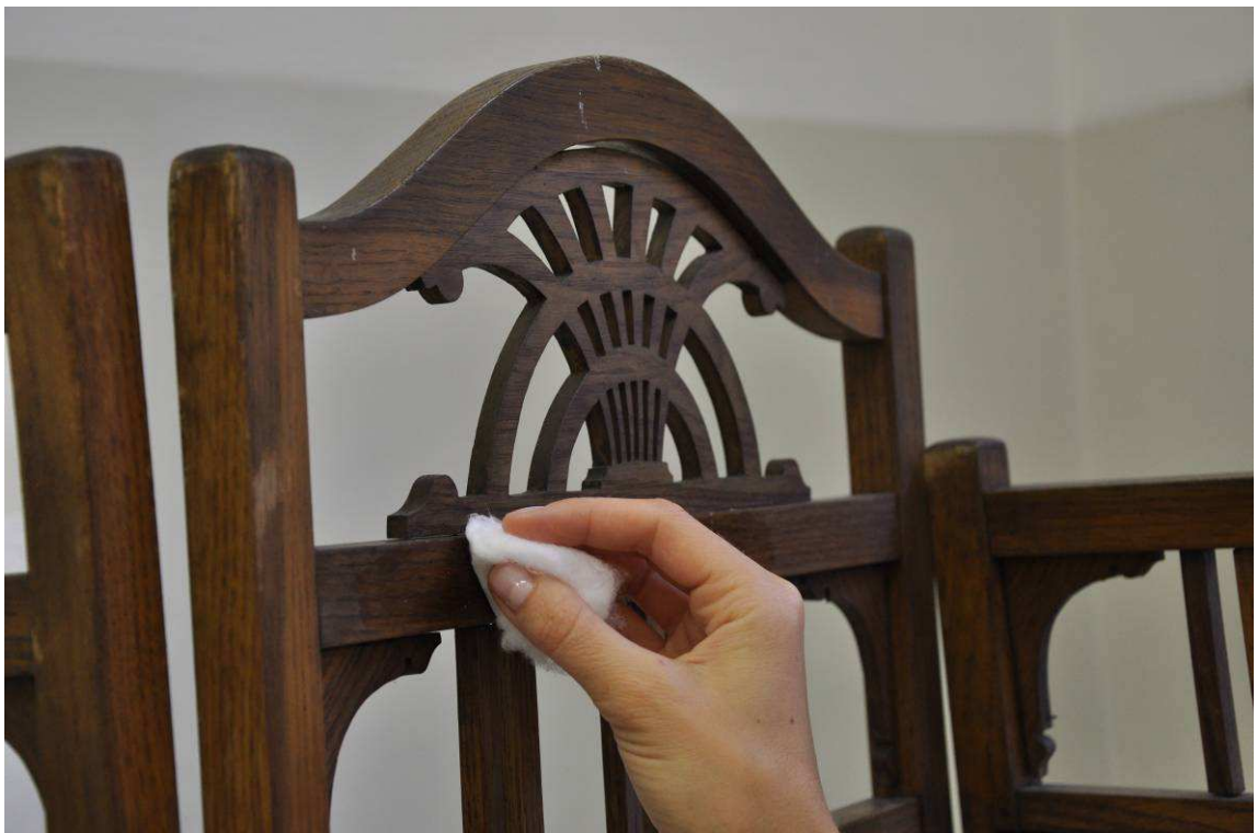
Obr. 84 Průběh restaurování, čištění dřevěné konstrukce vatovými tampony navlhčenými v destilované vodě.
