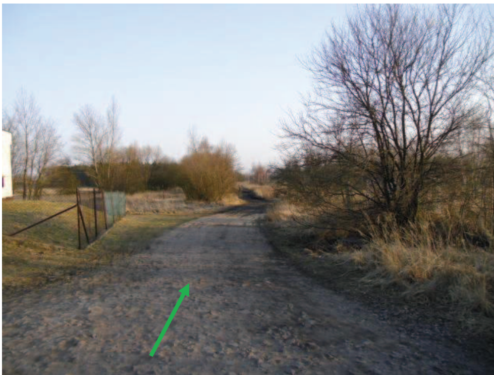
Obrázek č. 2 Stávající stav v místě 0,04km nové trasy; pohled od severozápadu.
