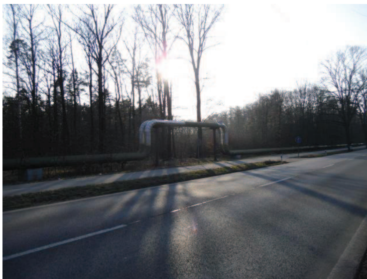
Obrázek č. 1 Příklad přeložky horkovodu, vytvoření tzv. mostu.
