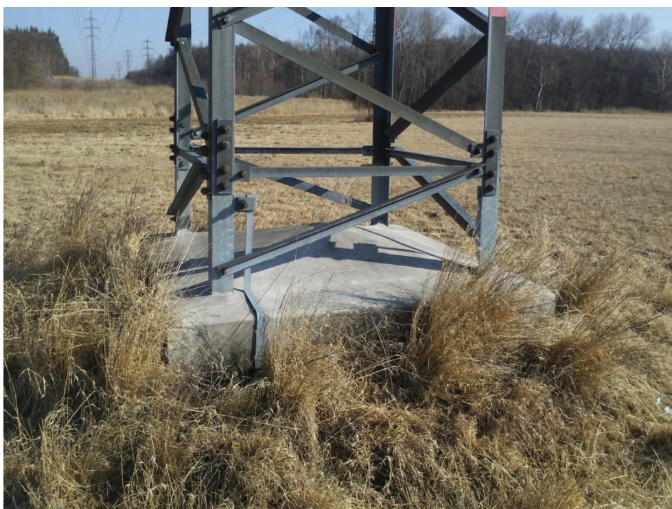
Obrázek č. 6 Stávající vysoké napětí vedené v souběhu s plánovanou trasou C.
