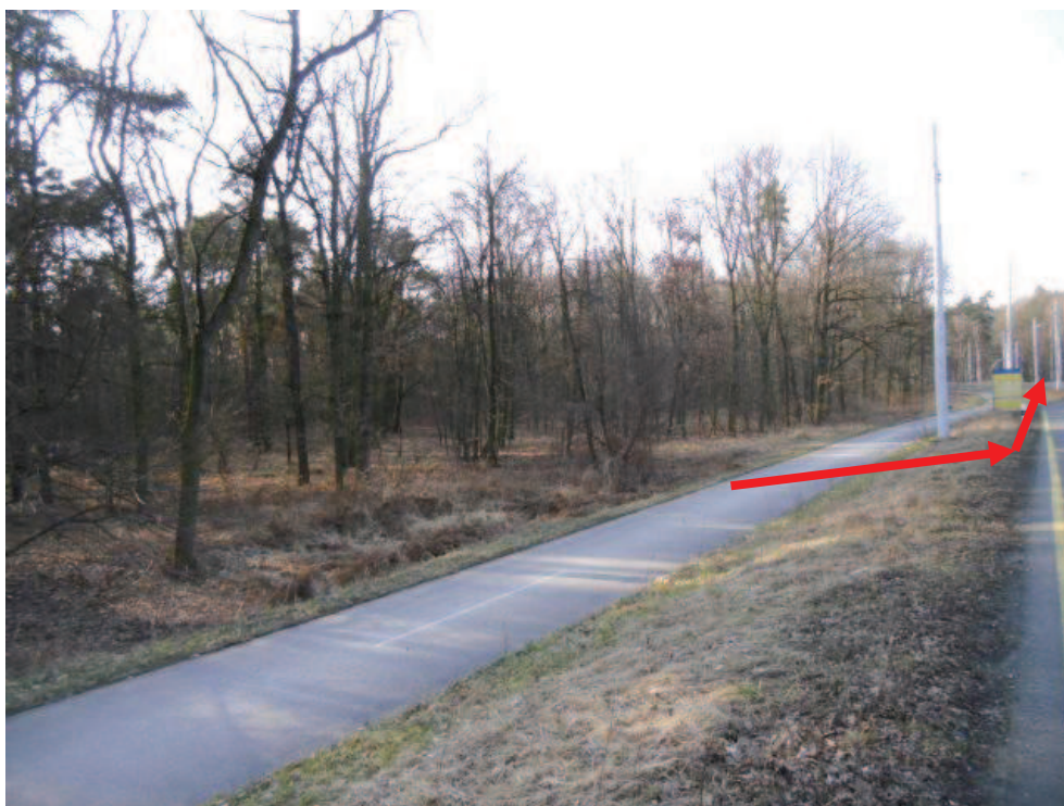
Obrázek č. 8 Stávající stav - pohled směr Lázně Bohdaneč v místě napojení budoucí Trasy B; KÚ 1,684km; pohled od jihovýchodu.
