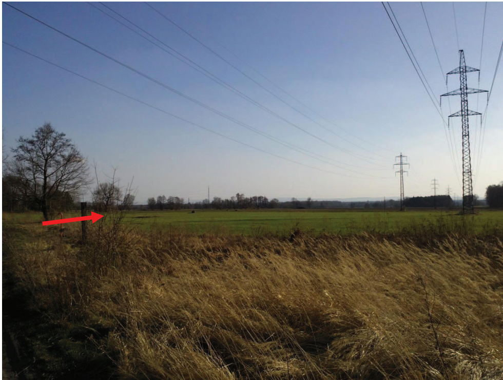
Obrázek č. 5 Stávající stav v místě cca 0,280 km nové trasy A; pohled od severu.
