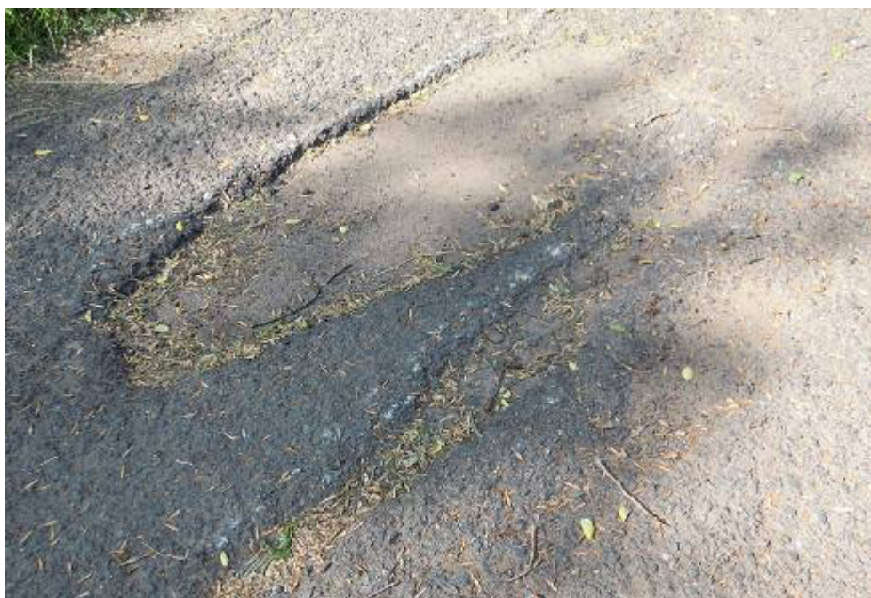
Obr. 2: Díry v povrchu stezky (Autor)
