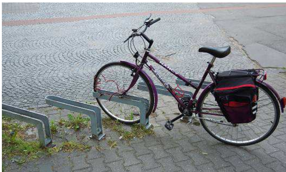
Obr. č. 38 Nevhodný stojan (Autor)
