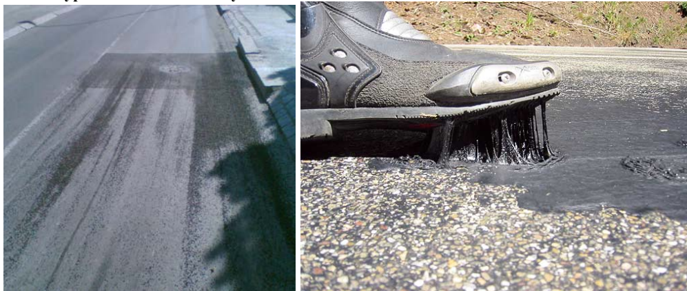
Obrázek č. 36: Zасыпání štěrkem a rozteklý asfalt
