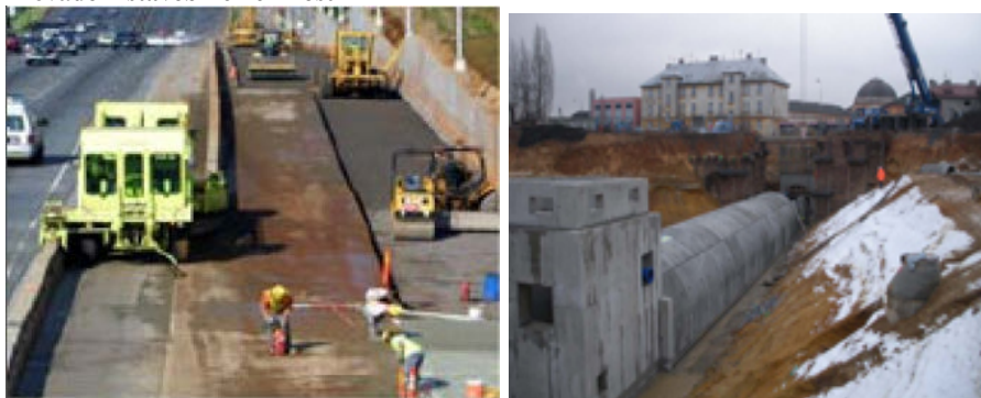
Obrázek č. 50: Provádění stavebních činností
