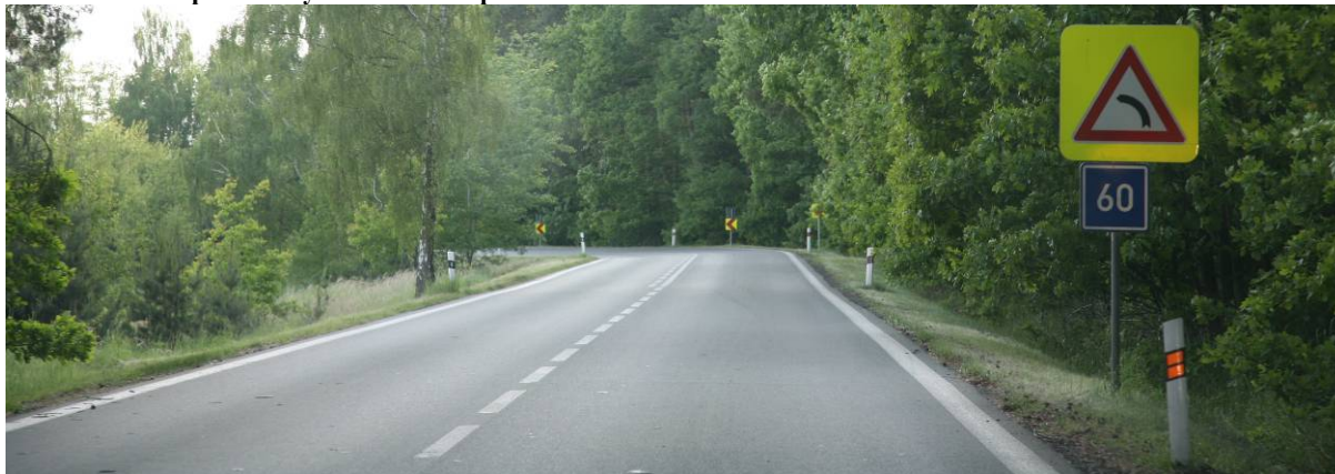
Obrázek č. 54: Správně zvýrazněná nebezpečná zatáčka
