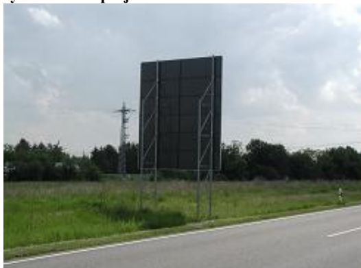
Obrázek č. 59: Příhradové podpěry s možností přejetí
