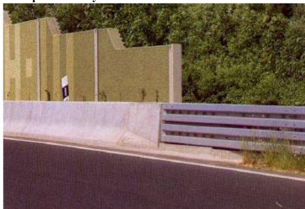
Obrázek č. 57: Správné zakončení protihlukových stěn
