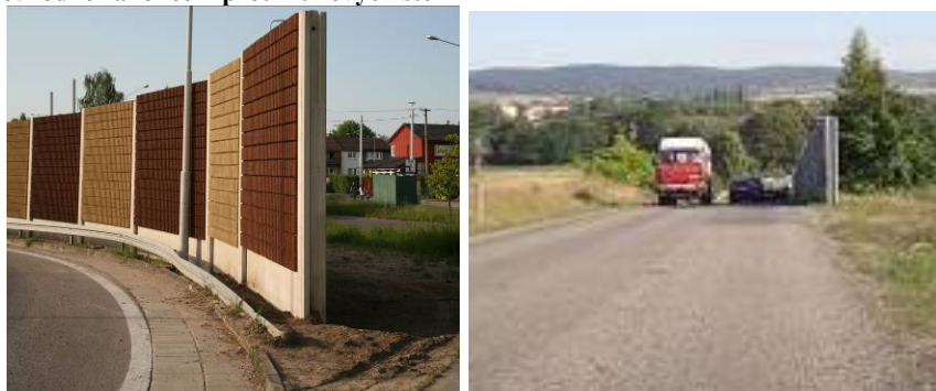
Obrázek č. 48: Nevhodné zakončení protihlukových stěn
