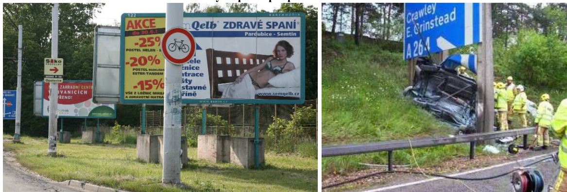
Obrázek č. 47: Nevhodně umístěné billboardy a špatné podpěrné konstrukce značek
