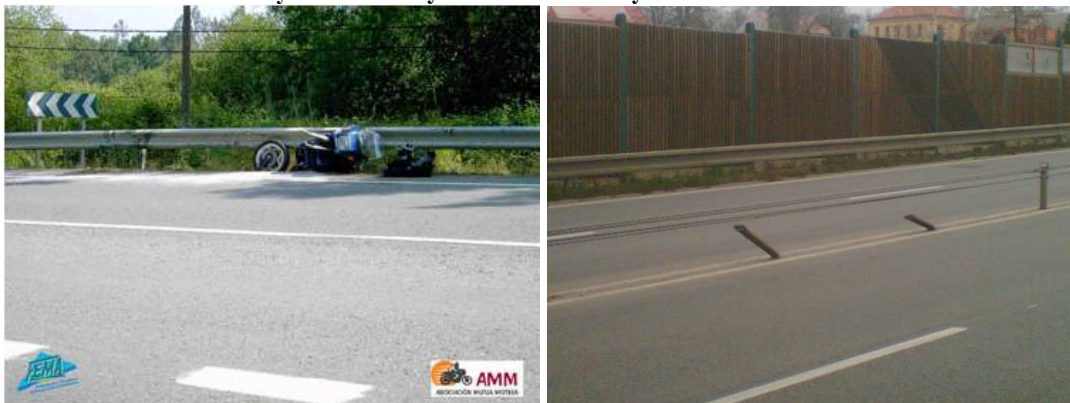
Obrázek č. 49: Sřet řidiče motocyklu se svodidly a ukázka nevhodných svodidel
