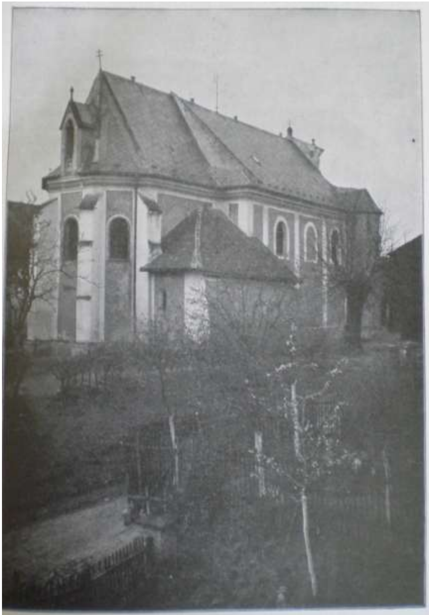
Foto 5 (farní kostel ve Vejvanovicích)
