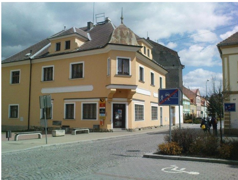
Obr. 12: Kritické místo přechodu chodců u budovy pošty
