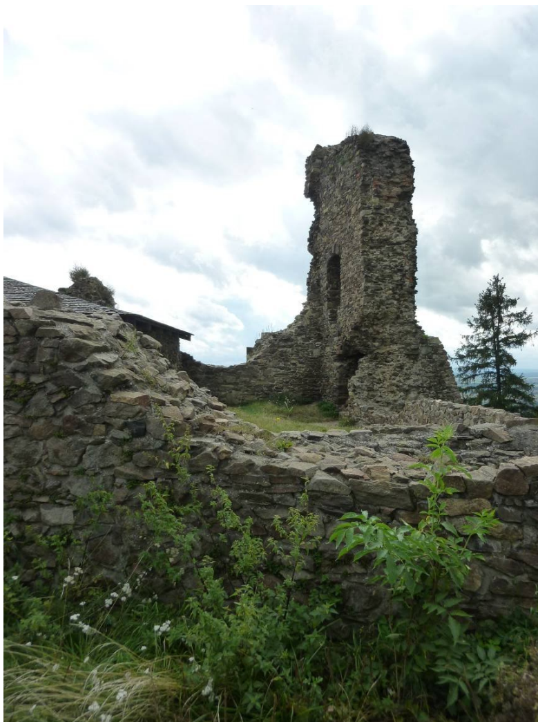
Obr. 53. Pozůstatky paláce v severozápadním nároží
