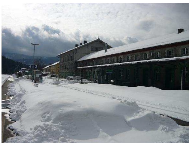
Obr. 17: Staniční budova Bayerisch Eisenstein
