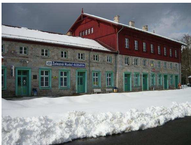
Obr. 16: Staniční budova Železná Ruda-Alžbětín
