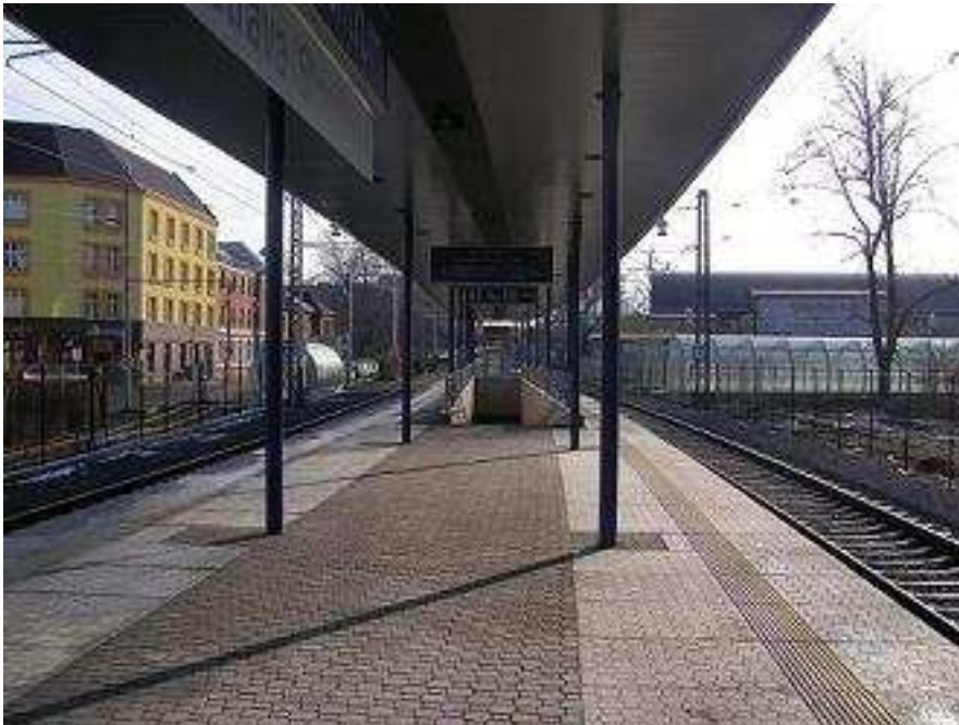
Obr. 46: Železniční zastávka Ostrava-Stodolní, žlutý dům vlevo roh Stodolní ulice
