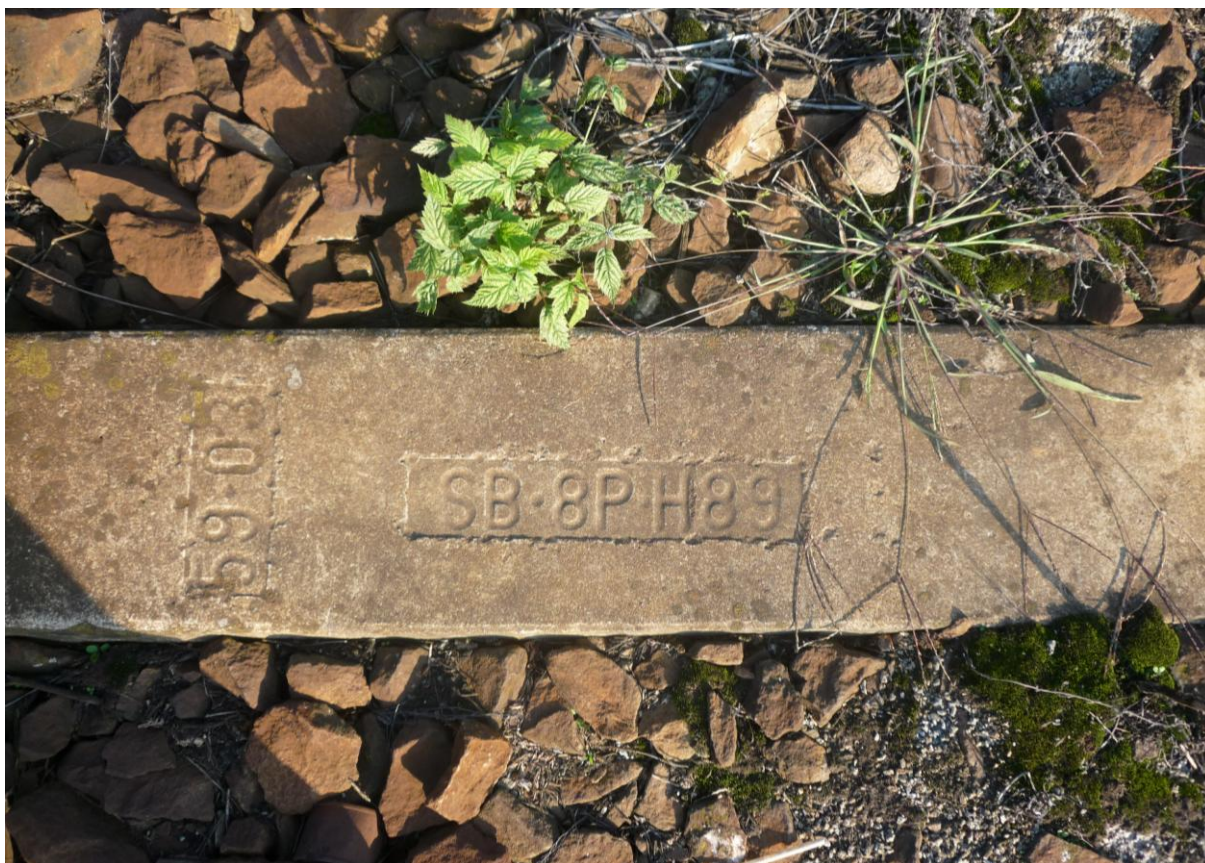
Obr.5 Způsob označení betonového pražce.
