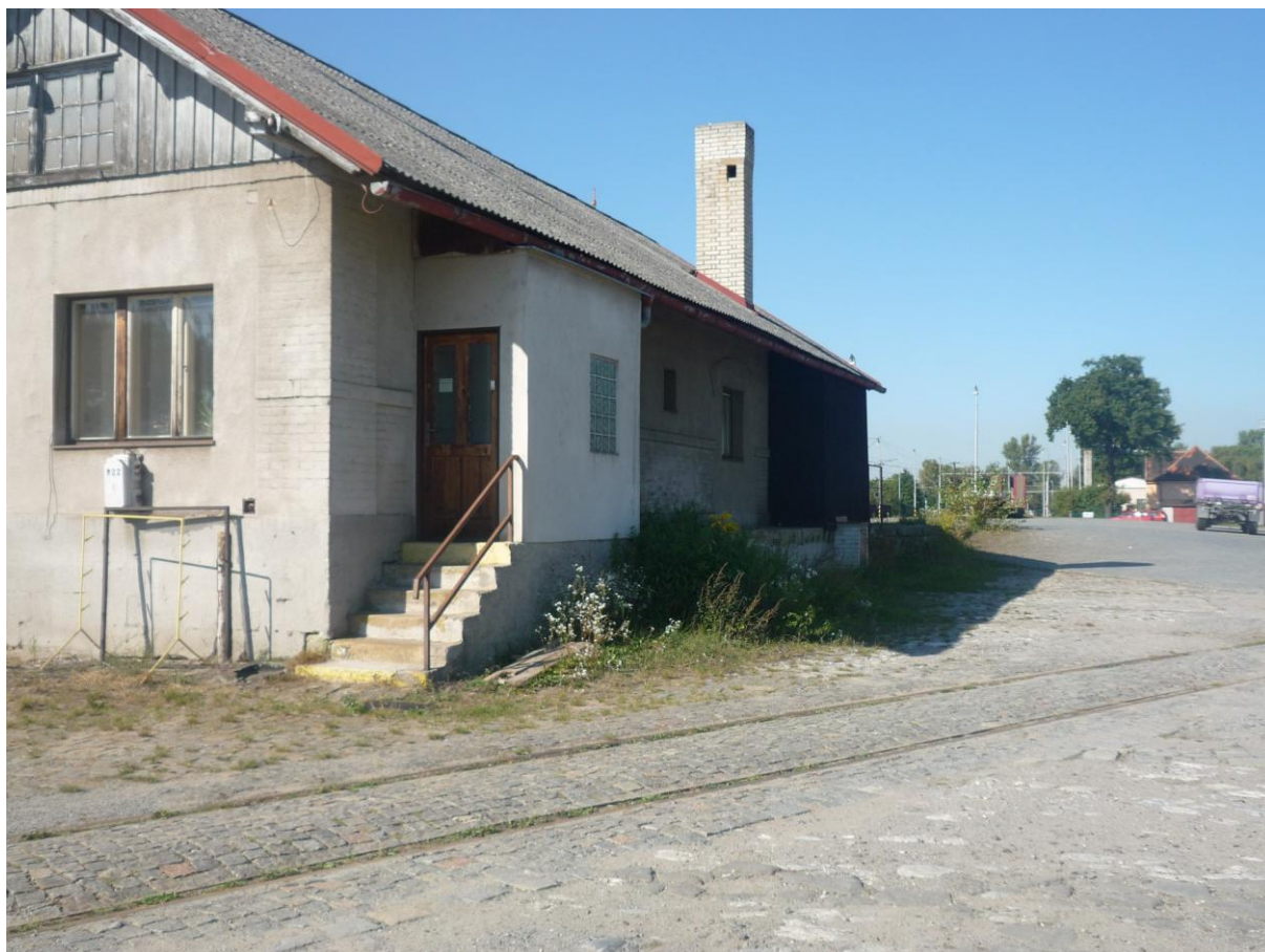
Obr.18 Budova voz. a přepr. služby, pozvolný nájezd na rampu za ní, torzo kolejí, která byla zřejmě dříve zapojena do koleje č. 4.
