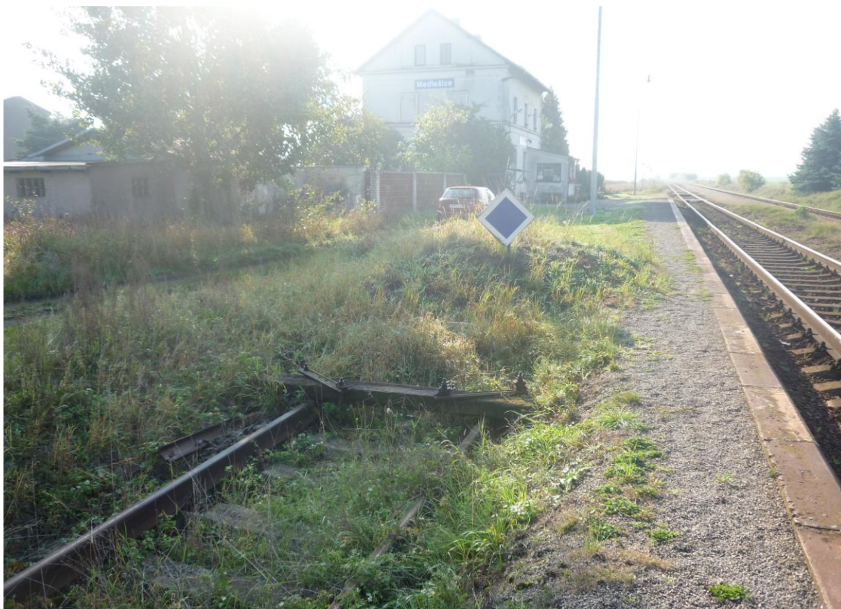
Obr.8 Způsob zakončení manipulační koleje č. 2.
