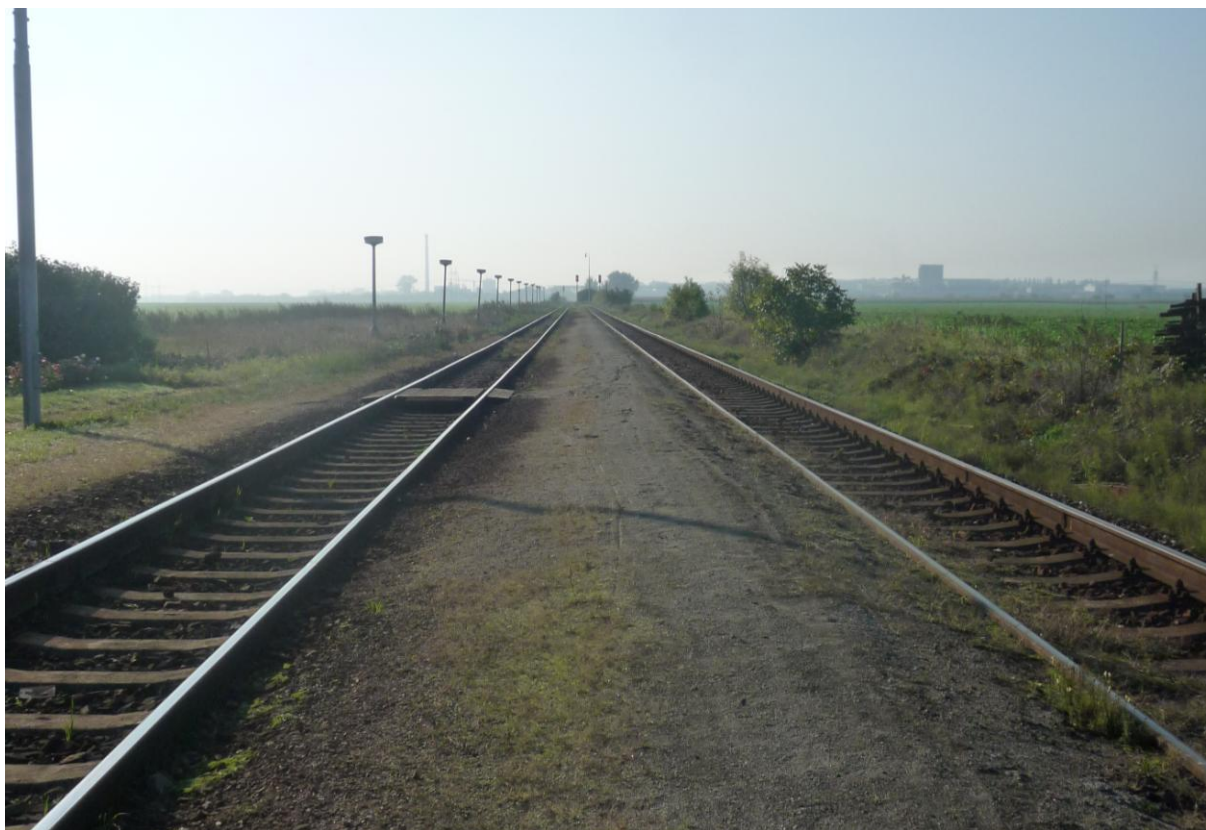
Obr.3 Pohled k začátku chrudimského zhlaví ze sypaného nástupiště č. 2, vlevo hlavní dopravní kolej č. 1 a přechod přes ní, vpravo předjízdna kolej č. 3.
