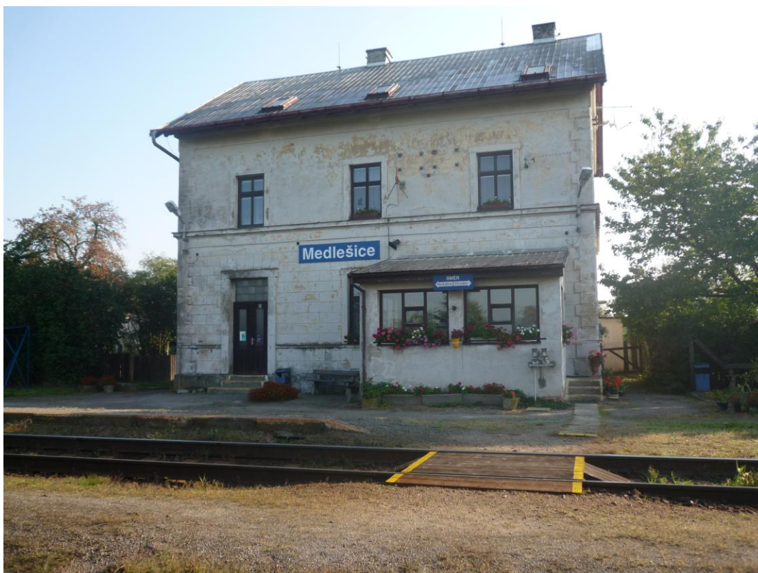
Obr.1 Pohled na výpravní budovu a čekárnu z kolejiště.
