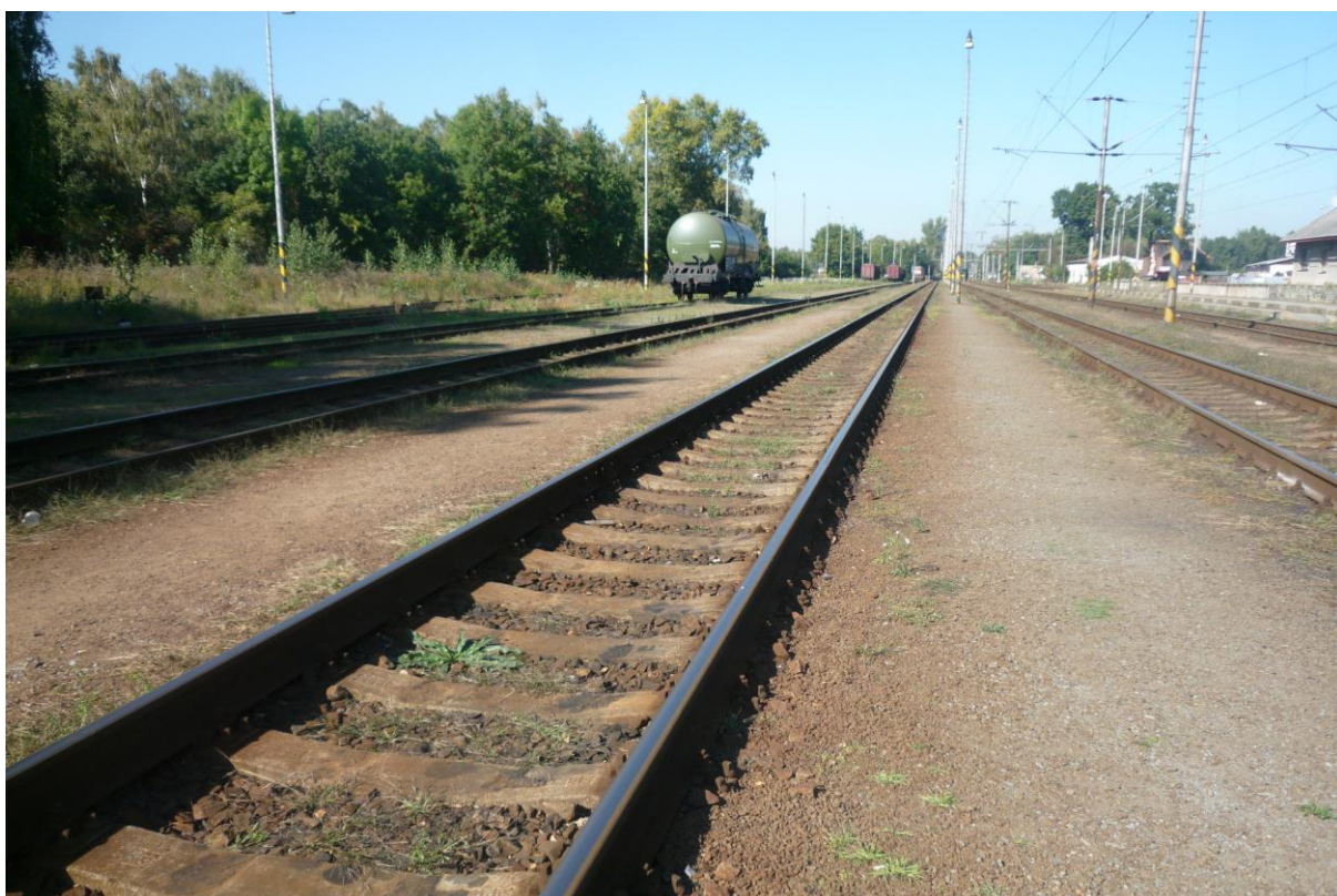
Obr.15 Pohled na manipulační koleje, v levé části jsou vidět elektrifikované dopravní koleje.
