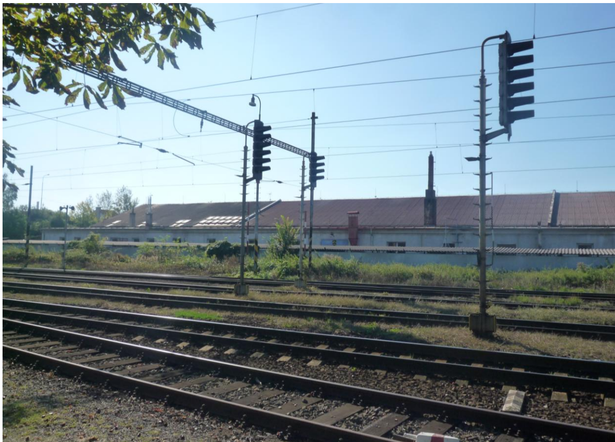
Obr.22 Pohled na odjezdová návěstidla v medlešickém zhlaví.
