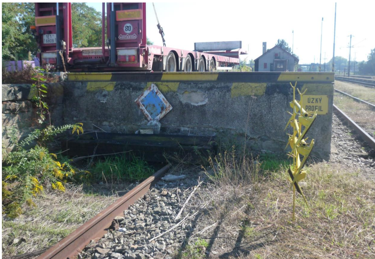
Obr.20 Čelní rampa přístupná z manipulační koleje č. 6.
