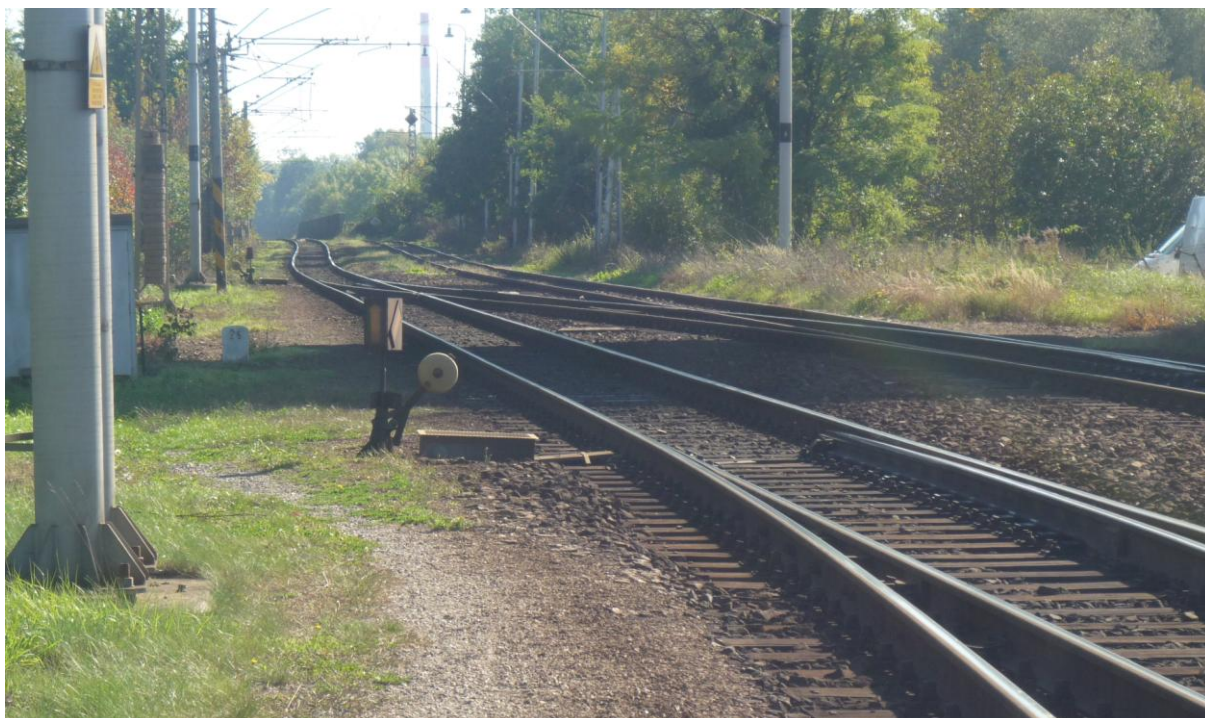
Obr.24 Pohled na začátek zhlaví medlešického, v pozadí ocelový most.
