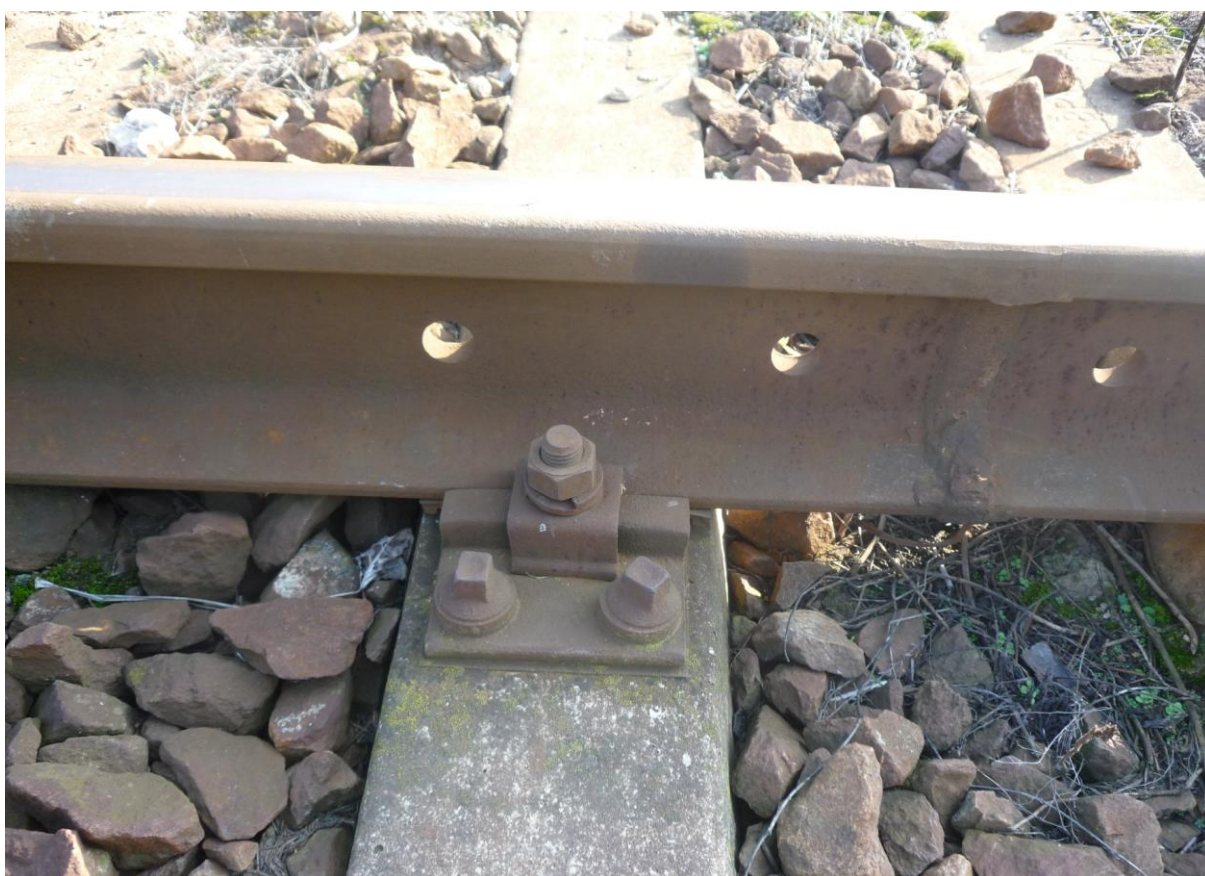
Obr.6 Detail změny spoje na bezstykový v koleji č. 1.
