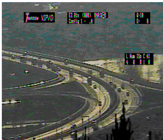
Obr.225 MÚK most Barikádníků snímek - 4 [Zdroj autor DP]
