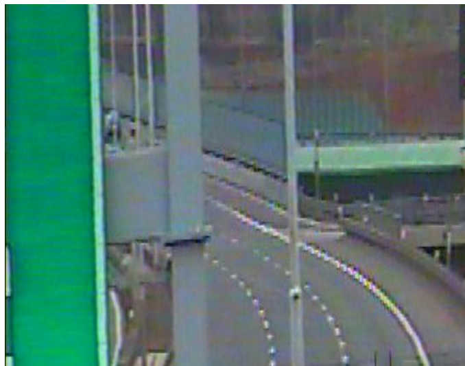
Obr. 91 MÚK Karlovarská – snímek 3 [Zdroj autor DP]
