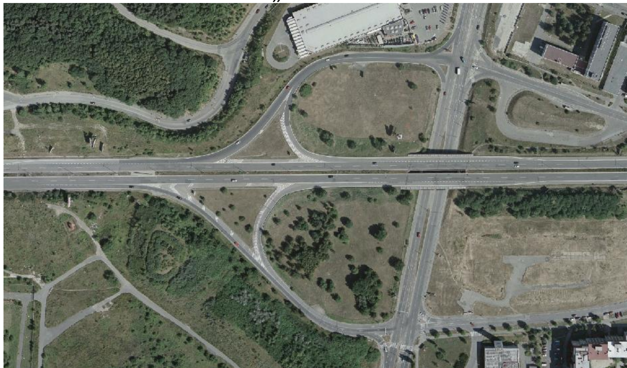
Obr.314 Exit Rozvadovská spojka [Zdroj zakoupena licence k užití pro DP]
