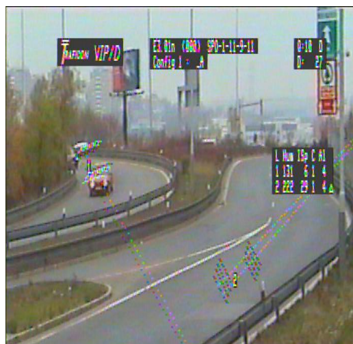
Obr. 200 MÚK Chodovská – Spořilovská snímek 2 [Zdroj autor DP]
