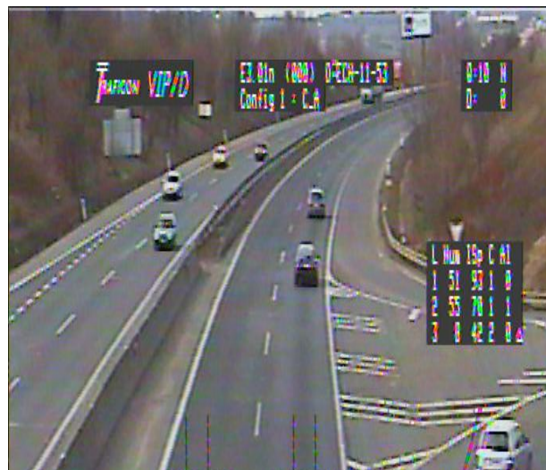
Obr. 3.67 MÚK exit Ořech – snímek 1 [Zdroj autor DP]
