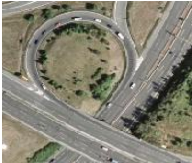
Obr. 3.61 MÚK exit Roztyly – letecký snímek [Zdroj letecký snímek – zakoupena licence]
