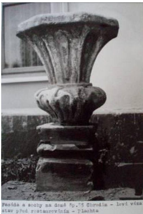
Obr. 114. Fasáda a sochy na domě č. p. 55 Chrudim – levá váza, stav před restaurováním – Plachta Restaurováno v roce 1986. Vázy stojí po stranách niky v průčelí Wiesnerovy vily.
