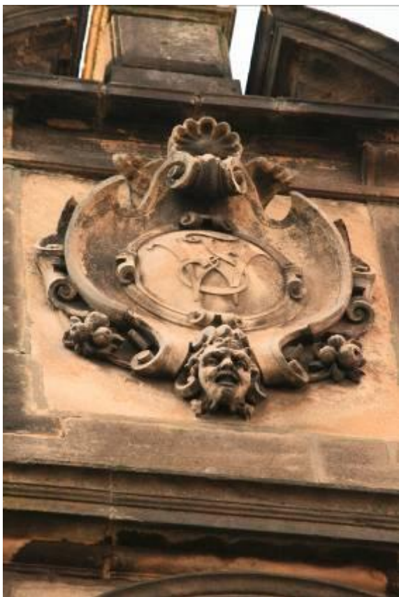
Obr. 1. Kartuš s iniciálami FW investora Františka Wiesnera. Kartuš je vytvořena patrně z tzv. Kufštajnu - materiálu obsahující vápenec bohatý na jílové částice, který se těžil v Tyrolsku hojně užívaný na stavbách v 19. století. Kartuš je umístěna na ose kamenného štítu pod místem, kde stávala socha štěstěny. /foto Zdeněk Šmahel, 2011/
