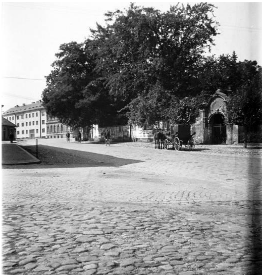
Obr. 24. Brány Wiesnerovy zahrady na Jánském předměstí. Zbořeny v důsledku rozšíření vozovky v 50. letech 20. stol. Foto Karel Sokol 1949.
