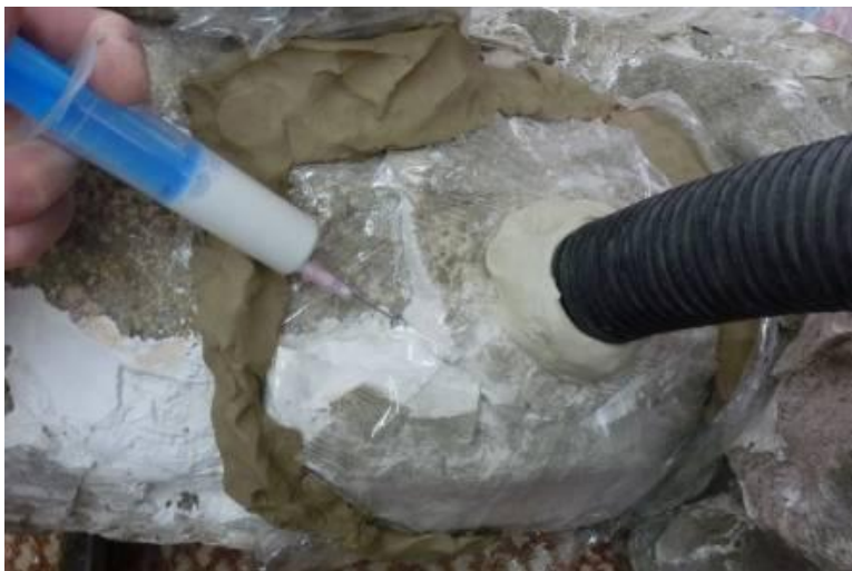
Obr. 63 Zkouška zajištění dutých míst pomocí podtlakové injektáže
