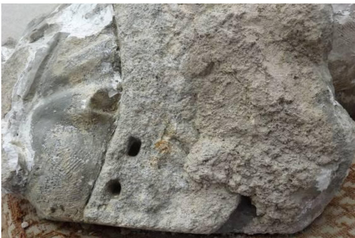
Obr. 71 průběh restaurování – horní část anděla, průběh snímání malty zaslepující povrch sádrových doplňků i kamene.
