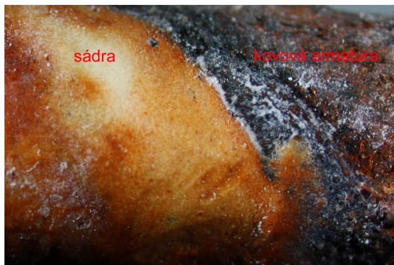
Obr. 111 detail pronikání rzi do sádrové hmoty
