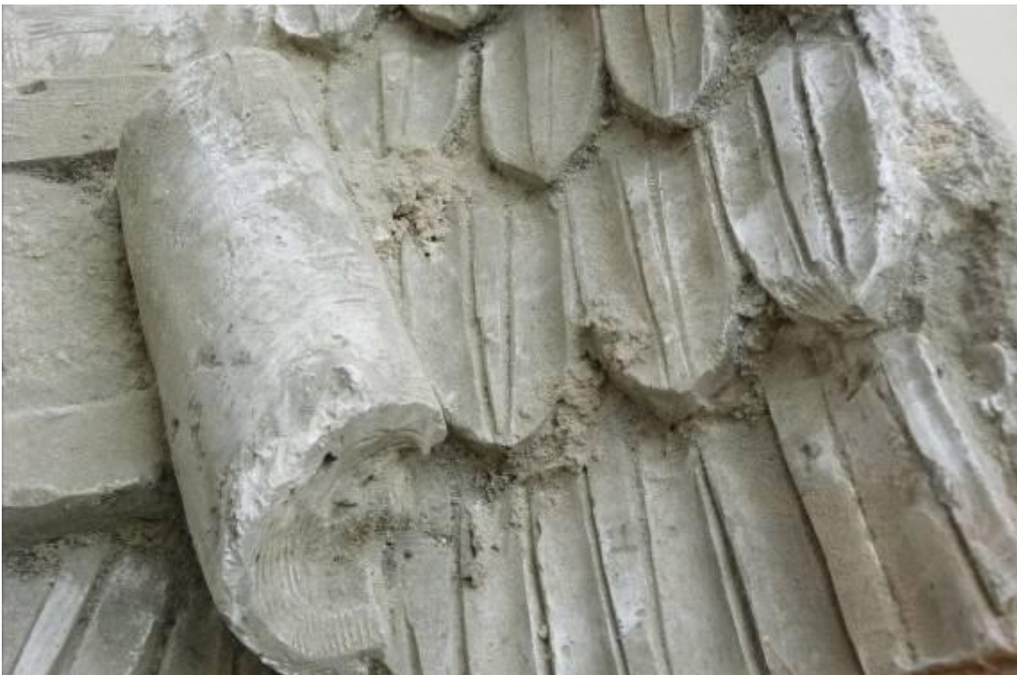
Obr. 69 stav před restaurováním – detail sádrové modelace na křídle anděla
