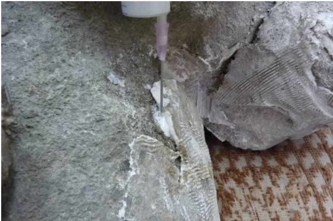
Obr. 80 průběh restaurování – injektáž uvolněných sádrových doplňků pomocí ledanu
