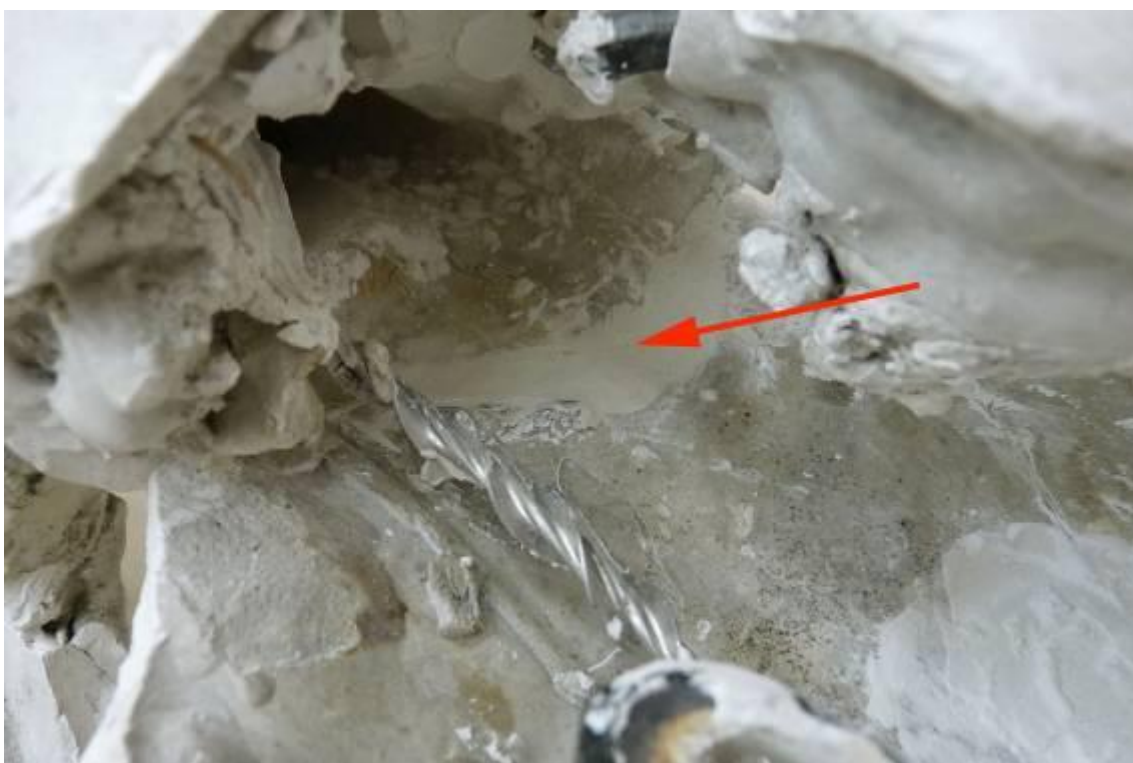
Obr. 38 průběh restaurování - zajištění namáhaného lepeného spoje doplněním sádrové hmoty v lepeném spoji
