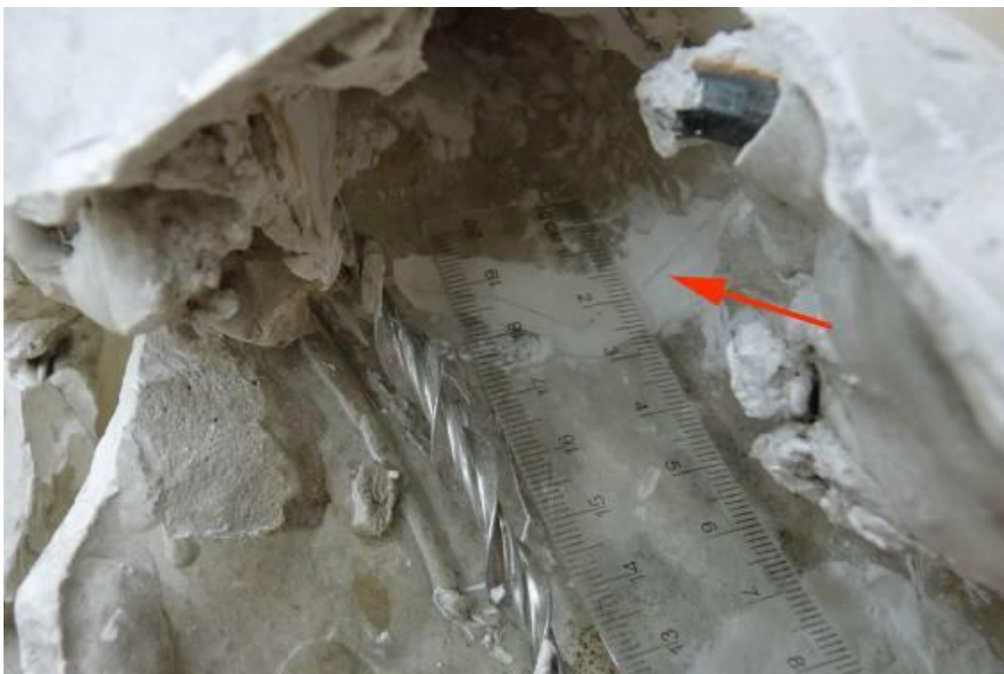
Obr. 37 průběh restaurování – průběh zajištění namáhaného lepeného spoje – odebrání materiálu v lepeném spoji
