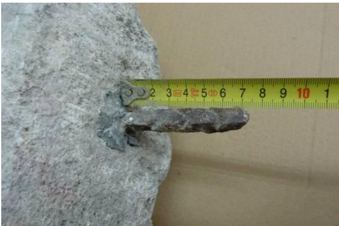
Obr. 81 průběh restaurování – původní dochovaný čep na pravém křídle byl antikorozně ošetřen a ponechán
