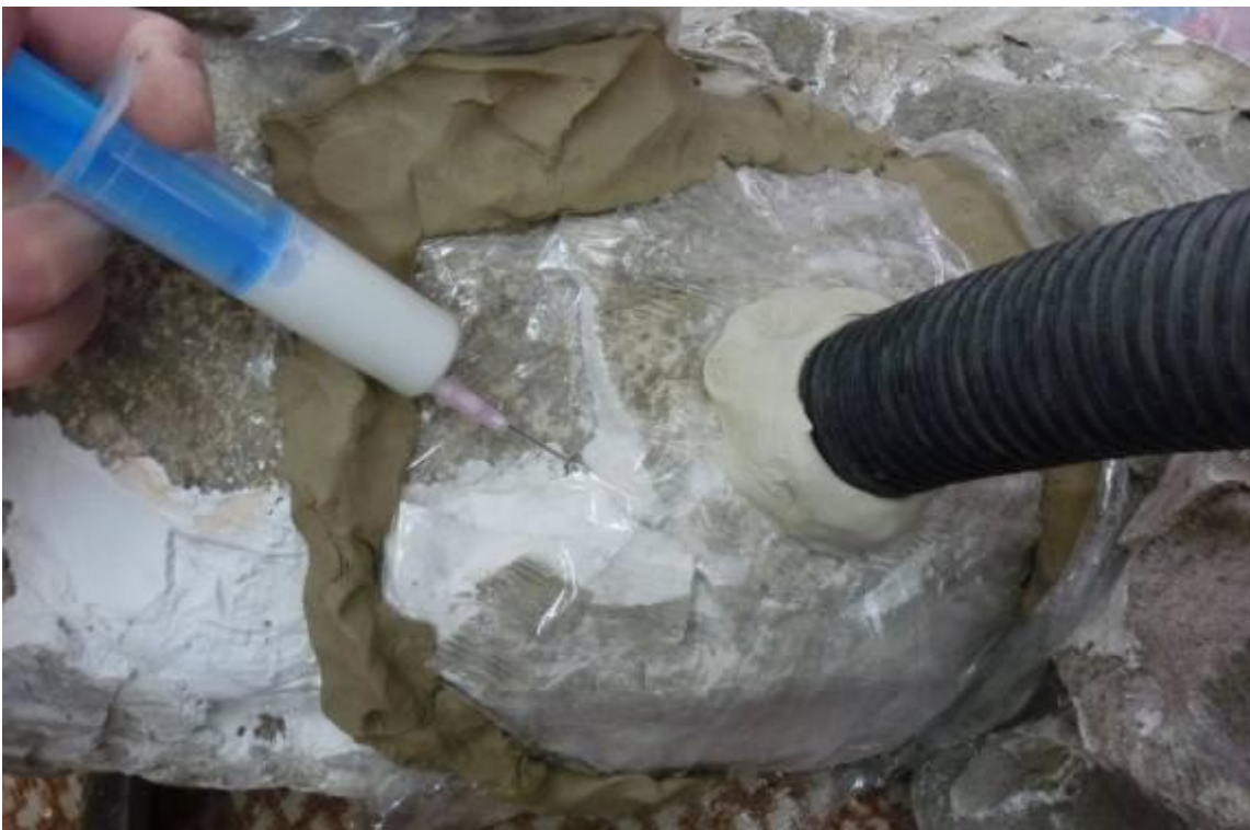
Obr. 83 průběh restaurování – detail zajištění pomocí tlakové injektáže
