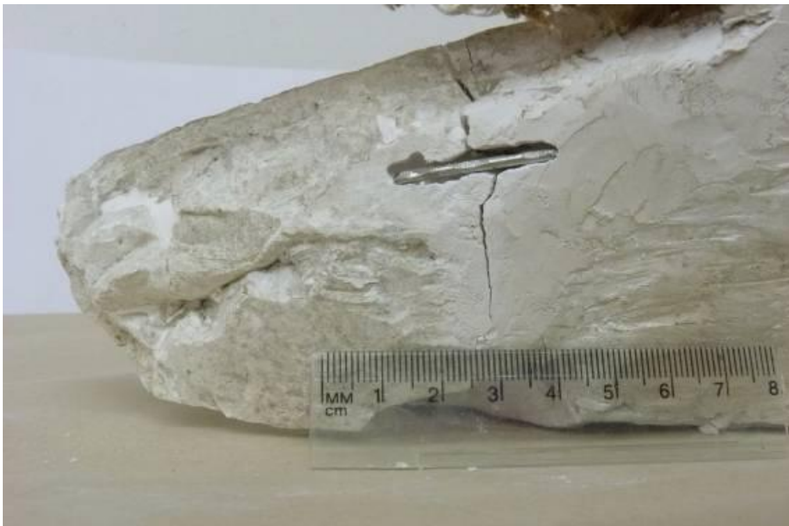
Obr. 30 průběh restaurování – zajištění praskliny nerezovou armaturou
