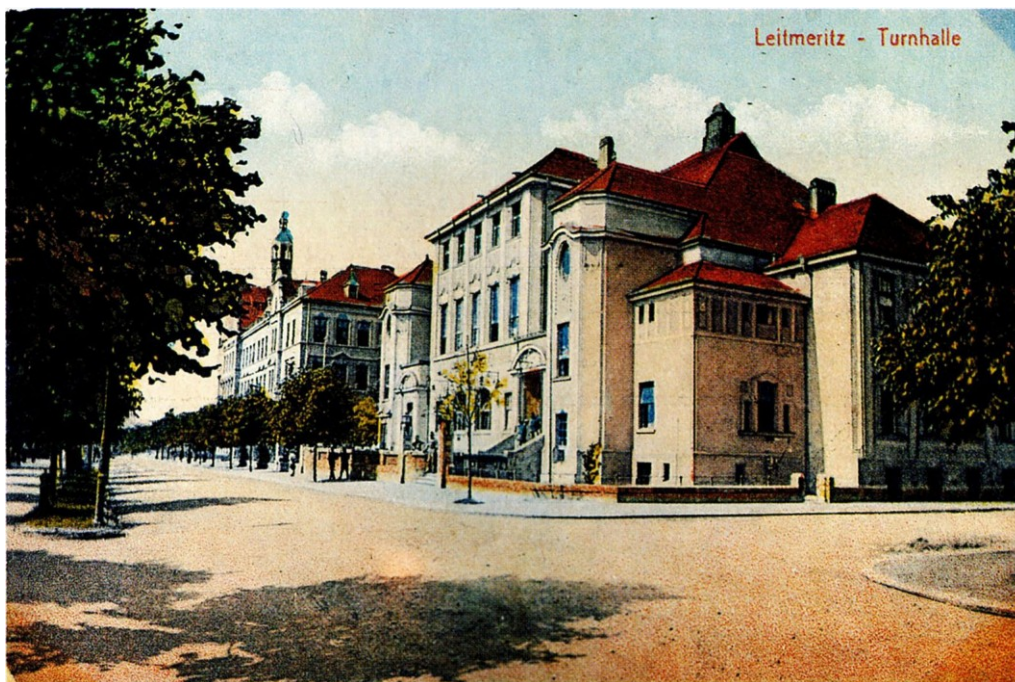
Obr. č. 39 – Turnhalle
