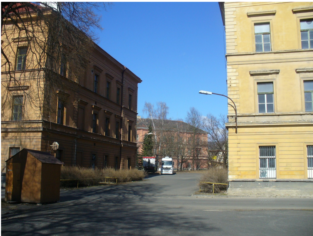
Obr. č. 35 – současný pohled směrem do prostoru bývalých kasáren
