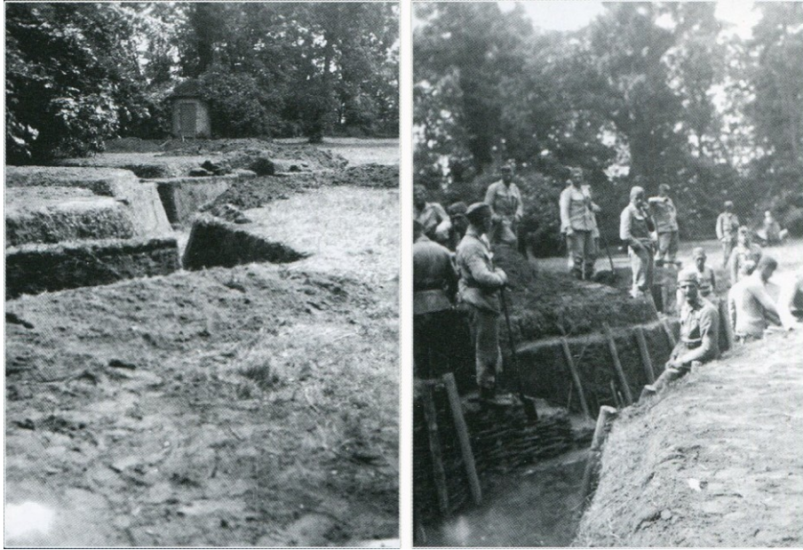
Obr. č. 45 – budování zákopů na Štřeleckém ostrově pro divadelní představení
