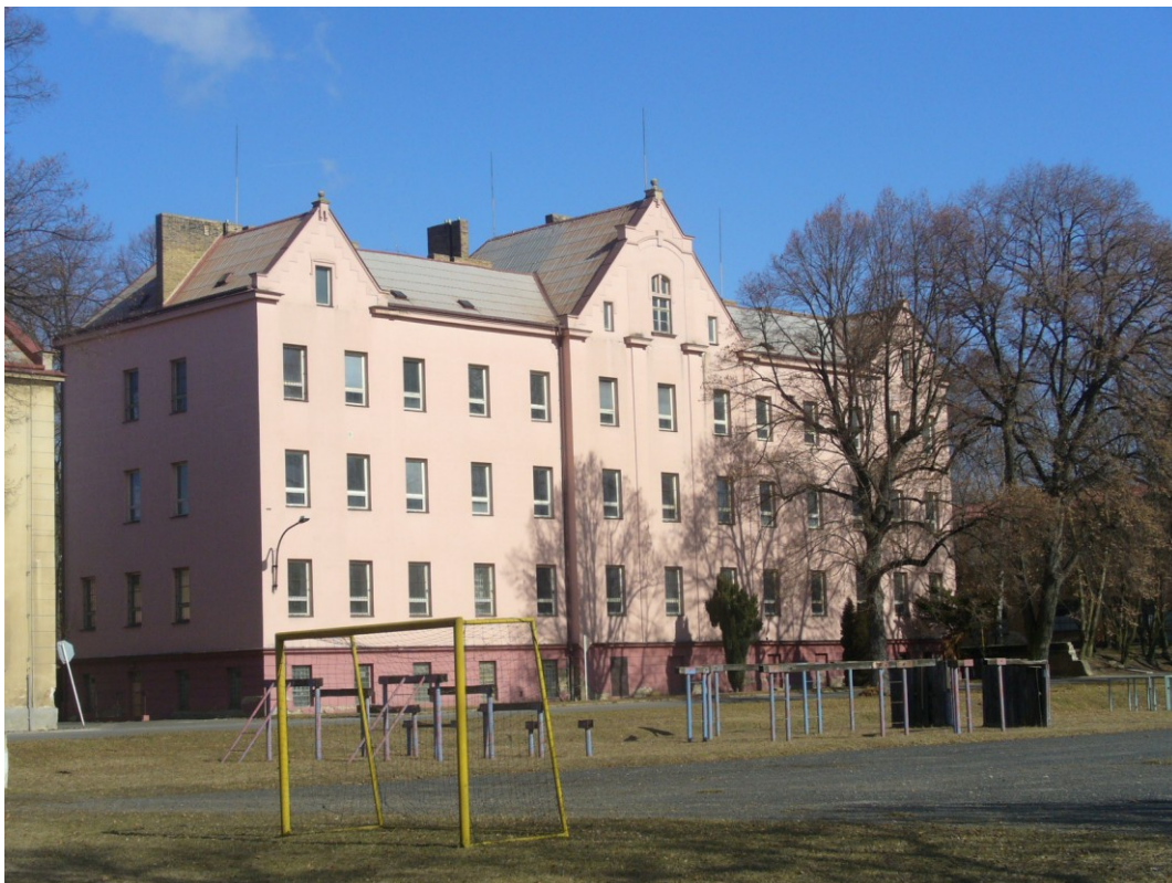
Obr. č. 33 a 34 – současný stav objektů, které byly součástí kasáren
