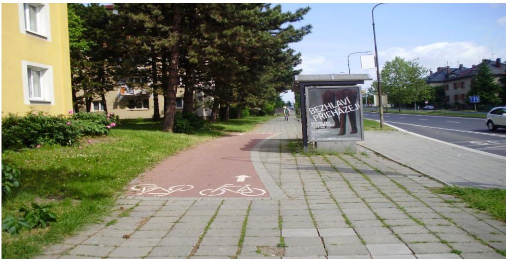
Obrázek 7: Vyústění cyklostezky na chodník
