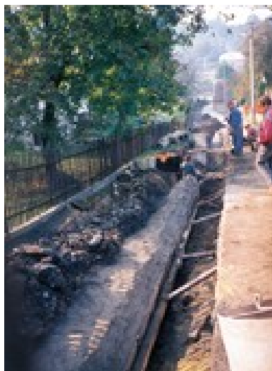
Obr. 12 Zemní práce na kanalizaci v Chrudimi
