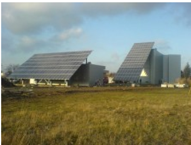
Obr. 11 Průmyslová stavba M-tech Pardubice
