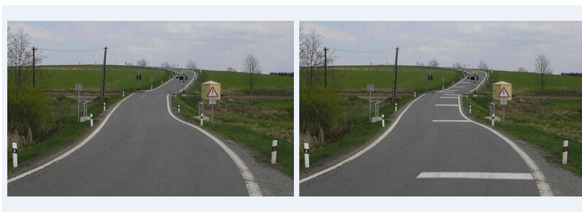
Obr. 3.3 Použití zvýrazňujících prvků na přejezdu [15]
