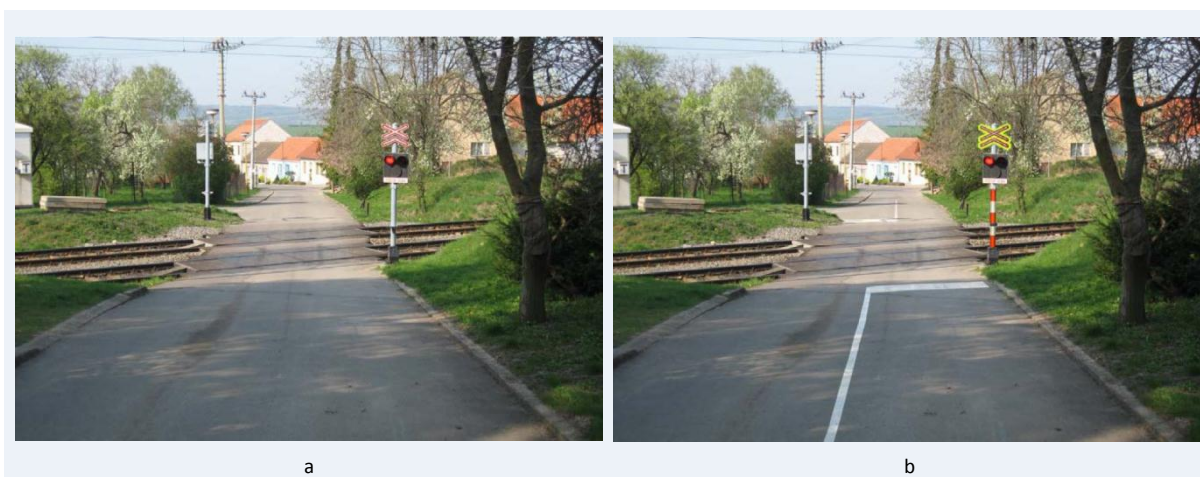
Obr. 3.2 Použití zvýrazňujících prvků na přejezdu [15]
