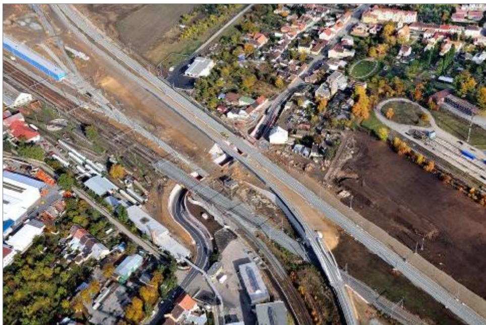
Obrázek 3: Letecký snímek podjezdu Sokolova po jeho dokončení Zdroj: MMB
