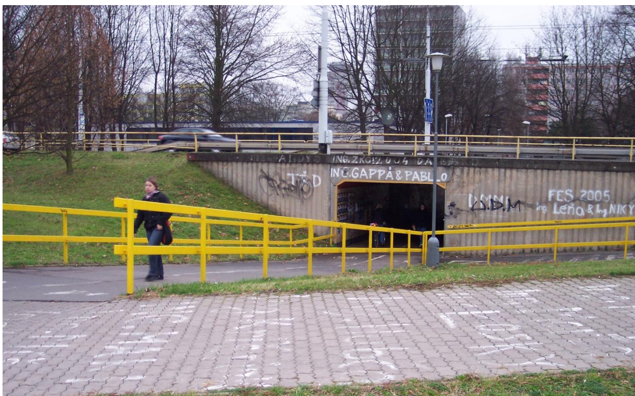
Foto č. 7 – Podchod pod ulicí Hradecká
