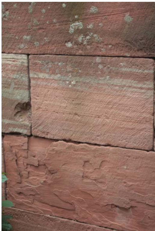
Foto č. 49. osazení bloku proti vrstevnatosti, Jilemnice - hřbitov
