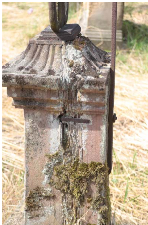
Foto č. 47. příklad rozrušení povrchu vlivem působení kyselých dešťů, Dolní Lánov – kostel sv. Jakuba
