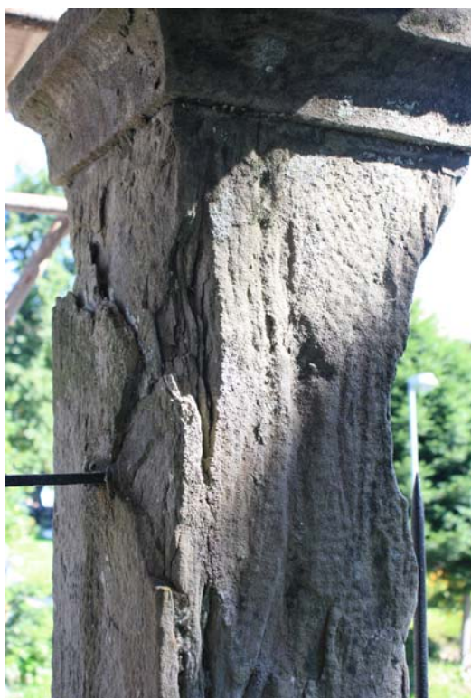
Foto č. 54. plátkový rozpad bloku po vrstevnatosti, Vrchlabí – plot hřbitova
