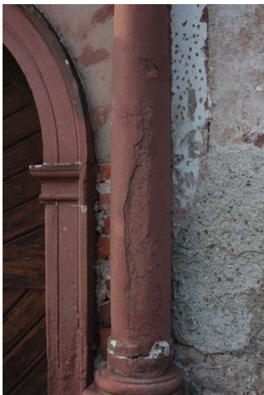
Foto č. 47. příklad rozrušení povrchu vlivem působení kyselých dešťů, Dolní Lánov – kostel sv. Jakuba
