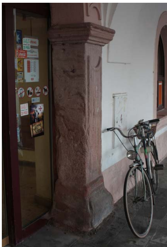
Foto č. 45., 46. destrukce méně odolných částic vlivem působení vodorozpustných solí. Hostinné – Náměstí čp. 57
