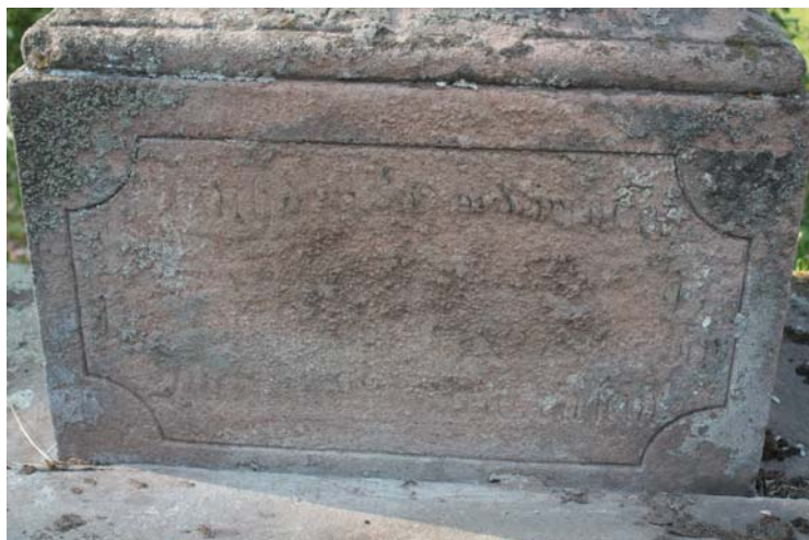
č. 42. deformace a práškovatění povrchu působením sádrovce, Prosečné – boží muka při čp. 30
