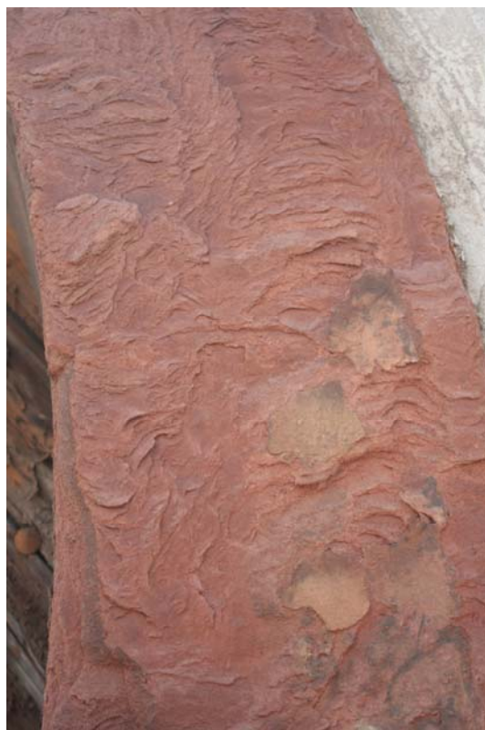
Foto č. 43. degradace povrchu vlivem vztlínání a krystalizace vodorozpustných solí, Hostinné čp.21
