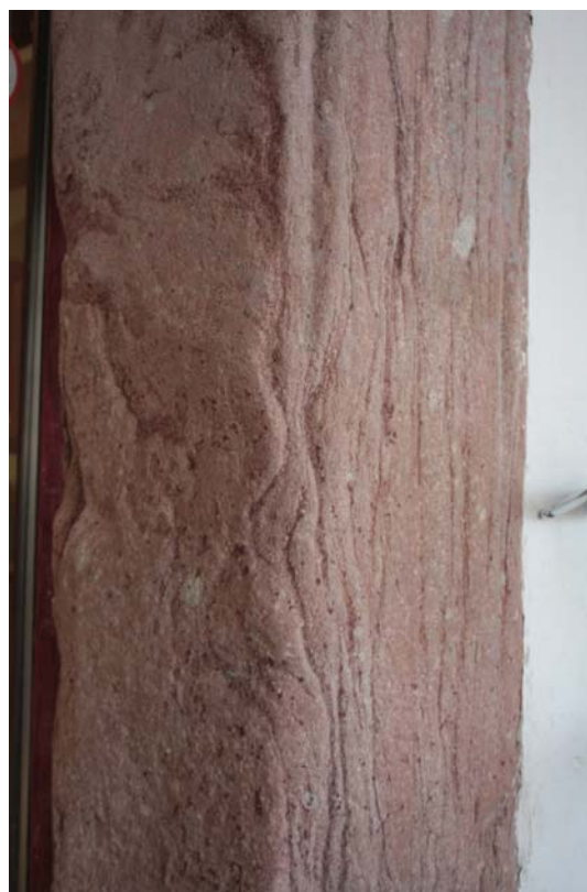
Foto č. 45., 46. destrukce méně odolných částic vlivem působení vodorozpustných solí. Hostinné – Náměstí čp. 57
