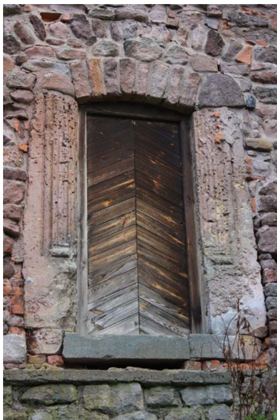
Foto č. 58. postupující praskání do středu bloku, sv. Jan při komunikaci Červený Kostelec - Hronov Foto č. 59. Vymývání méně odolných složek a jílových částic, hrad Pecka
