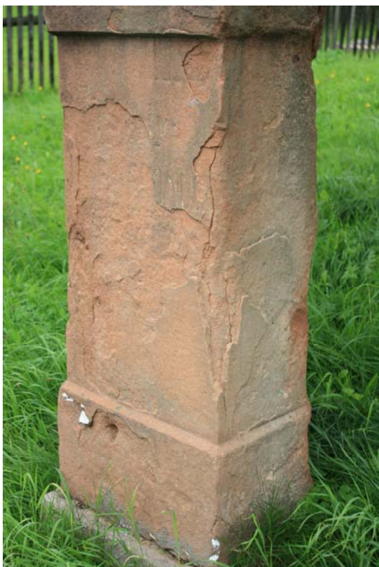
Foto č. 58. postupující praskání do středu bloku, sv. Jan při komunikaci Červený Kostelec - Hronov Foto č. 59. Vymývání méně odolných složek a jílových částic, hrad Pecka
