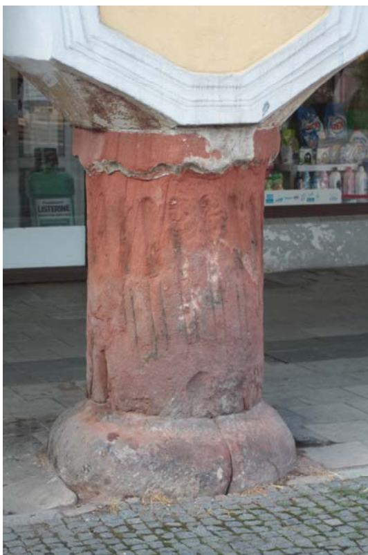
Foto č. 43. degradace povrchu vlivem vztlínání a krystalizace vodorozpustných solí, Hostinné čp.21
