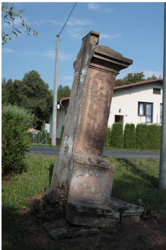
Foto č. 60. statická porucha v důsledku růstu náletů, Prosečné – boží muka při čp. 30 Foto č. 61. radiální rozpuknutí sochy v důsledku koroze čepu, Vysoké n. Jizerou - sloup se sv. Antonínem
