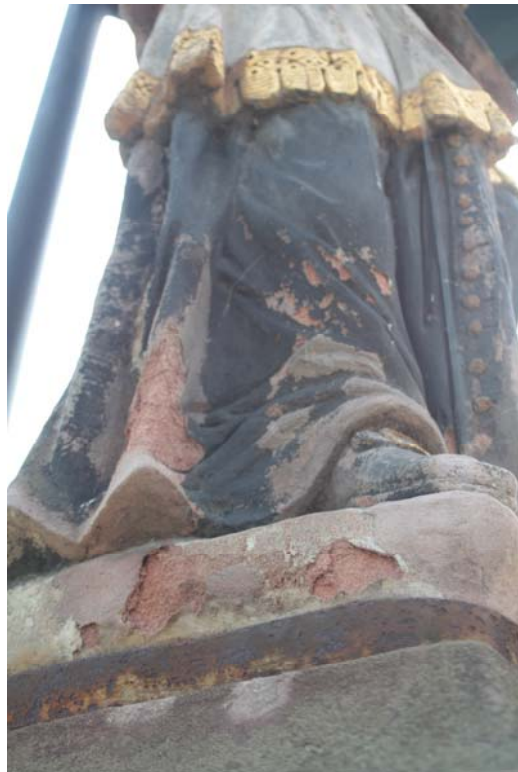
Foto č. 54. plátkový rozpad bloku po vrstevnatosti, Vrchlabí – plot hřbitova
