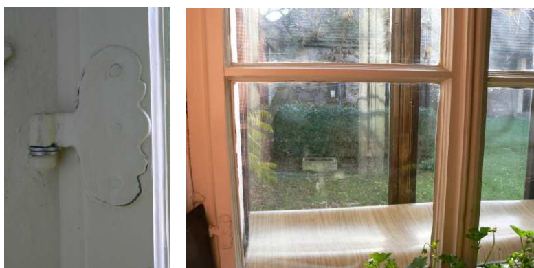
5) Venkovní kovaný závěs na vnitřním okenním křídle, profilace příčlí ve světnici
