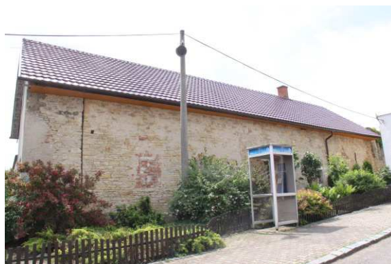
2) Severní podélná strana
