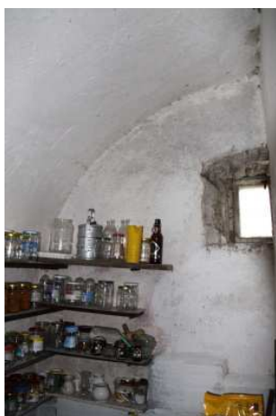
3) Pohled k boční stěně komory od vstupu - vstupní tvar valené opukové klenby (pouze polovina klenebního čela, místnost dělena příčkou)
