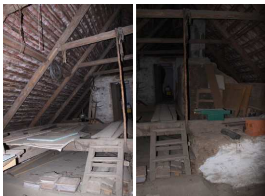
9) Hambalkový krov nad domem; prostupující těleso dymníku vzadu vydělené komůrka nad světnicí
