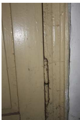
5) Žaludové závěsy dveří do světnice s profilovanou obložkou s motivem oblounu
