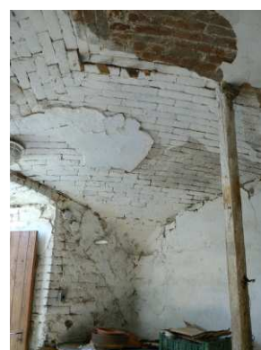
6) Kosočtverečná skladba pozdní plackové klenby v maštali
