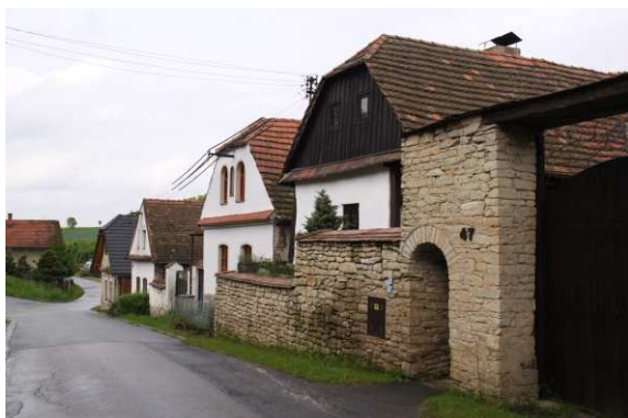
5) Pohled na domkářskou zástavbu zleva čp. 47, 22, 21, 20
