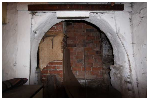
6) Pohled k čelní stěně sklepa od vstupu - zachycený tvar valené opukové klenby
