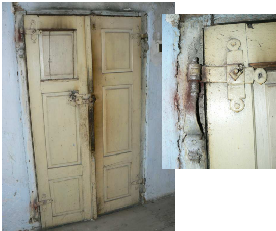
11) Rubová strana dveří v prvním patře v prvním dílu s detailem závěsů
