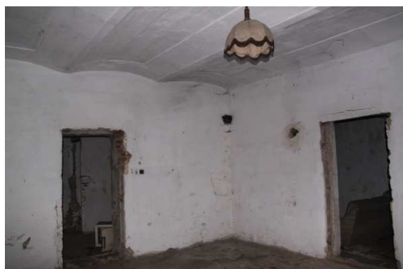
9) Segmentová klenba ve světnici o ocelových profilů se štukovým zrcadlem, pohled ke vstupu do ocelových profilů, pohled od vstupu
