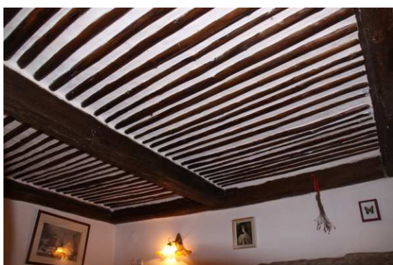
3) Trámový strop v zadní komoře
