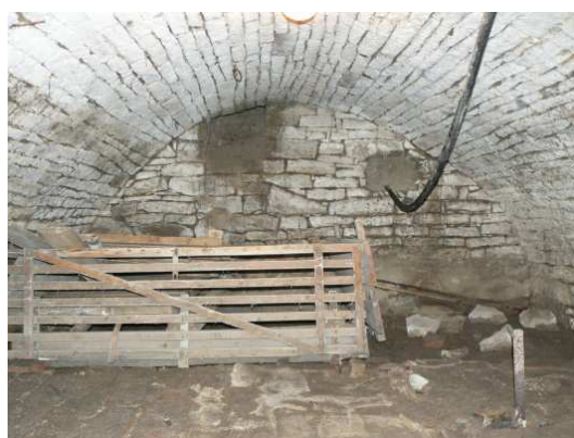
4) Tvar klenebního čela valené sklepní klenby v příčce (dodatečně dozděno)
