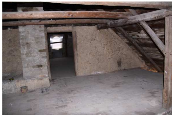
14) Dřevohliněná příčka v podkroví
