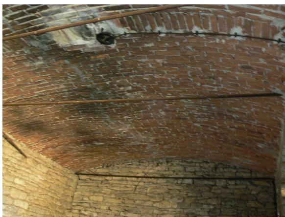
17) Segmentová klenba v přízemí
