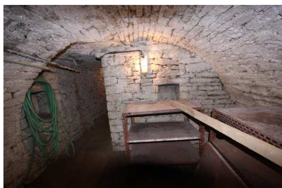
2) Pohled na vstupní stranu sklepa s tvarem valené klenby, při straně pětiboká výseč
