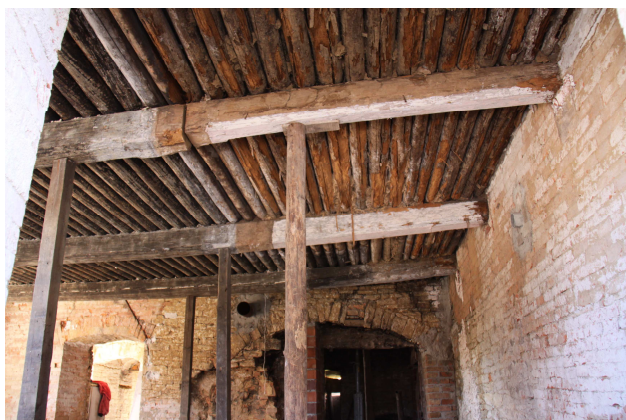
9) Pohled do „útroby“ kuchyně (podesta s tělesem pece nad nimi vylehčovací oblouk ve zdivu, dále negativ po snížení dymníku nepálenými cihlami a dymník)
