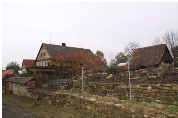
1) Celkový pohled na usedlost od jihu
