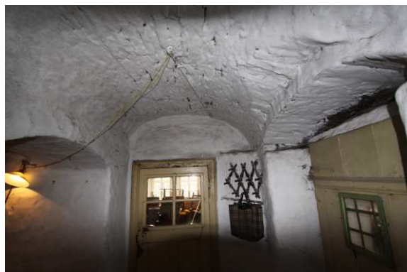
3) Valená klenba v síni s vstupními dveřmi do domu a světnice
