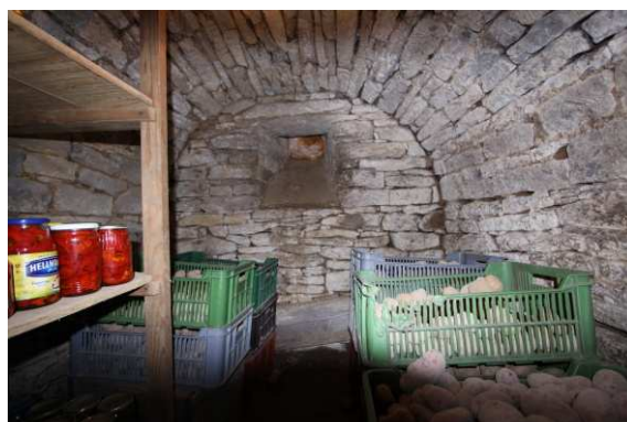
6) Pohled k čelní stěně sklepa od vstupu - zachycený tvar valené opukové klenby
