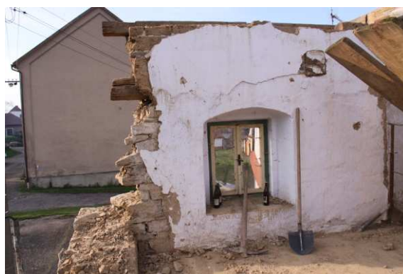
20) Starší a mladší pozednice odhalené při demolici domu
