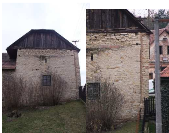
7) Pohled na zadní podélnou stěnu v patře, 8) Pohled na zazděné konce trámů v zadní vlevo vystupující zazděný trám podélné stěně
