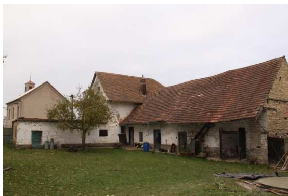
6) Pohled na zdivo zadního průčelí, po stranách umístěné konce pozednic
