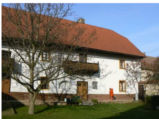
11) Dvorní strana domu
