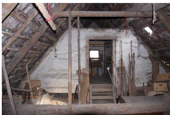
7) Dřevohliněná komora v podkroví, hambalkový krov
