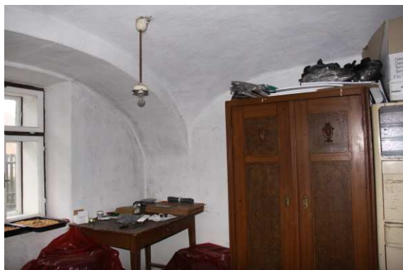
5) Pohled na tvar plackové klenby v komoře valené klenby
