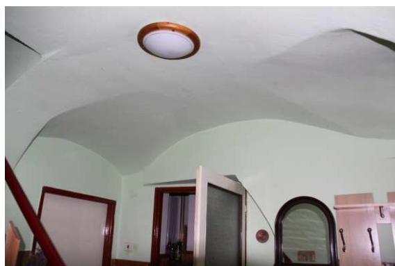
2) Valená klenba v síni s pětibokými výsečemi nad vstupy do světnice a zadní komory
