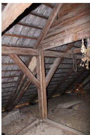
7) Stojatá stolice se vzpěrou v hambalkovém krovu nad domem s zbytkem příčky drážkové konstrukce
