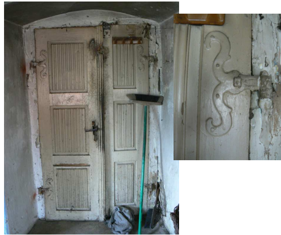
12) Rubová strana dveří v první patře v dílu s detailem závěsů
