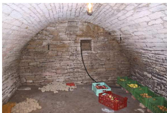
3) Pohled k čelní stěně sklepa od vstupu - zachycený tvar valené opukové klenby
