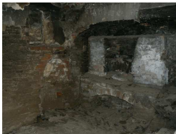
8) Vylehčovací pas nesoucí otevřené ústí komína (stav 2009)
