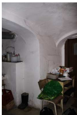
3) Vestavěné těleso pece v síni
