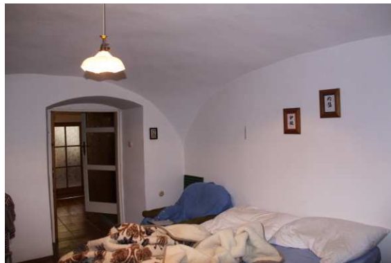
6) Pozdní tvar plackové klenby v zadní komoře
