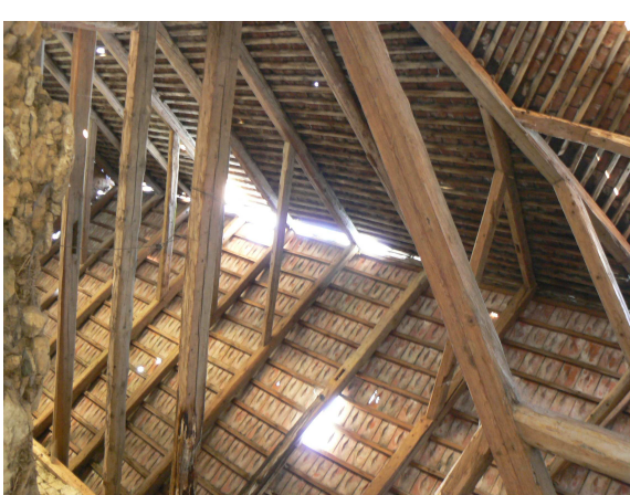
19) Hambalkový krov objektů
