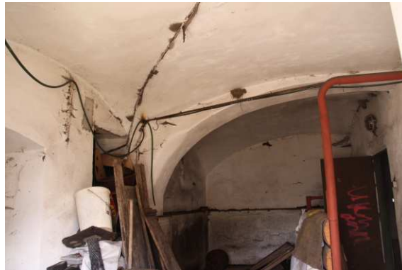
2) Placková klenba s půlelipsovým pasem v maštali
