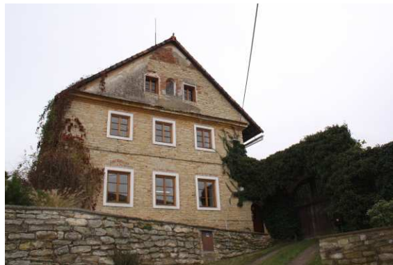
2) Přední průčelí domu
