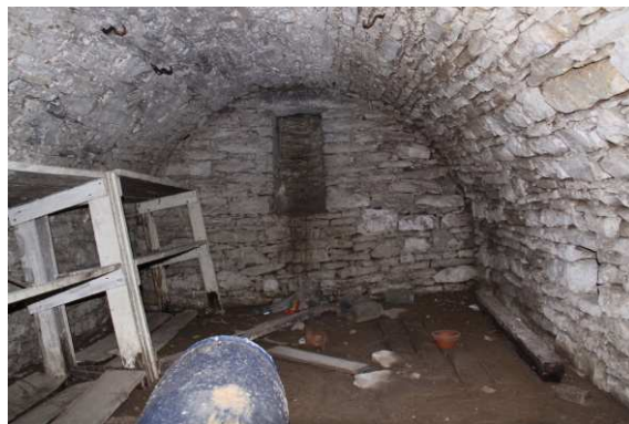
2) Pohled na čelní stěnu sklepa pod sýpkou
