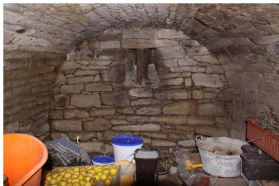
3) Pohled k zadní straně sklepa od vstupu zachycený tvar valené klenby
