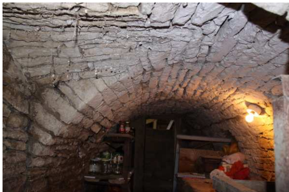
2) Valená klenba s pětibokou výsečí umožňující vstup netradičně nad boční stranou
