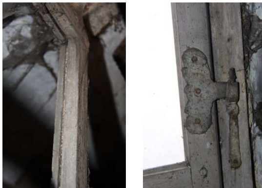
8) Okenní křídlo na suché zasklení venkovní kovaný závěs
