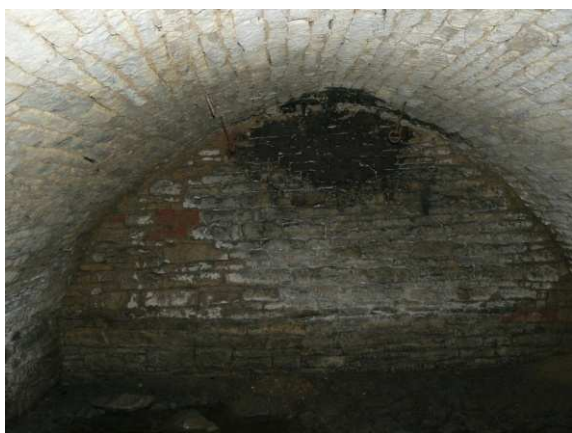
5) Valená klenba ve sklepě
