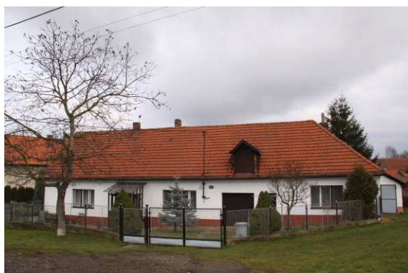
1) Pohled na hospodářské křídlo domu připojené k prvnímu dílu domu
