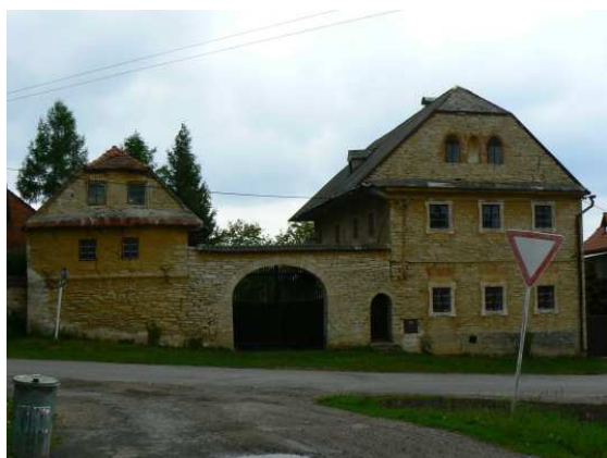
1) Pohled na průčelí usedlosti od jihu
