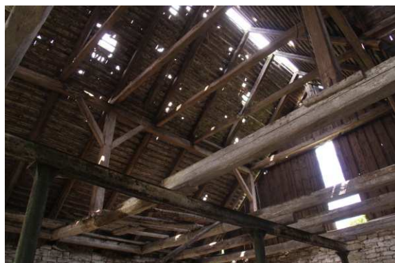
9) Krov ve stodole podepřená ocel. traverzou
