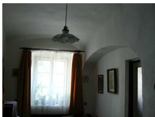
3) Placková klenba ve světničce, která je otevřená do světnice půlelipsovým pasem
