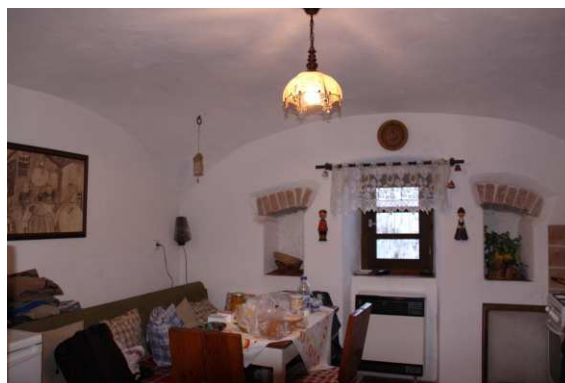
6) Zadní stana komory, foceno do vstupu, zachycen tvar plackové klenby
