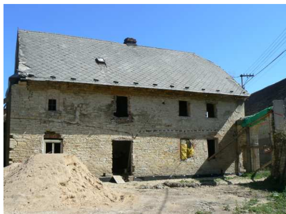
3) Dvorní strana domu
