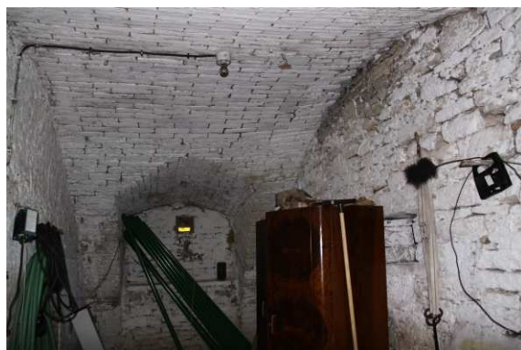
12) Pohled k zadní stěně třetího chléva zachycen tvar valené klenby, detail datace
