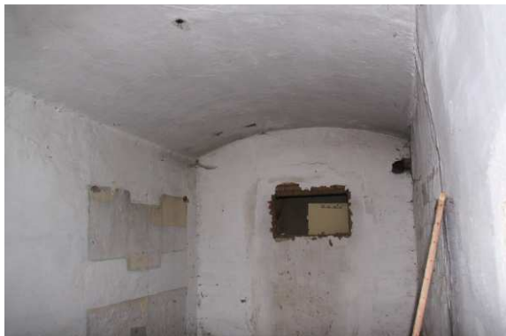
11) Segmentová klenba v komoře v předních komorách v patře
