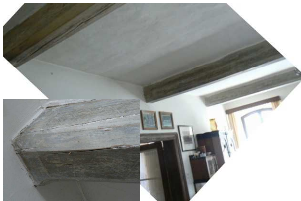
4) Trámový strop ve světnici, detail okosení trámu při zdi
