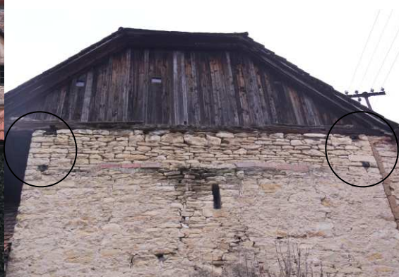
7) Pohled na zadní podélnou stěnu v patře, 8) Pohled na zazděné konce trámů v zadní vlevo vystupující zazděný trám podélné stěně
