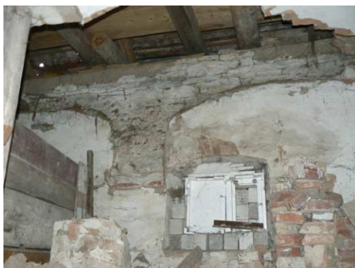
3) Negativ cihelné segmentové klenby do zděného pasu chlévě, ve třetím díle domu
