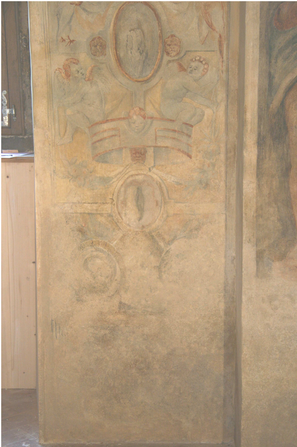
Obr. č. 35 Stav po restaurátorském zásahu – detail
