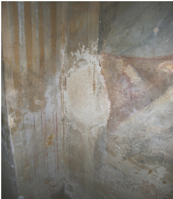
Obr. č. 12 Stav před restaurátorským zásahem – detail starých tmelů
