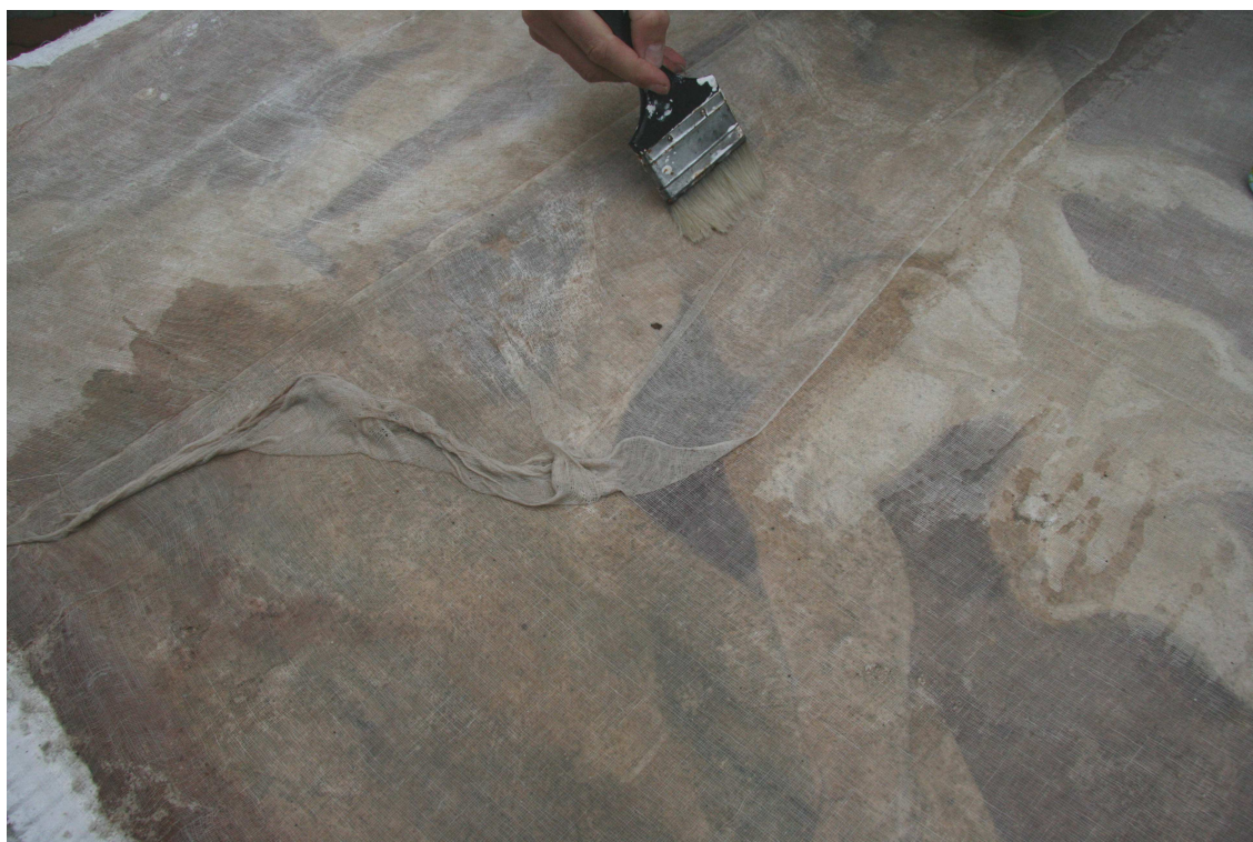
Obr. č. 11 Snímek ukazuje provlhčování textilního přelepu
