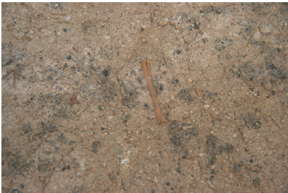
Obr. č. 6 Makro snímek omítkové vrstvy ukazuje strukturu omítky transferu a příměsi v omítkové vrstvě
