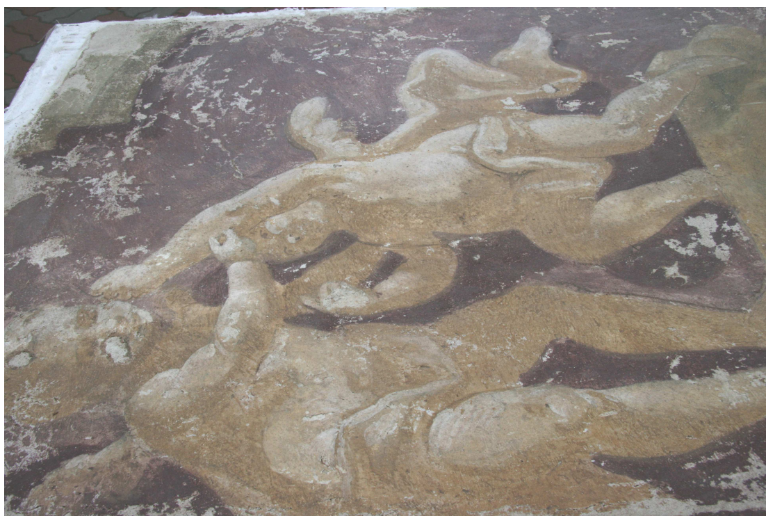
Obr. č. 14 Stav po odstranění textilního přelepu
