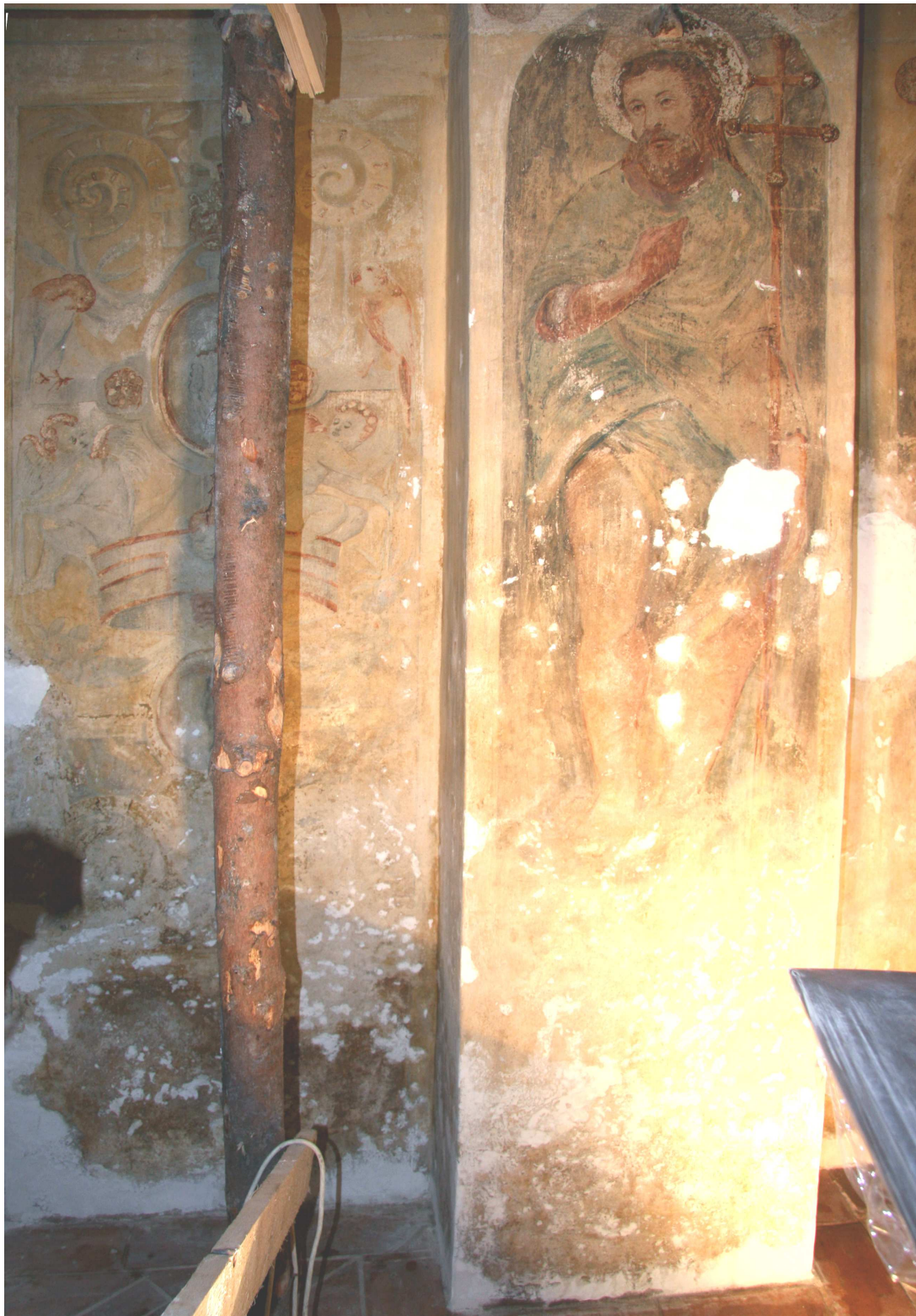
Obr. č. 30 Stav po vytmelení defektů v barevné vrstvě – celkový pohled na centrální část maleb
