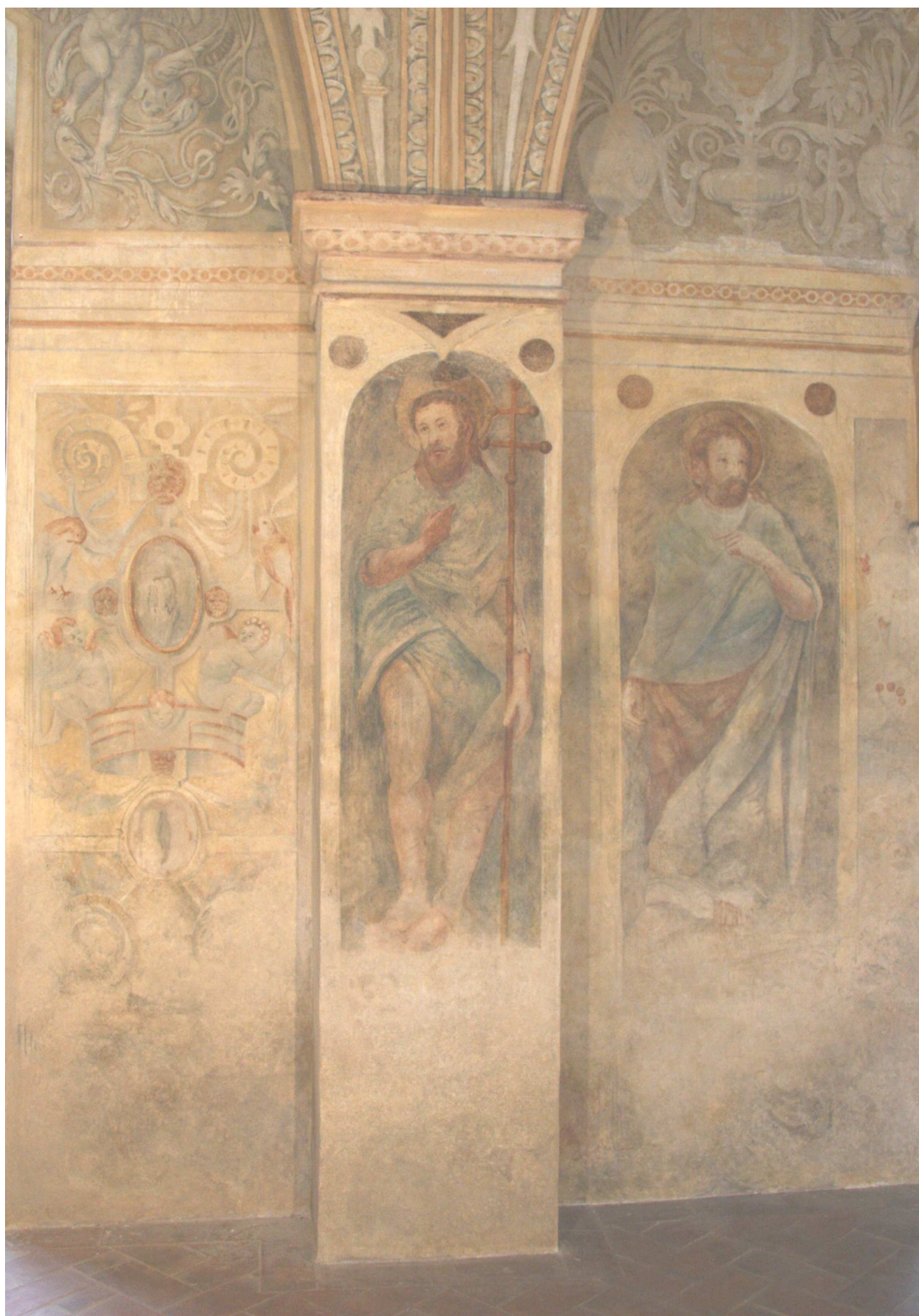
Obr. č. 32 Stav po restaurátorském zásahu – celkový pohled
