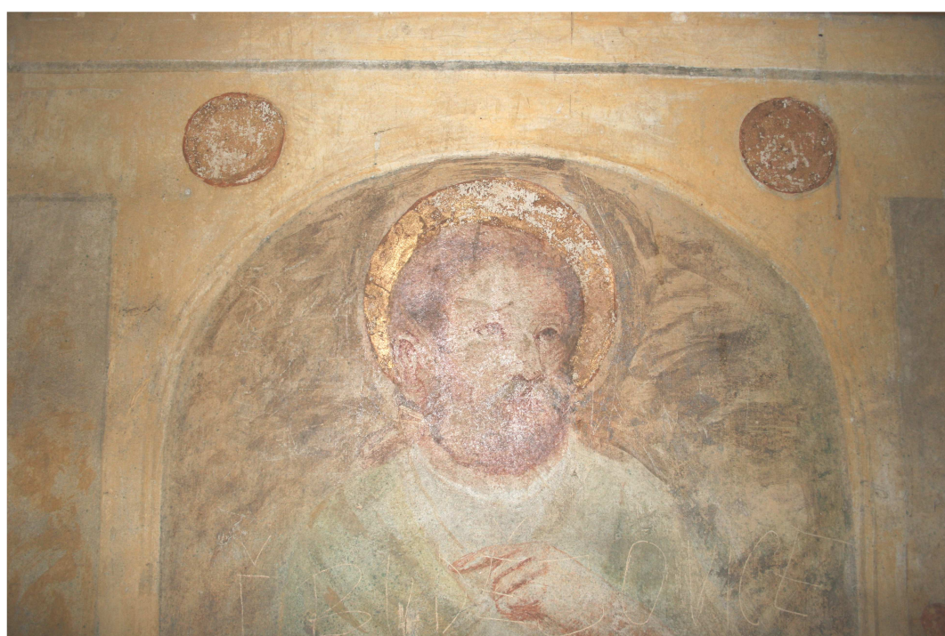
Obr. č. 7, 8 Stav před restaurátorským zásahem – snímky ukazují mechanické poškození barevné vrstvy a přemalby na povrchu malby
