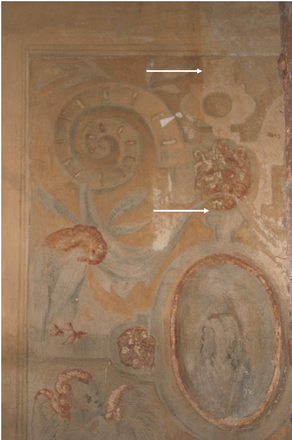
Obr. č. 28 Šipky ukazují rozdíl po sejmutí přemaleb a nečistot z originální barevné vrstvy
