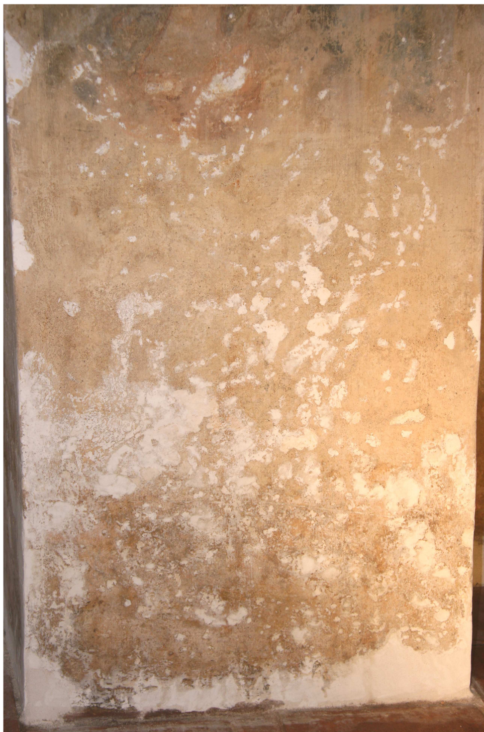
Obr. č. 31 Stav po vytmelení defektů v barevné vrstvě – detail tmelů
