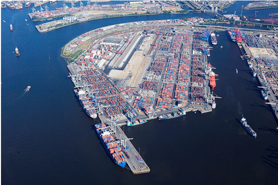
Abb. 16 HHLA Container Terminal Burchardkai ( HAMBURG_HAFEN, 2010 )
