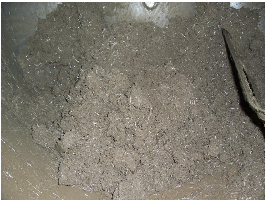
Obr. 20 – míchání drátkobetonové směsi
