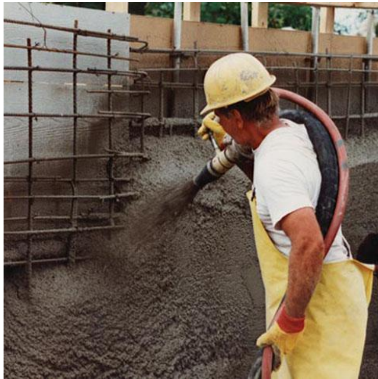
Obr. 6 – Aplikace stříkaného betonu
