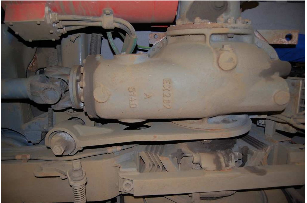
Obr. 7 Pohled zespodu na dolní část skříňe převodovky s torzní vzpěrou (vůz Vario)
