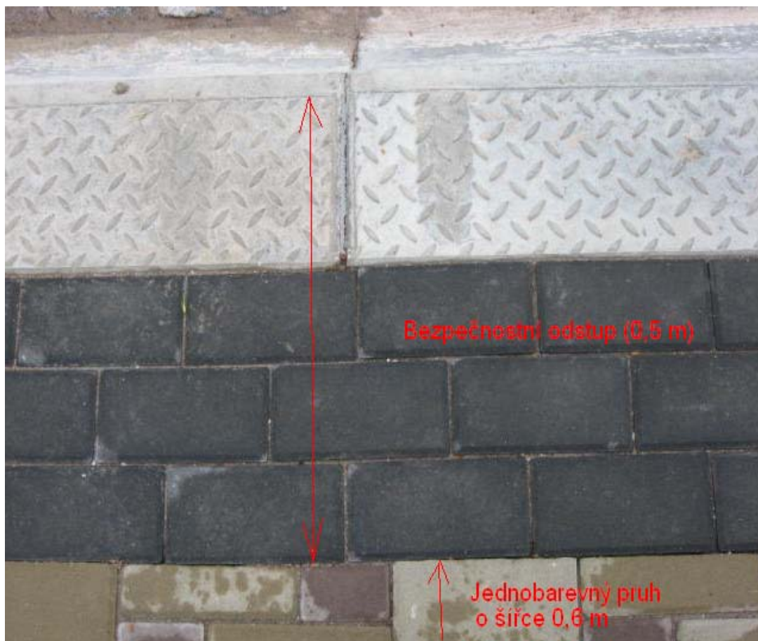
Obrázek č. 25: Úpravy zastávky Na cihelně
