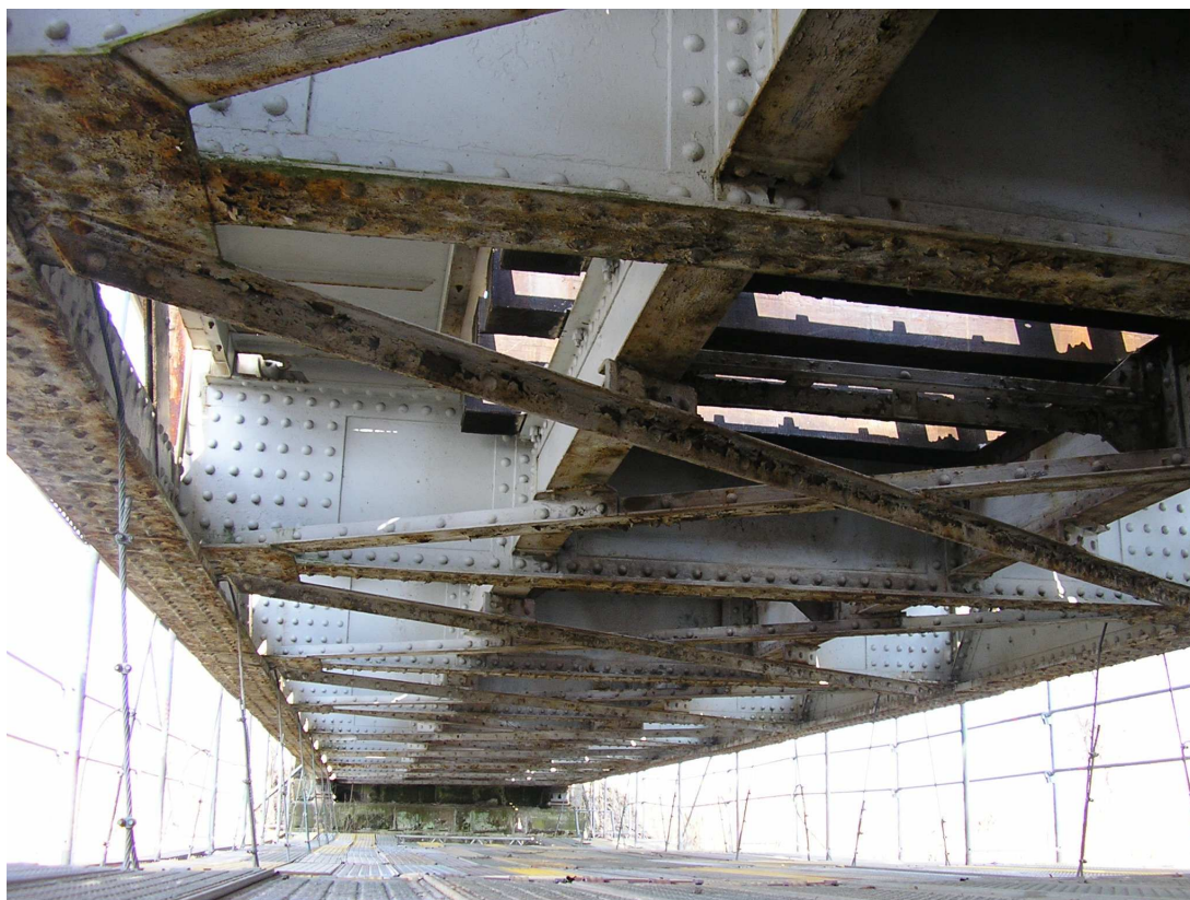
Obr. 4 - Podmostovkové ztužení
