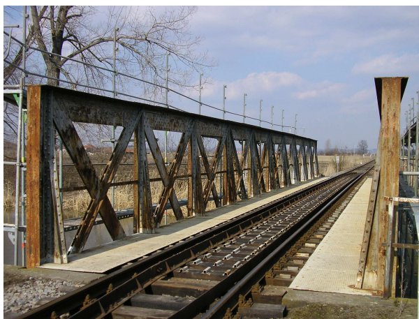
Obr. 1- Pohled na mostní konstrukci ve směru od Moravan
