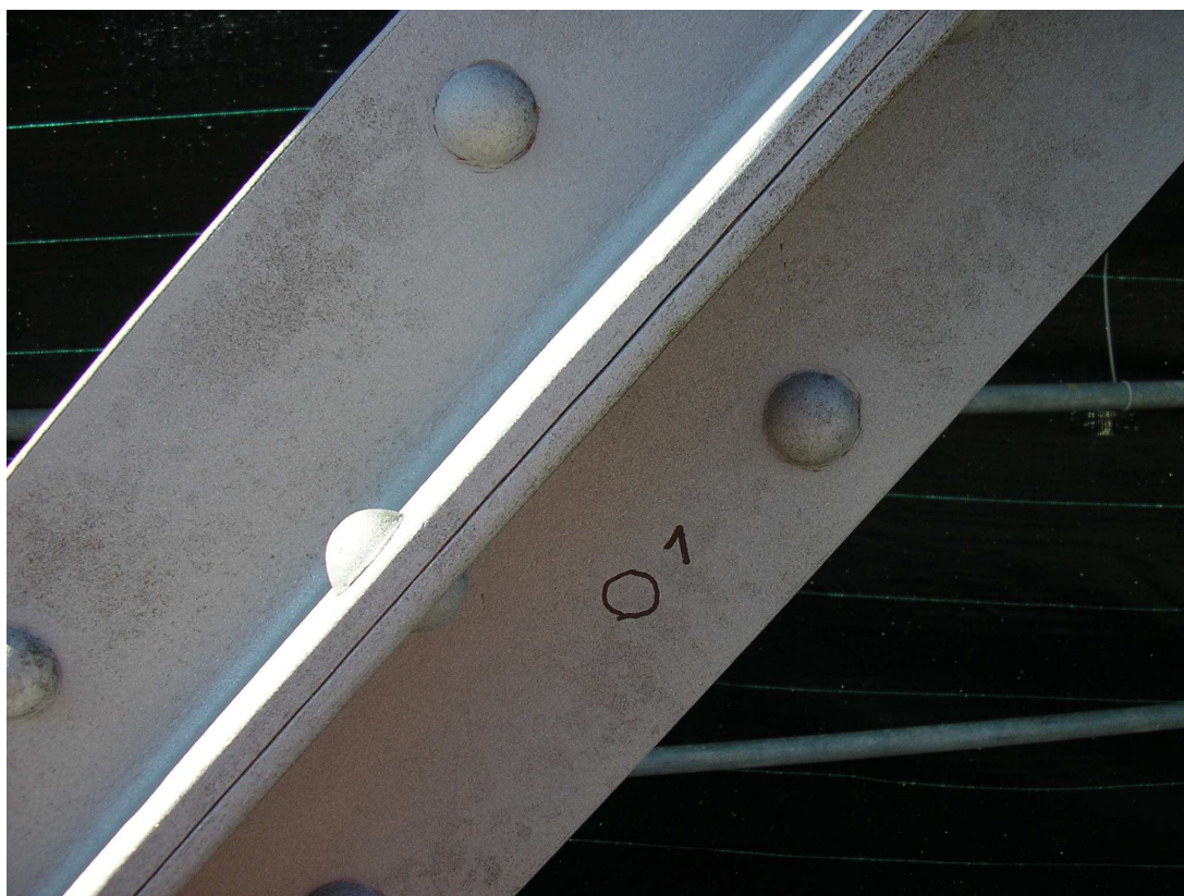
Obr. 7 - Detail označení měřeného místa na otryskané příhradě
