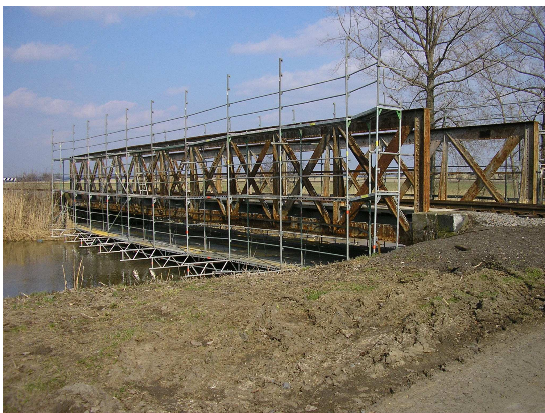
Obr. 3 - Celkový pohled na mostní konstrukci
