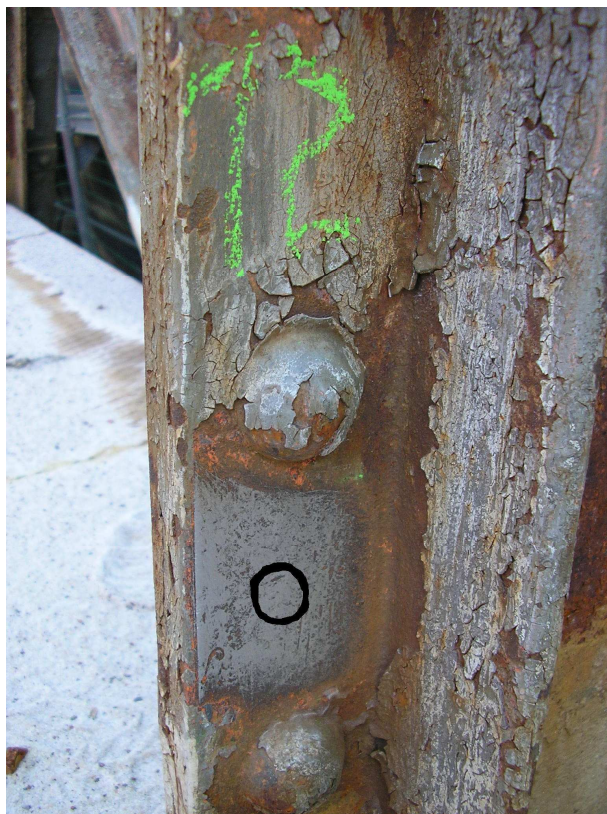
Obr. 9 - Detail označení měřeného místa při ručním odbroušení
