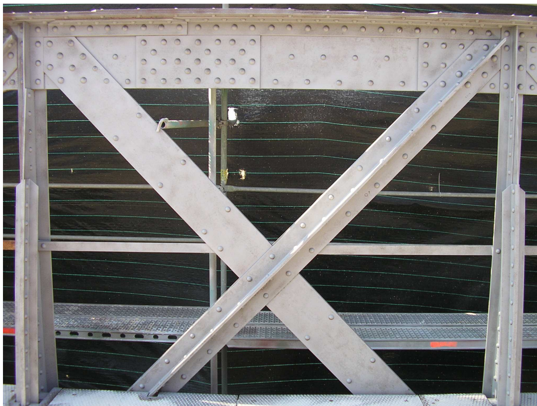
Obr. 6 - Otryskaná příhrada před měřením a provedením základního nátěru
