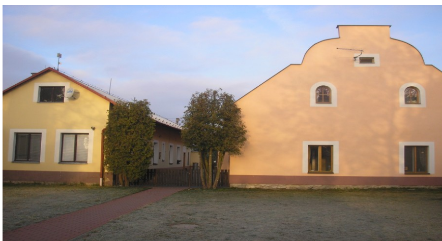
Budova vlevo – ambulance, rodinná buňka, budova vpravo – dole školka Korálek, nahoře ubytování pro matky s dětmi
