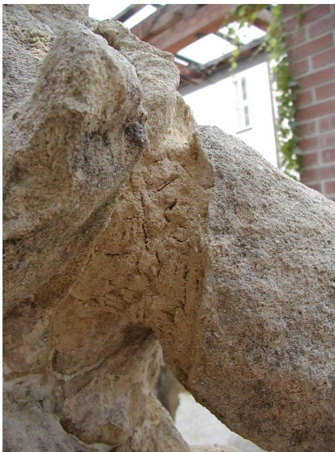
Obr. 43: Nanesené jádro prvé ruky v minerálném tmelu ze zadu.
