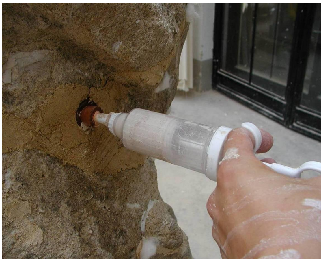
Obr. 38: Injektáž jehlanovitého otvoru jemným vápenným tmelem.
