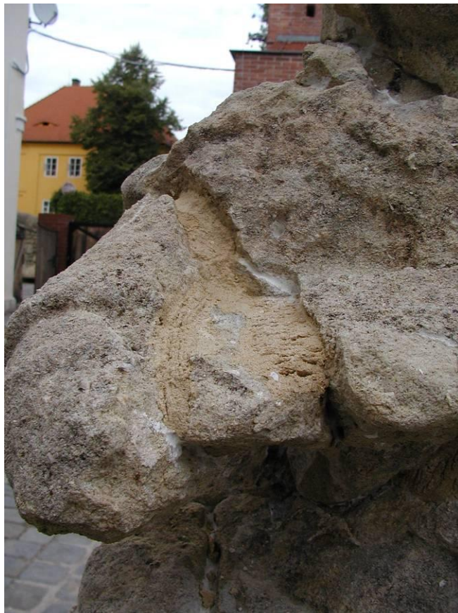
Obr. 44 Nanesené jádro prvé ruky v minerálném tmelu zepředu.
