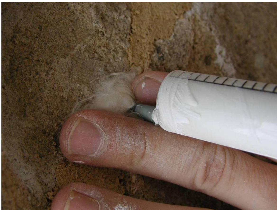
Obr. 39: Injektáž spáry Ledanem TC 1.
