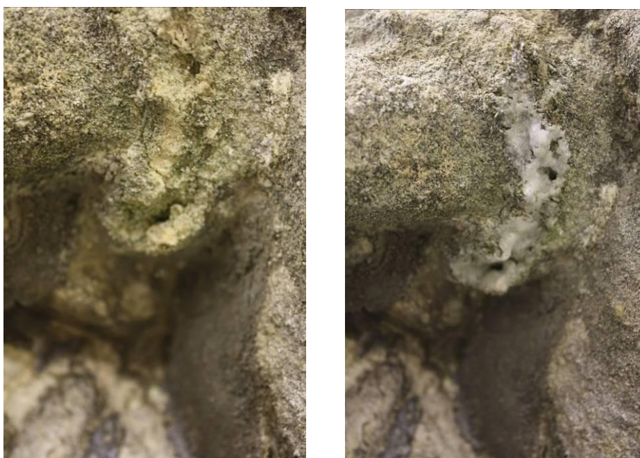
Fotografie před a po zafixování zdegradované části sousoší
