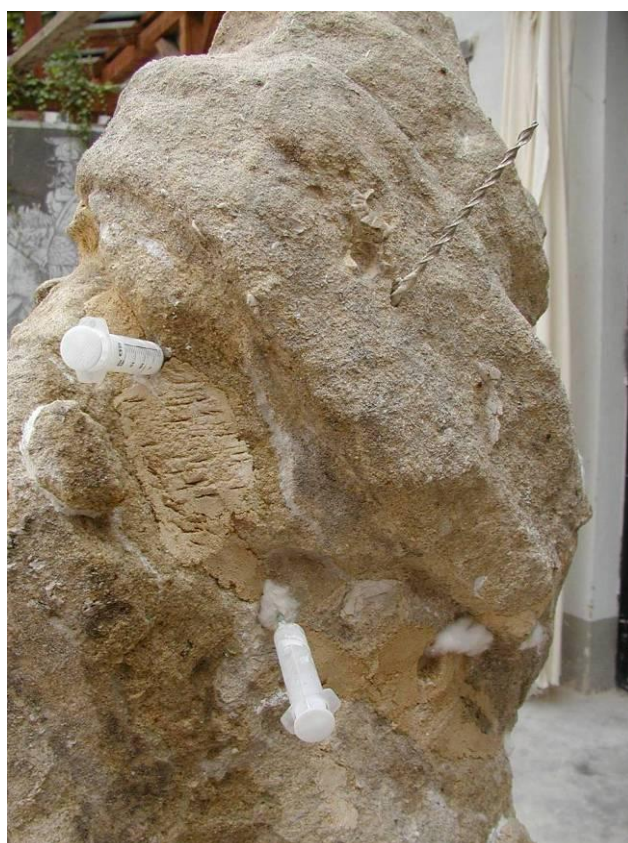
Obr. 42: Zasazování čepů spojené s injektáží.
