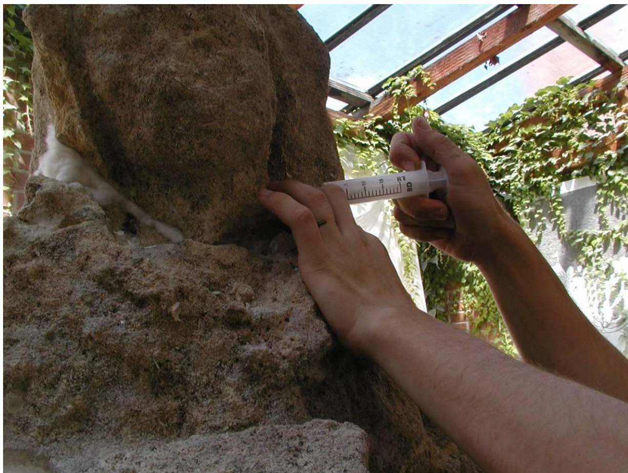
Obr. 41: Zainjektování hlavy sv. Anny
