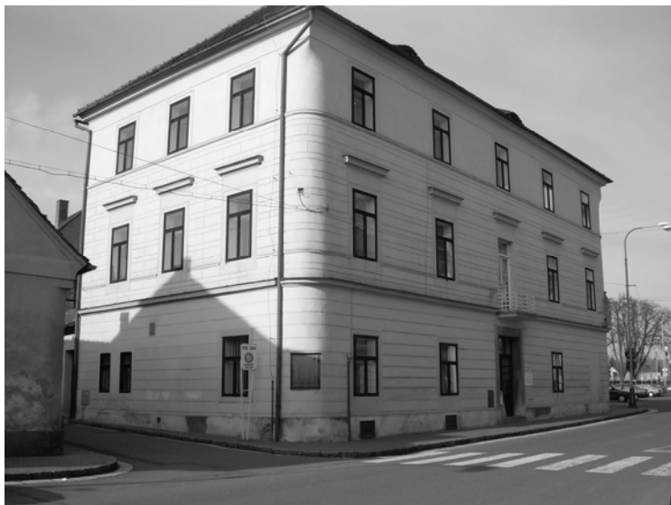
Obr. 5: V této budově se v Heřmanově Městci učilo do r. 1896. (Foto K. Rýdl)
