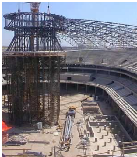
Obr. 14: Výstavba O2 (Sazka) areny
