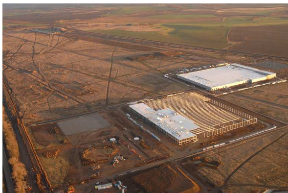
Obr. 5: Výstavba průmyslové zóny Triangle
