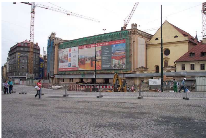
Obr. 16: Rozestavěná budova v září 2006
