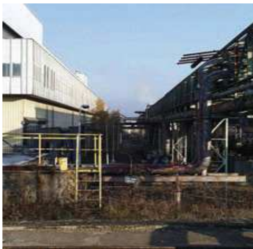
Obr. 8: Areál Škoda - zásobování vodou provedené nadzemním vedením
