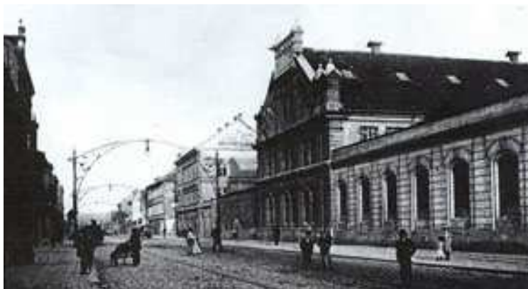
Obr. 18: Tovární hala v Křížkově ulici
