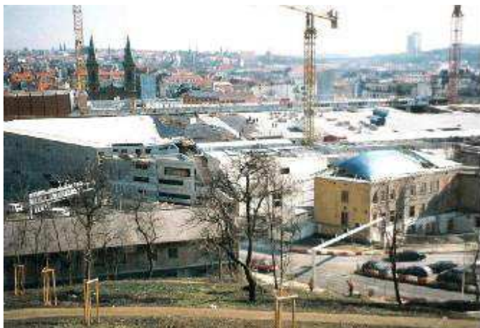
Obr. 12: Výstavba Obchodního centra Nový Smíchov
