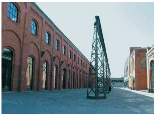
Obr. 9: Budování Vaňkovky - ulice Fr. Wanniecka
