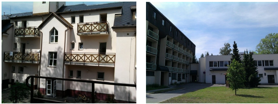
Obrázek 2 - Ubytovací a administrativní budovy DD
