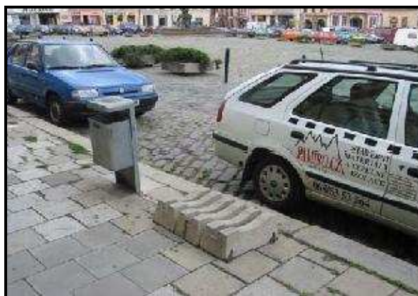
Obrázek 16: Příklad stojanů z betonu nesplňující žádné z daných kritérií
