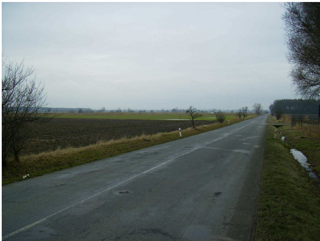
Obr. 11 Stávající silnice II/298, v popředí zachování konstrukce, v pozadí povode rychlostní silnice R35, ve směru staničení SO102
