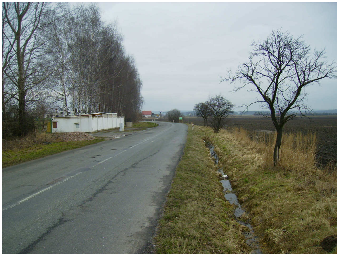
Obr. 9 Dtto, proti směru staničení SO102
