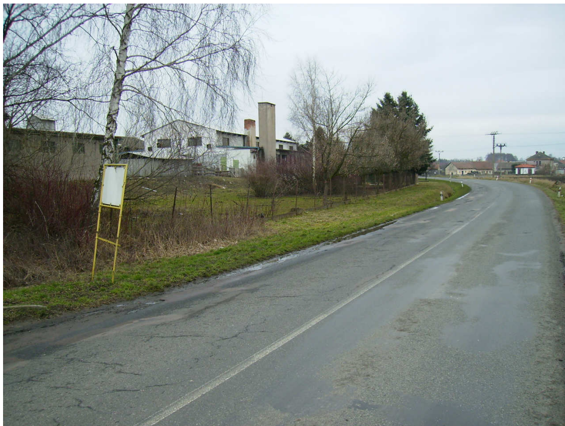
Obr. 5 Stávající silnice II/298, první směrový oblouk, proti směru staničení SO102
