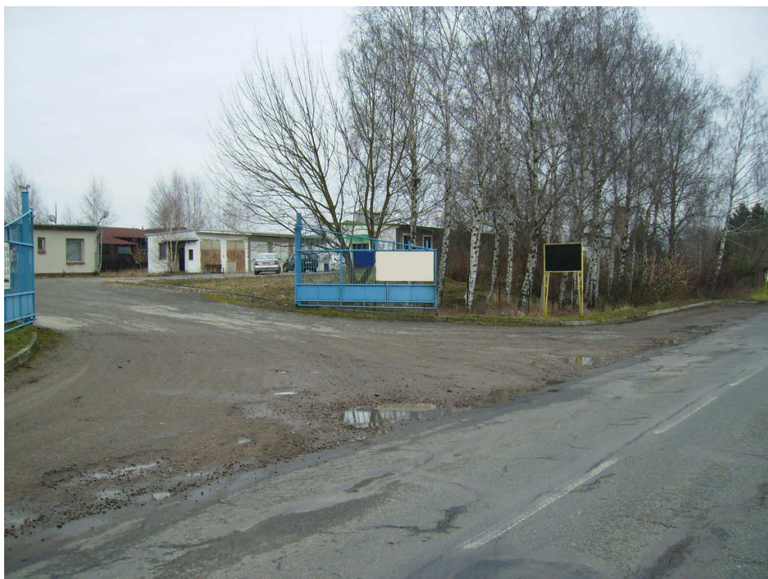
Obr. 6 Vjezd do zemědělského areálu, v tomto místě bude sjezd z nové přeložky na zachovanou stávající vozovku
