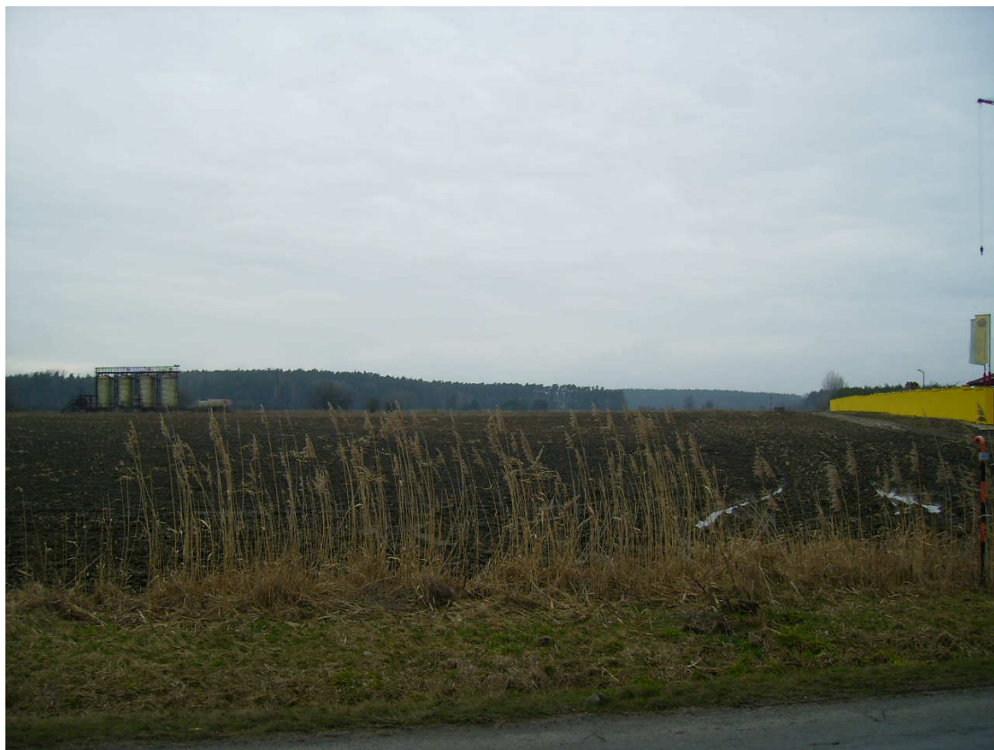
Obr. 15 Trasa budoucí rychlostní silnice R35 v místě křížení se silnicí II/298, proti směru staničení SO101, vpravo areál stavební firmy, vlevo plynová regulační stanice
