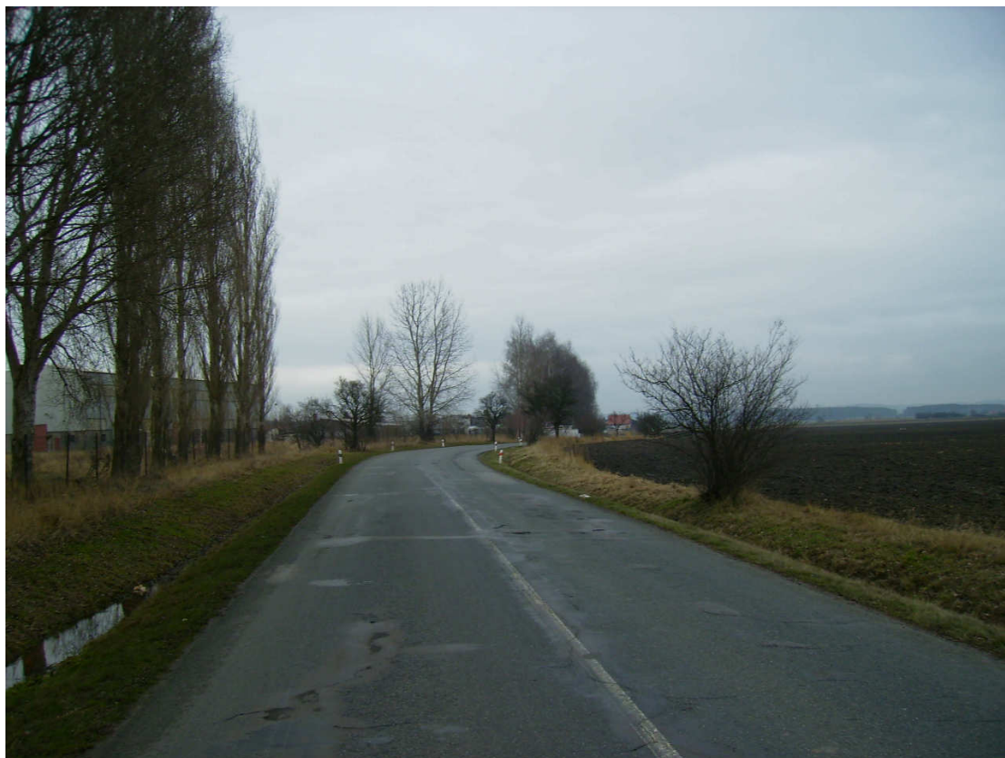
Obr. 13 Stávající silnice II/298, druhý směrový oblouk, proti směru staničení SO102
