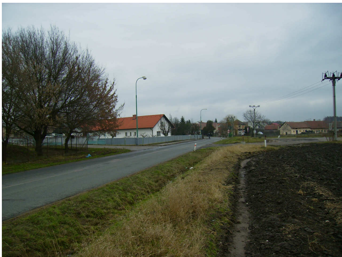
Obr. 4 Stávající silnice II/298, ZÚ proti směru staničení SO102
