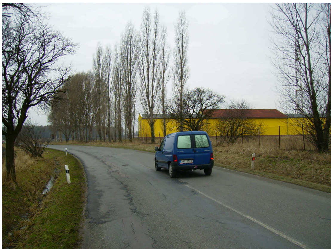
Obr. 10 Stávající silnice II/298, druhý směrový oblouk, ve směru staničení SO102
