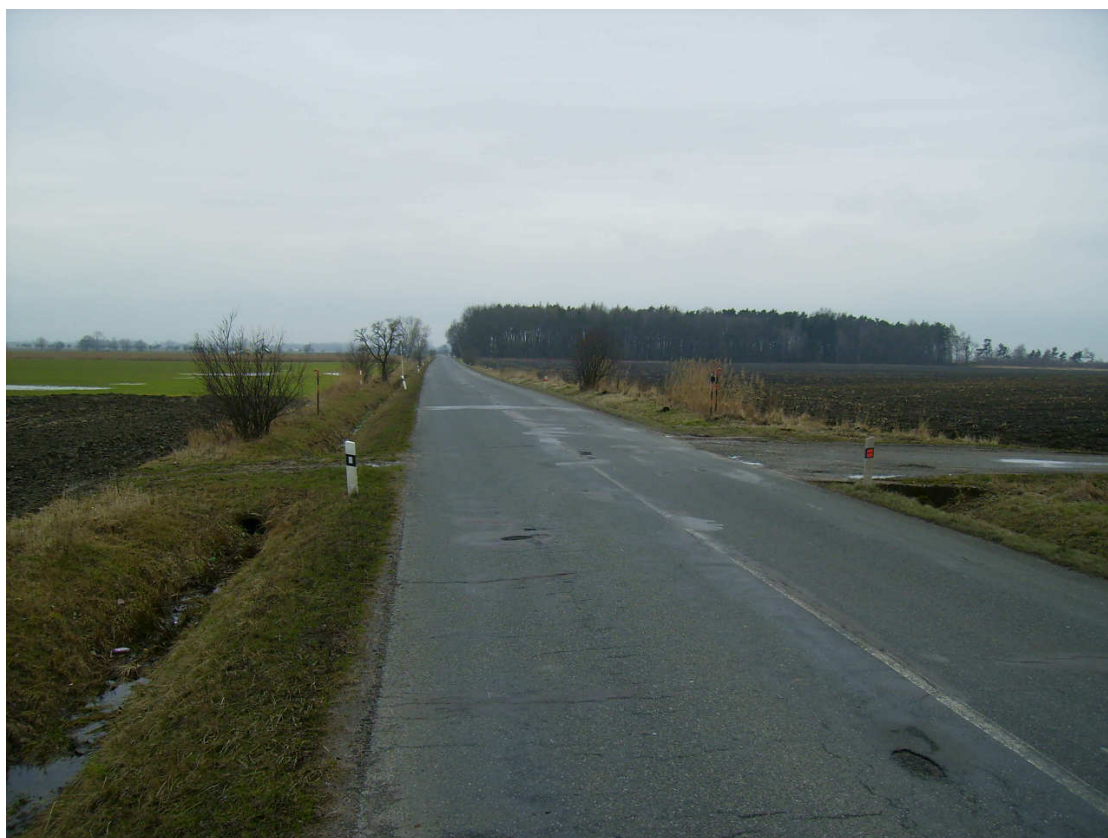
Obr. 12 Dtto, vpravo sjezd do stavební firmy (bude zachován)
