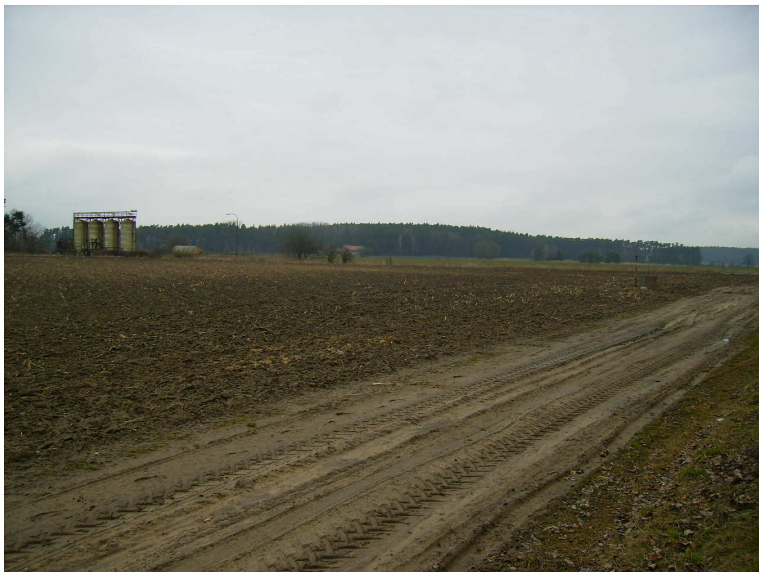
Obr. 21 Pohled od areálu stavební firmy proti směru staničení SO101 (cca km 1,600), vlevo regulační stanice plynu
