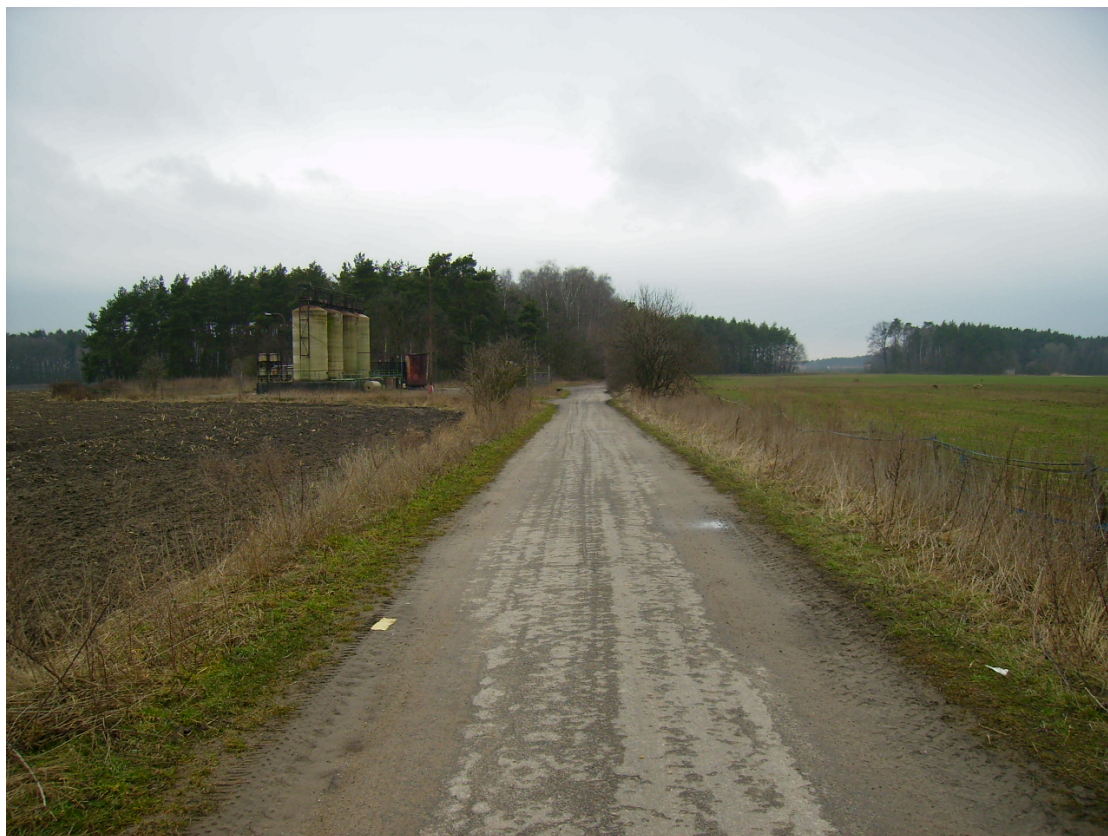
Obr. 22 Asfaltová příjezdová komunikace k regulační plynové stanici v místě budoucí rychlostní silnice (km1,550 SO101)
