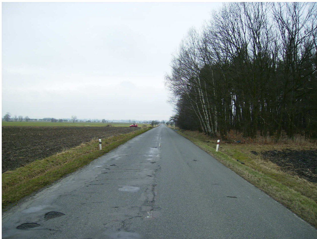
Obr. 19 Stávající silnice II/298 v místě konce přeložky, pohled ve směru staničení SO102
