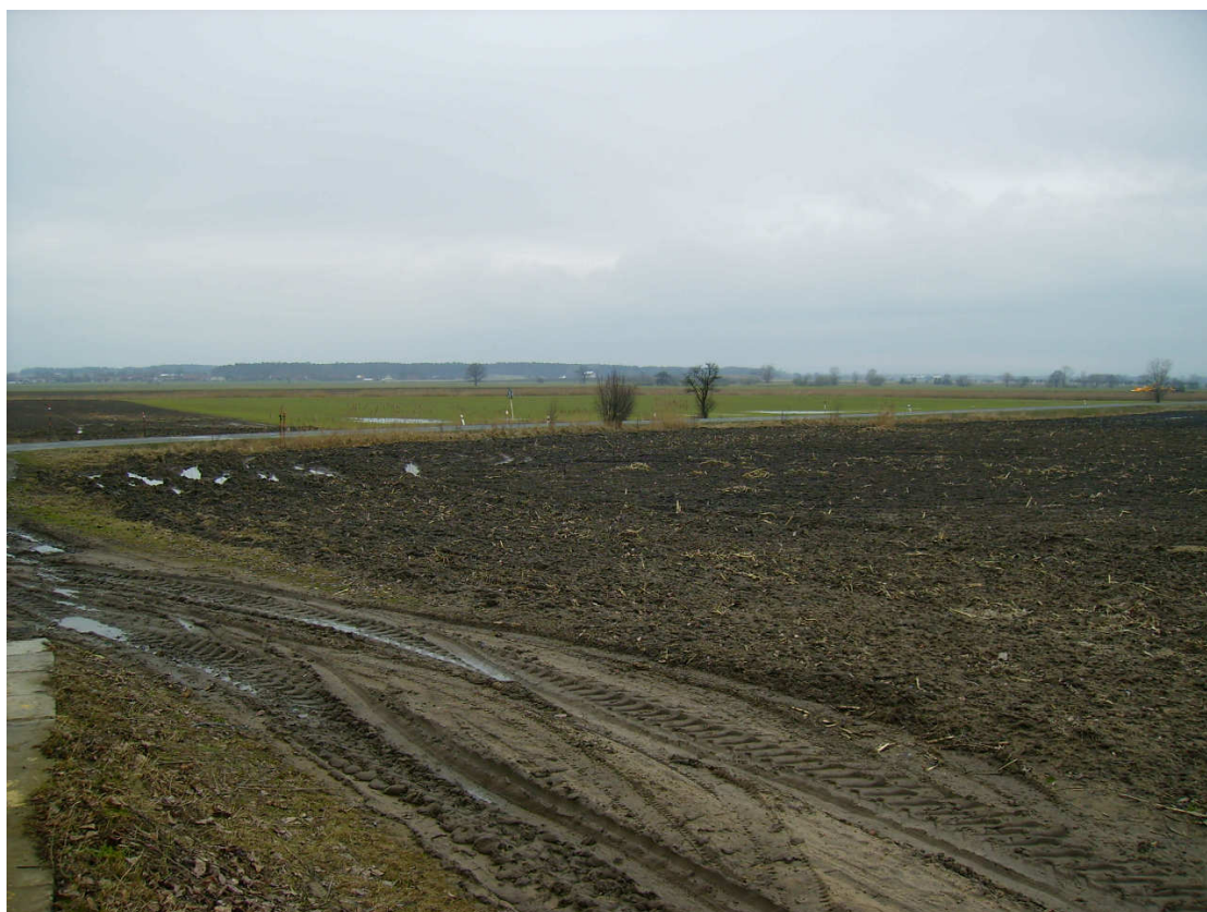
Obr. 20 Pohled na místo mimoúrovňového křížení SO102 s SO101 ve směru staničení SO101, pohled od areálu stavební firmy
