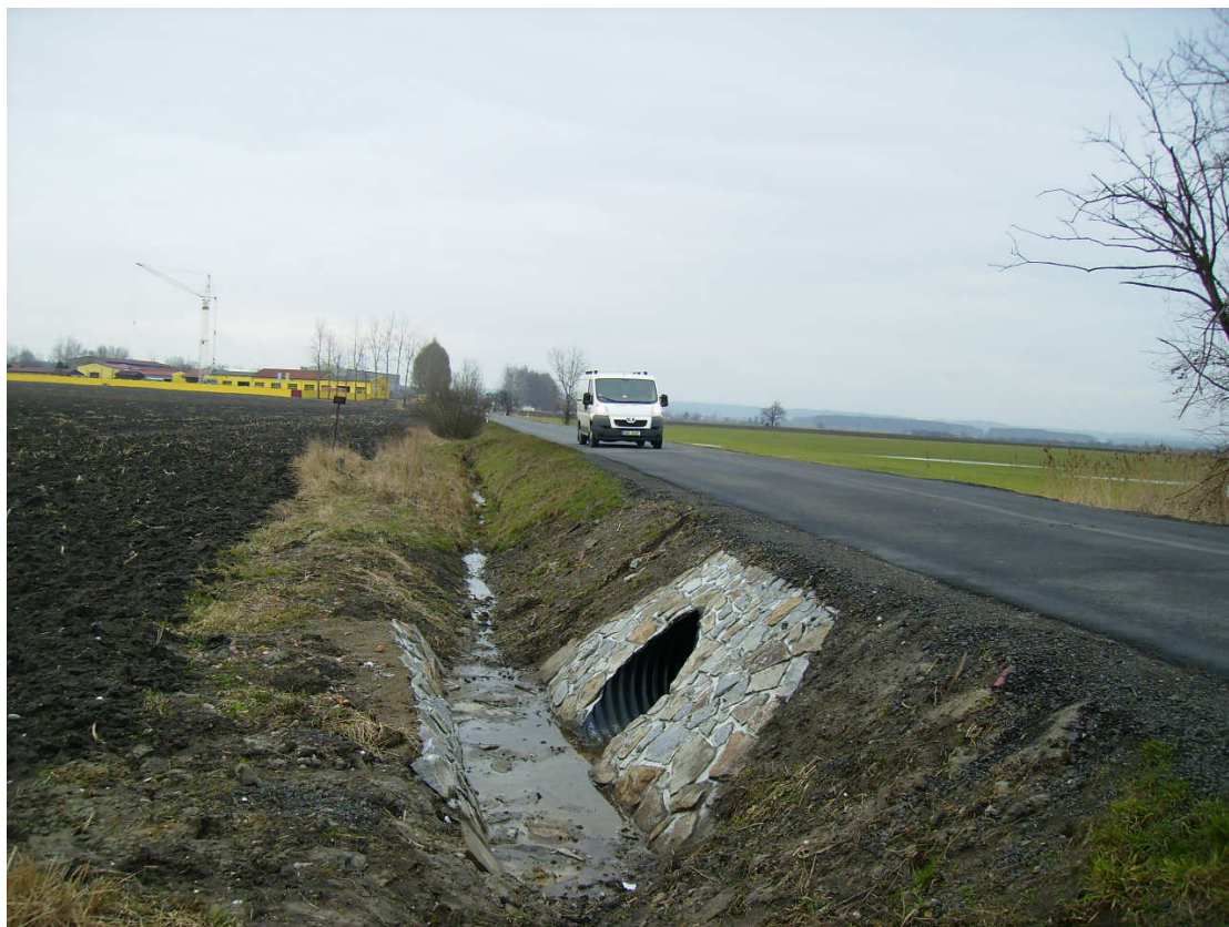
Obr. 17 Dtto, proti směru staničení SO102, v popředí stávající propust Hel-Cor DN800
