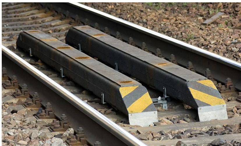
Obrázek 2: Magnetický informační bod MIB-6
