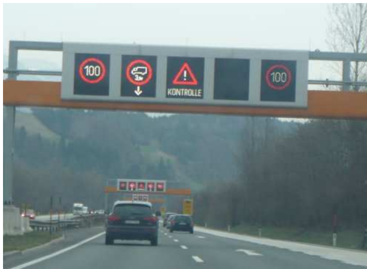
Obrázek 7: Systém liniového řízení dopravy, Rakousko, dálnice E60
