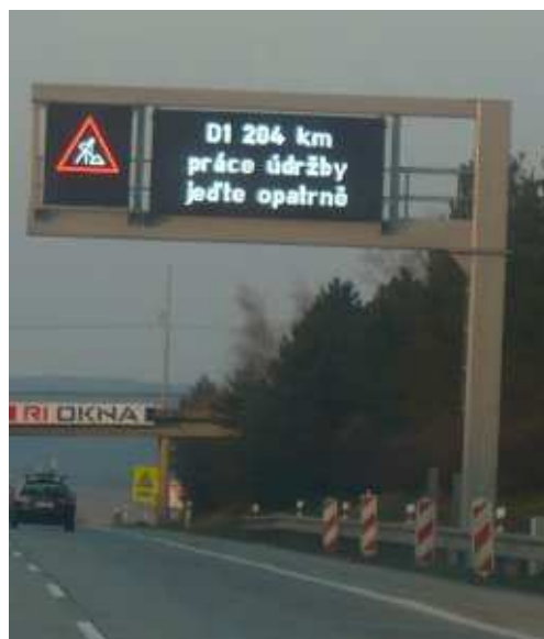
Obrázek 6 : Proměnná informační tabule z LED diod na dálnici D1
