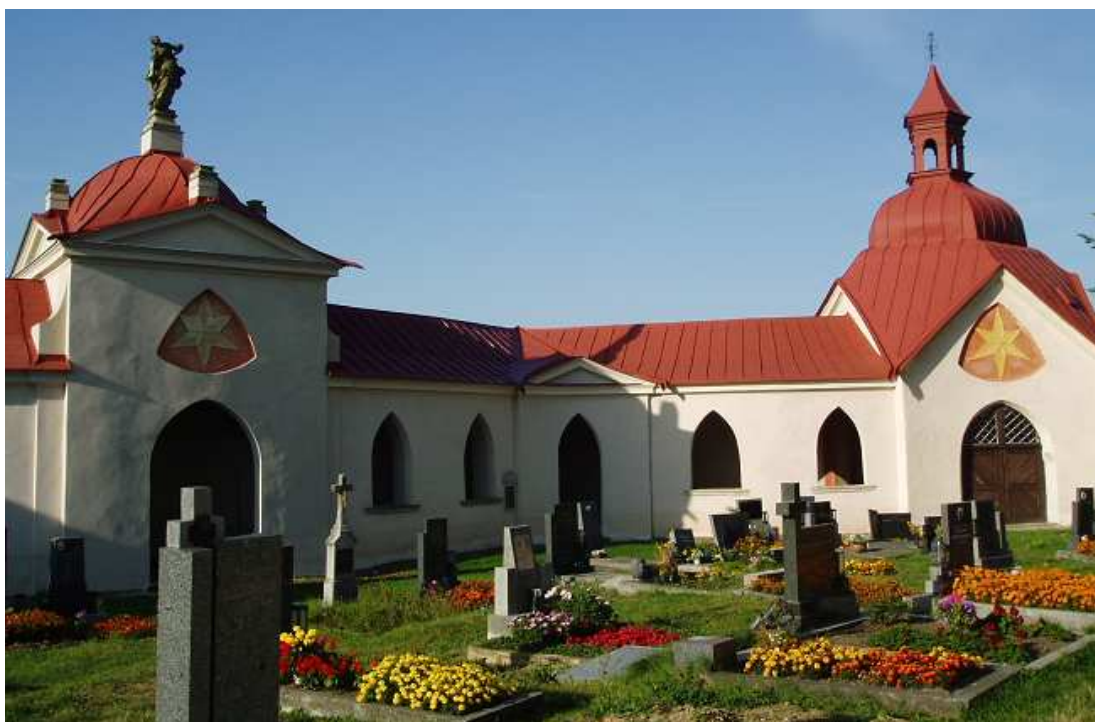
Obr. 29 – Kostel sv. Jana Nepomuckého - nádvoří kostela
