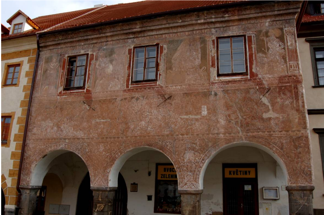
Obr. 85 Čelní fasáda č.p. 41 – Rumpálova domu
