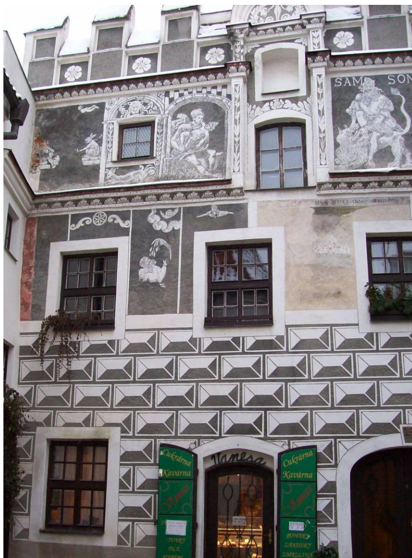
Obr. 42 Uliční fasáda domu č.p. 28, levá část
