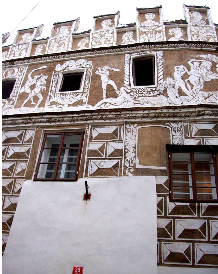
Obr. 57 Uliční fasáda č.p. 29 – školy (?), střední část
