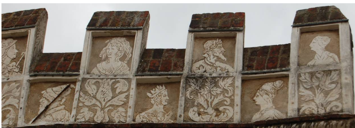
Obr. 71 Uliční fasáda č.p.29, cimbuří s hlavami, pravá část
