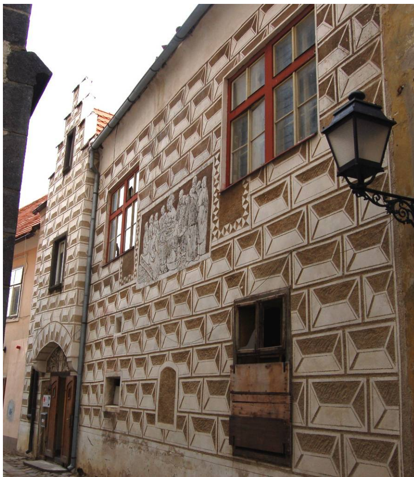
Obr. 78 Fasáda domu č.p. 33 – fary
