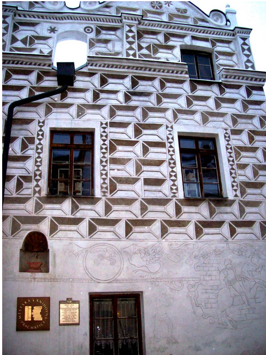
Obr. 102 Čelní fasáda č.p. 71 – Husova domu, pravá část
