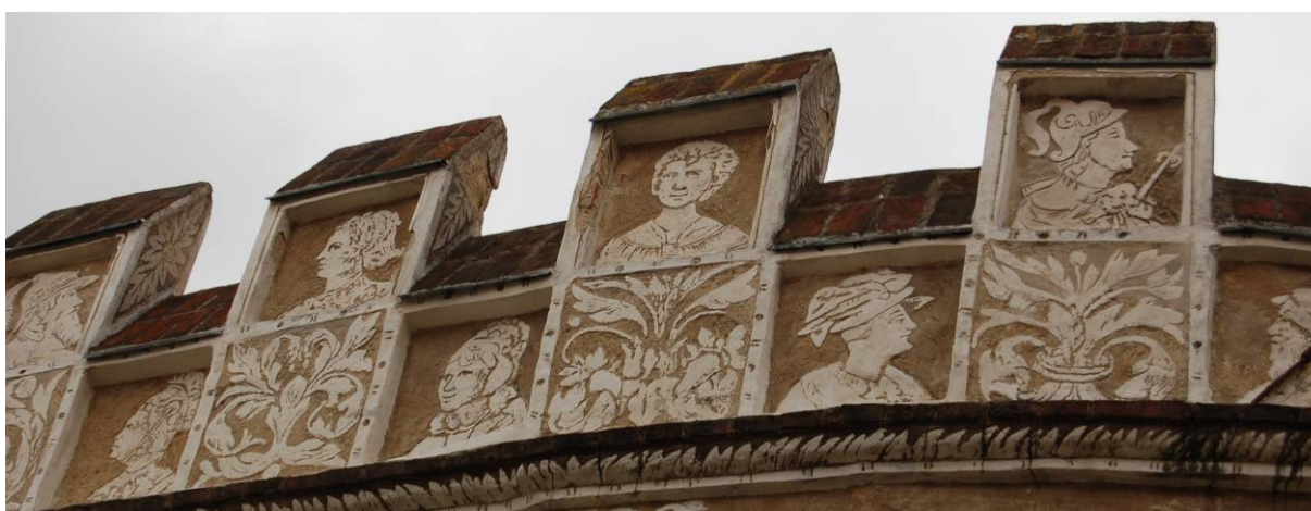
Obr. 70 Uliční fasáda č.p.29, cimbuří s hlavami, střední část
