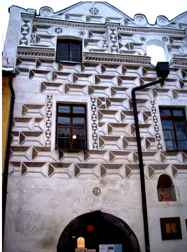
Obr. 101 Čelní fasáda č.p. 71 – Husova domu, levá část
