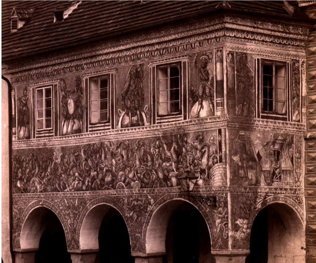
Obr. 87 Fasáda č.p. 41 – Rumpálova domu, starší nedatovaná fotografie
