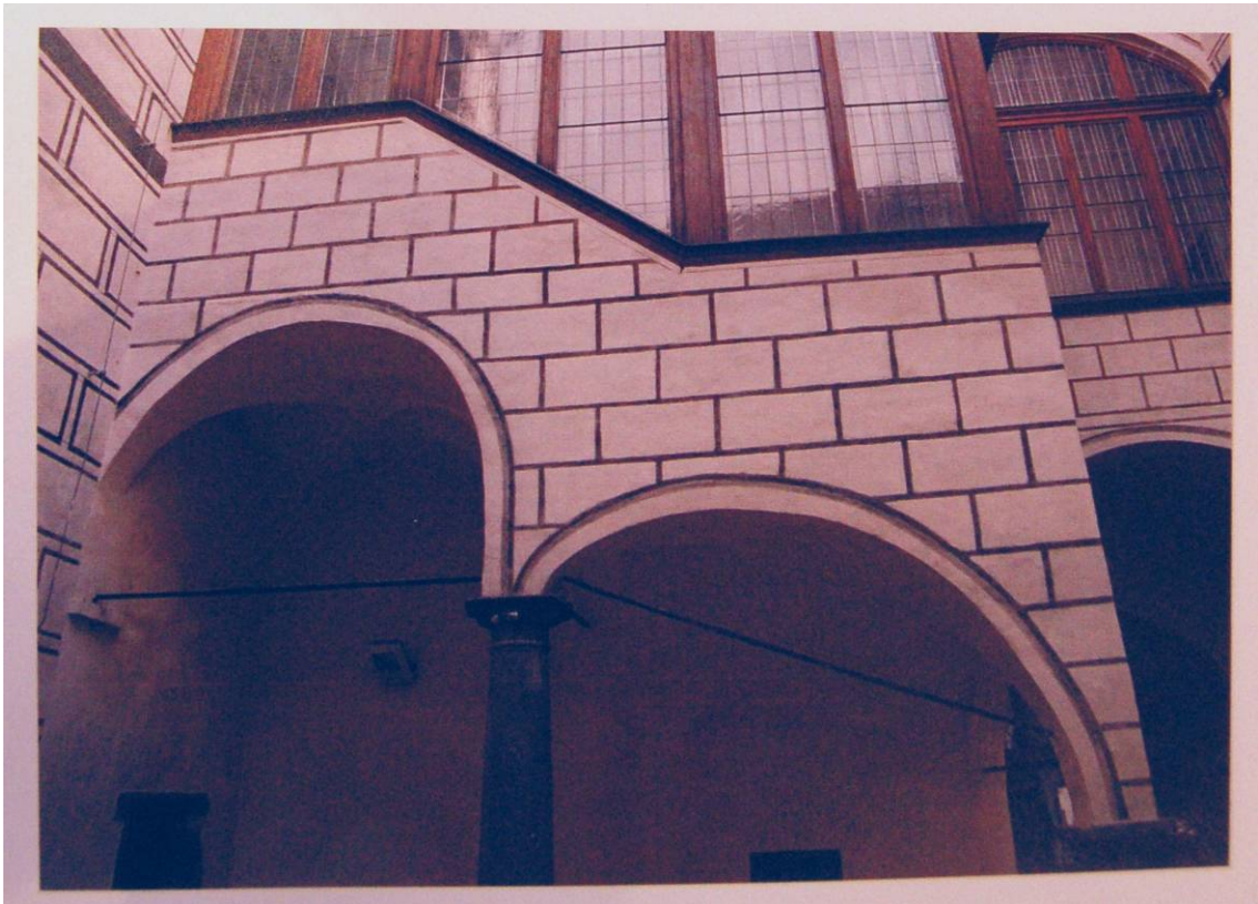
Obr. 1 Nádvoří fasáda č.p.1 – Staré radnice
