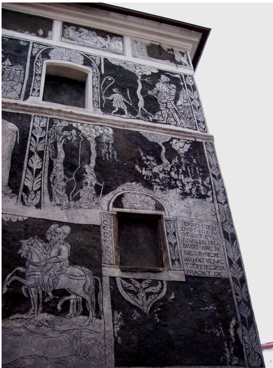
Obr. 4 Boční fasáda č.p. 9 – Knížecího domu, pravá část
