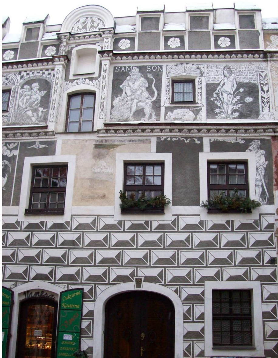
Obr. 43 Uliční fasáda domu č.p.28, pravá část
