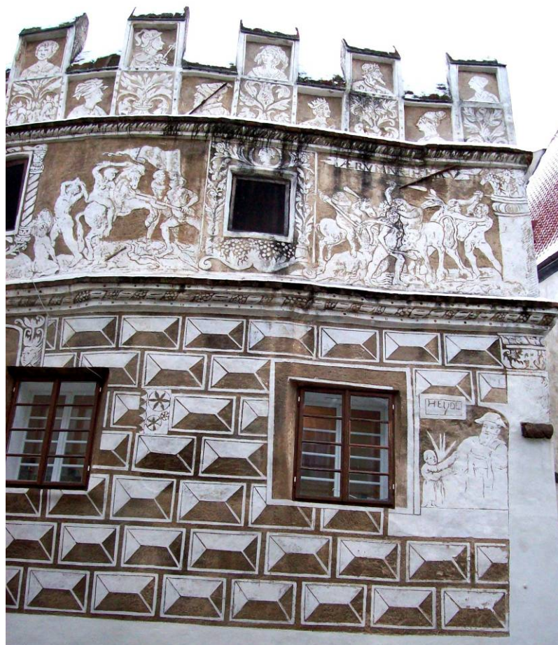
Obr. 58 Uliční fasáda č.p. 29 – školy (?), pravá část
