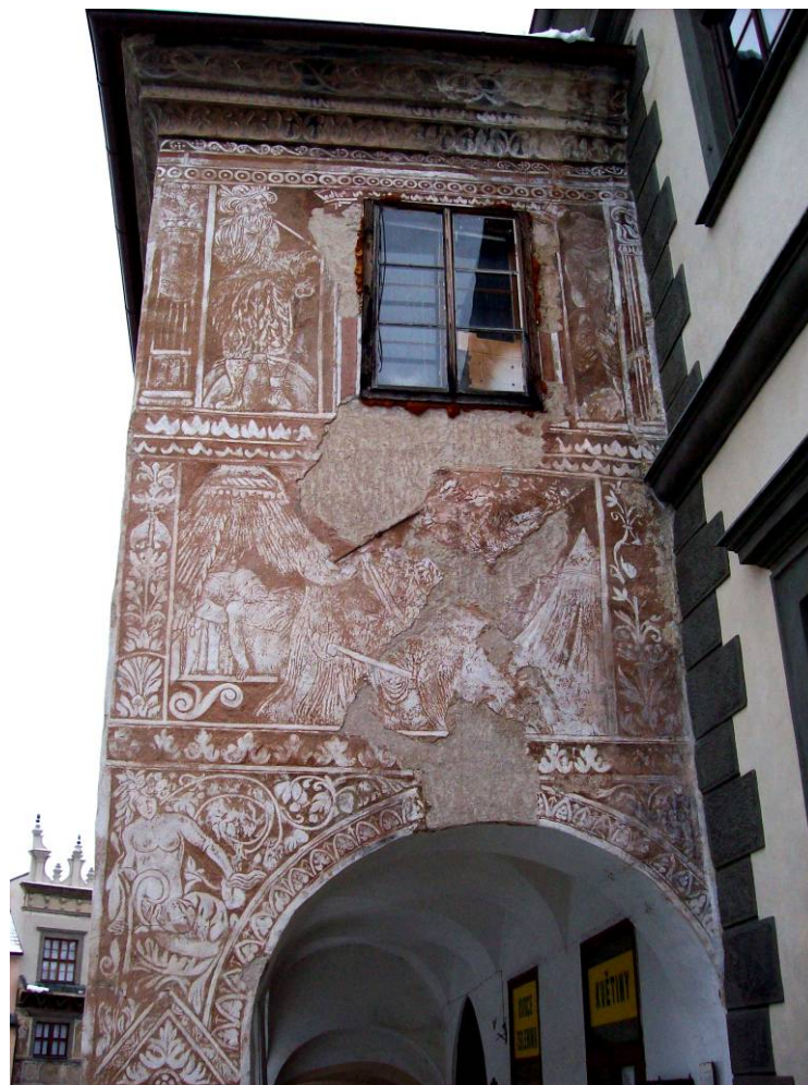
Obr. 86 Boční fasáda č.p. 41 – Rumpálova domu
