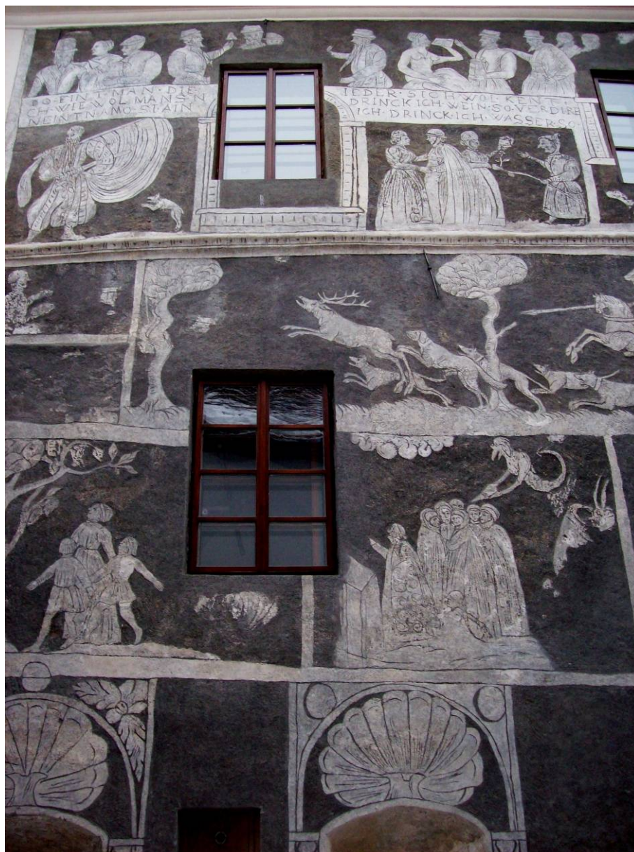
Obr. 2 Boční fasáda č.p. 9 – Knížecího domu, levá část
