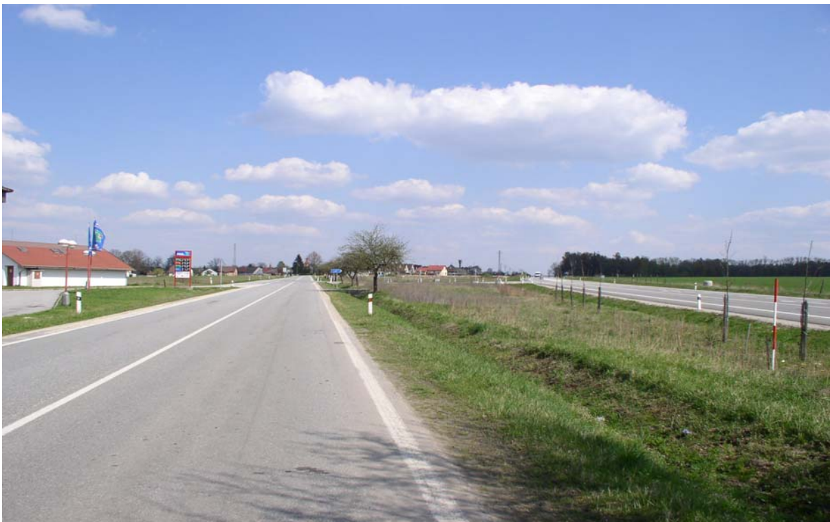
Obr. 6: Pohled na původní silnici I/34 od Třeboně. Vpravo nový obchvat, mezi nimi je patrná spojka v km 0,920. Vlevo je vidět objekt ČS a její poutač.
