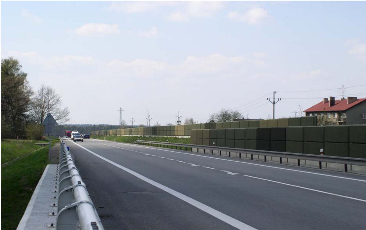
Obr. 5: Pohled na protihlukové stěny a obchvat z mostu přes cyklostezku.
