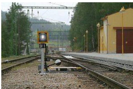
Obr. 13 – Samovratný přestavník Zdroj: [9]
