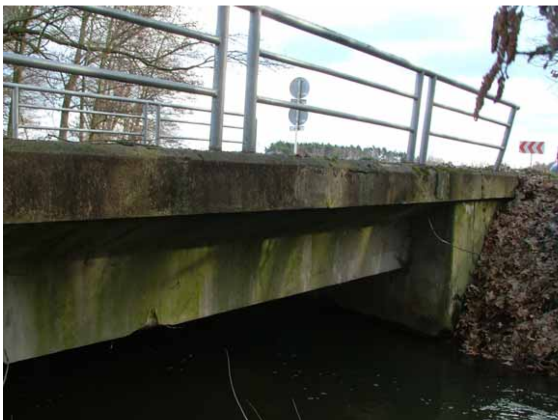
OBR. 21 – nosná konstrukce (pohled zprava od Lázní Bohdaneč)
