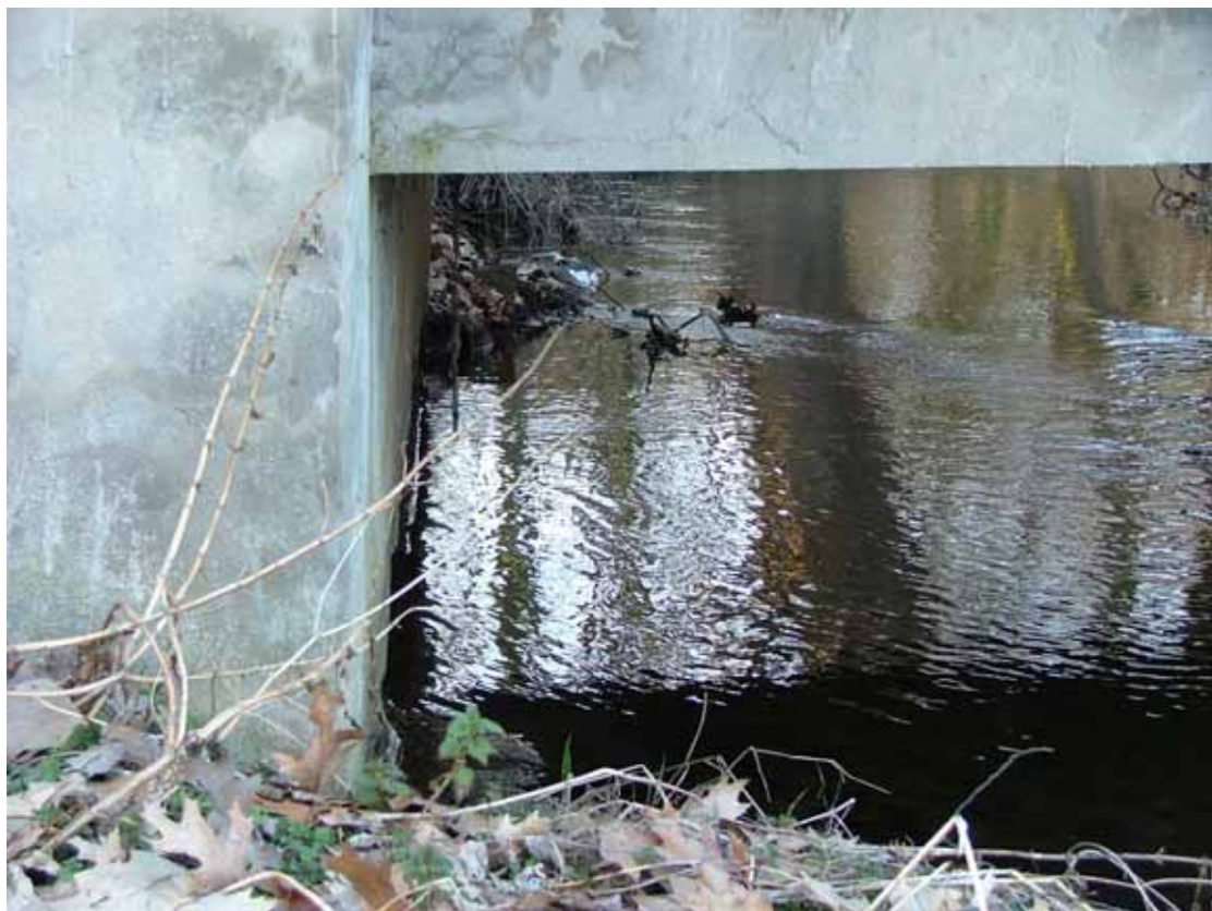
OBR. 6 – pohled pod mostem
