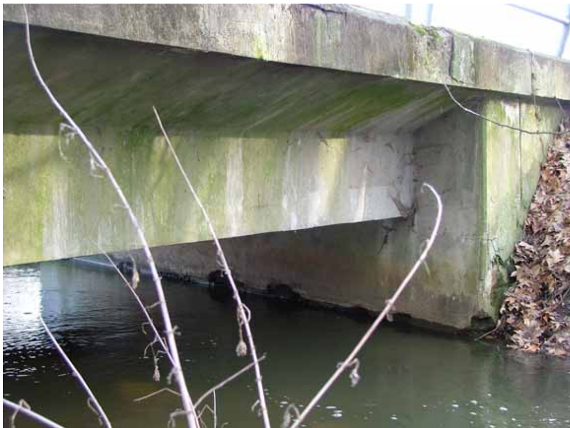
OBR. 18 – nosná konstrukce a opěra (pohled zprava od Lázní Bohdaneč)
