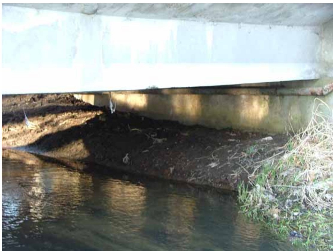
OBR. 5 – pohled pod mostem
