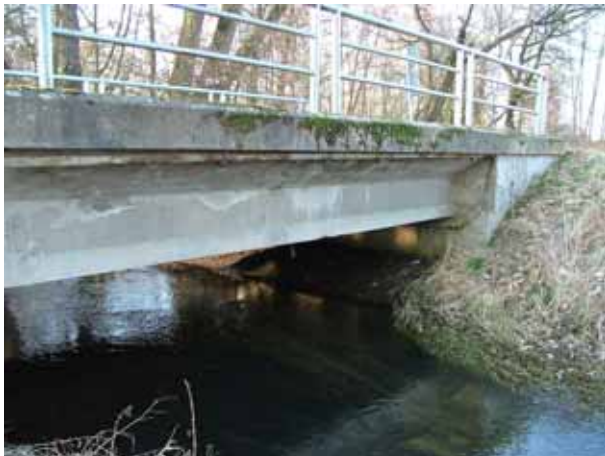
Obr. 7: Nosná konstrukce (pohled zprava, směrem od Černé u Bohdanče)
