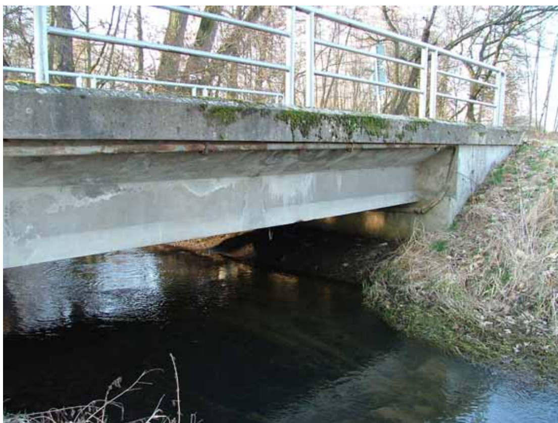
OBR. 3 – mostní objekt (pohled zprava od Černé u Bohdanče)
