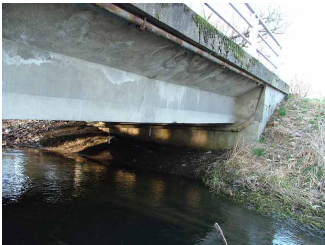
OBR. 9 – nosná konstrukce a opěra (pohled zprava od Černé u Bohdanče)
