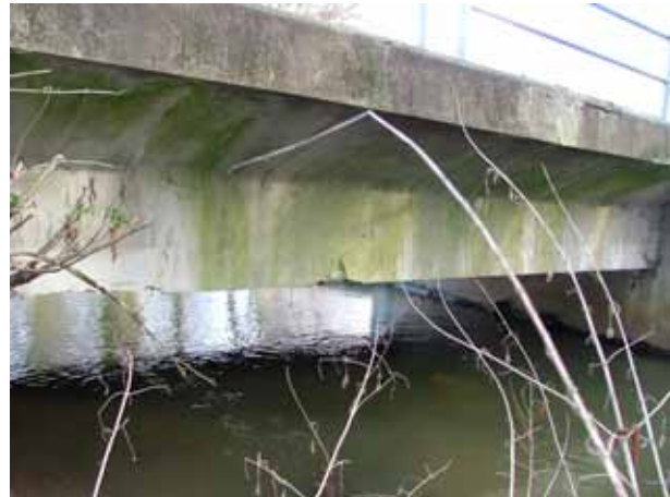
Obr. 8: Nosná konstrukce (pohled zprava, směrem od Lázní Bohdaneč)
