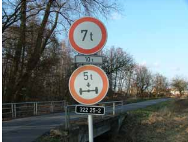
Obr. 6: Dopravní značení omezené nosnosti mostní konstrukce
