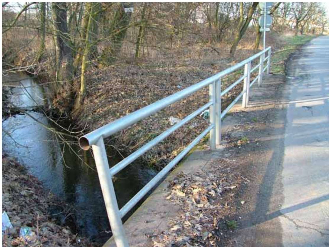
OBR. 10 – uříznuté zábradlí
