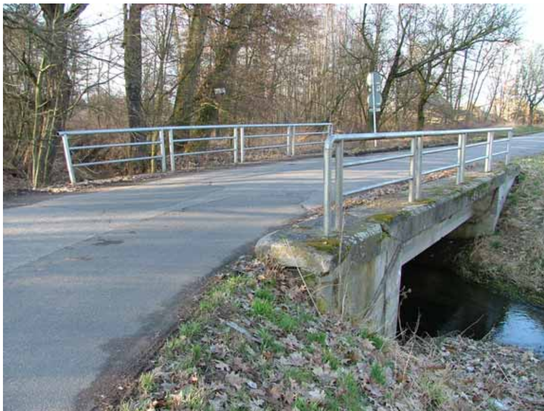
OBR. 2 – mostní objekt (pohled zprava od Černé u Bohdanče)
