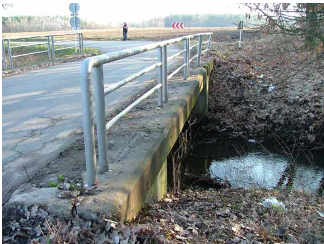
OBR. 11 – mostní objekt (pohled zprava od Lázní Bohdaneč)
