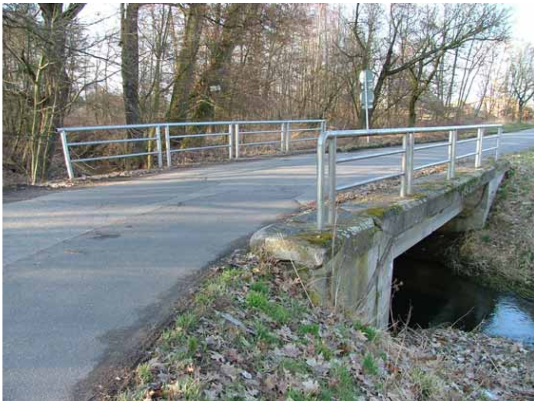
Obr. 9: Mostní zábradlí (pohled směrem od Černé u Bohdanče)
