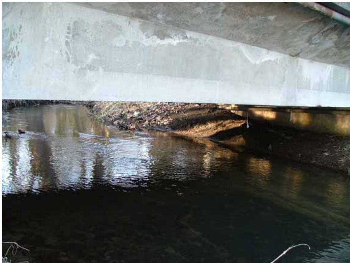
OBR. 8 – pohled pod mostem
