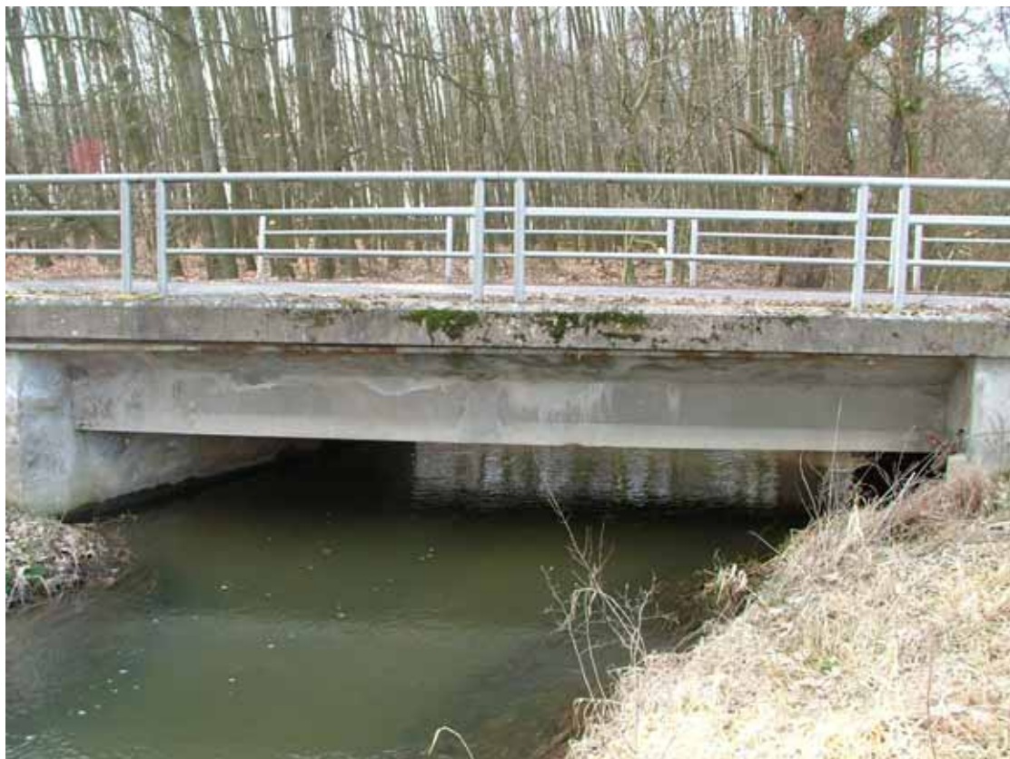
OBR. 16 –nosná konstrukce a opěra (pohled zleva od Lázně Bohdaneč)
