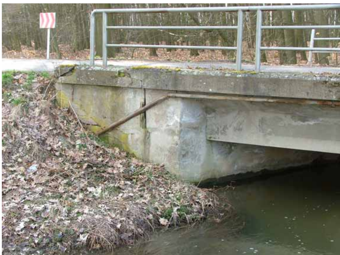
OBR. 17 –nosná konstrukce a opěra (pohled zleva od Lázně Bohdaneč)
