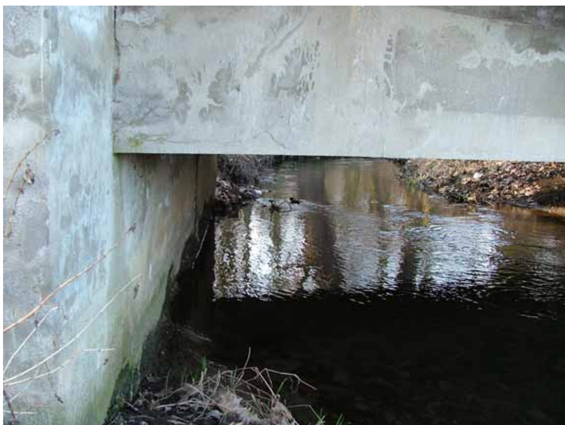
OBR. 7 – pohled pod mostem
