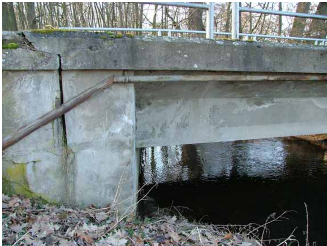
OBR. 4 – mostní opěra (pohled zprava od Černé u Bohdanče)
