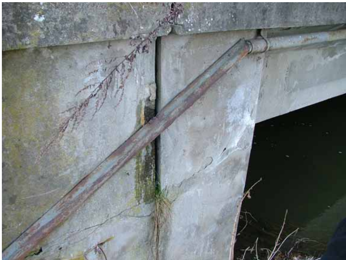
OBR. 14 – mostní opěra (pohled zprava od Černé u Bohdanče)
