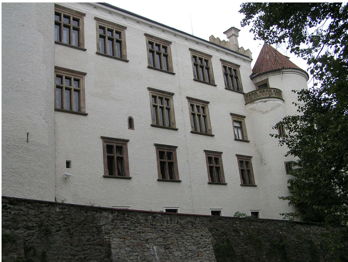
Obr.27 – severní fasáda zámku Konopiště
