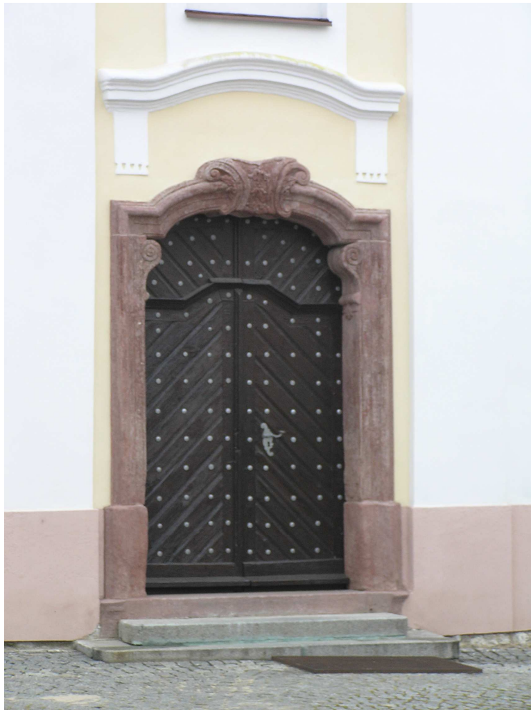
Obr.8 – vstupní portál do kostela sv. Bartoloměje v Divišově
