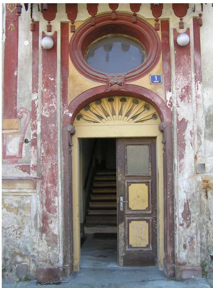
Obr 19 – vstupní portál do zámku v Kácově
