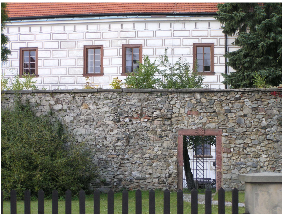
Obr.23 – ostění oken z červené arkózy na zámku v Komorním Hrádku
