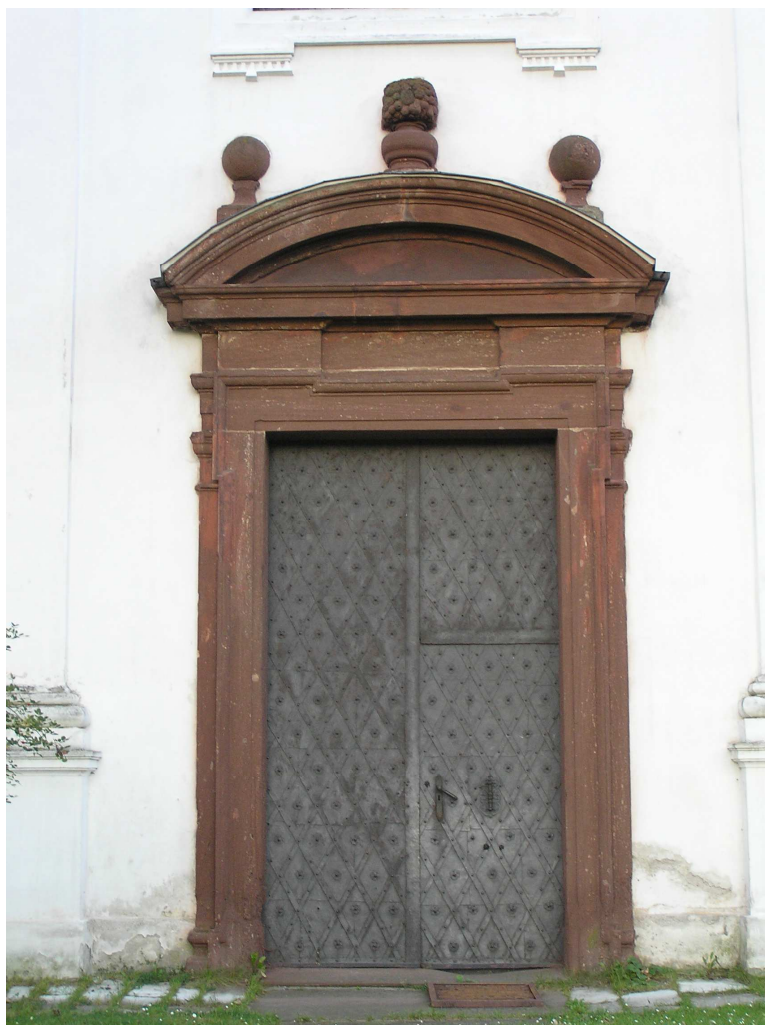
Obr.47 – vstupní portál do kostela sv. Matouše
